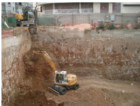
Imagen 5.2 – Excavación mecánica: Riesgo Caída de personas a diferente nivel.
