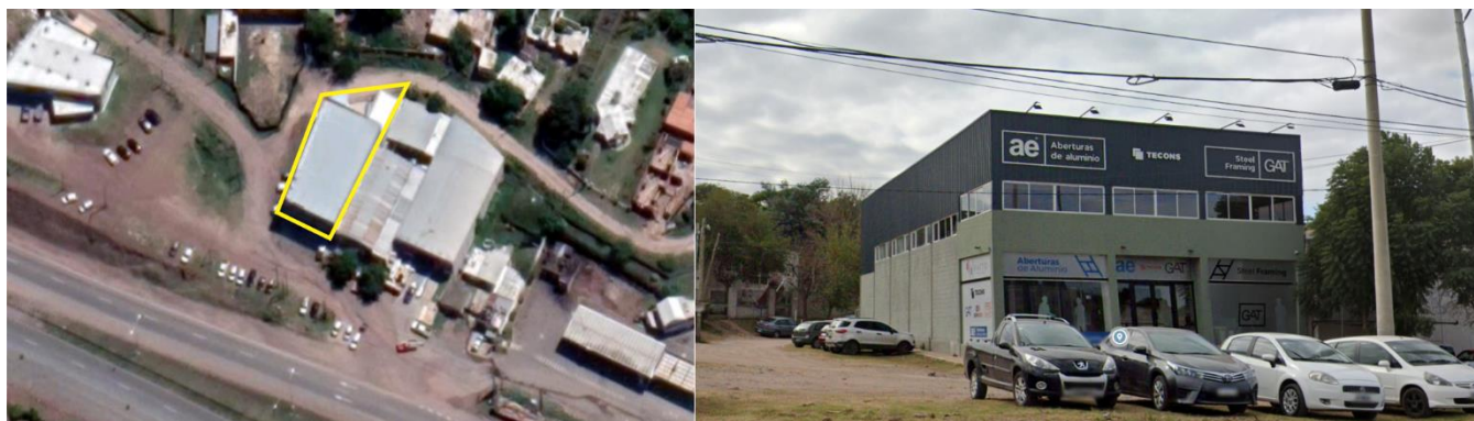
Imagen 1.3 – Vista aérea y frontal del edificio de la empresa.
