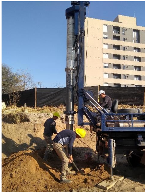
Figura 3.1.3 Excavación de prueba
