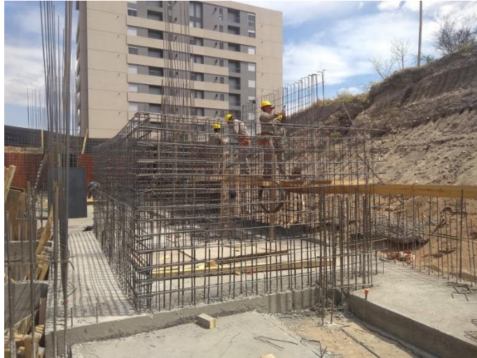
Figura 3.4.4.2 Armado laterales de cisterna
