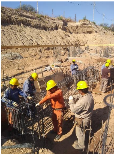
Figura 3.4.3.1 Cabezal de ascensor
