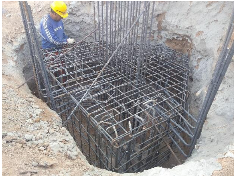
Figura 3.2.2.3 Armado de cabezales
