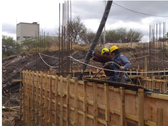
Figura 3.4.1.4 Hormigonado muro perimetral
