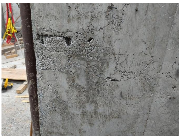
Figura 3.5.1 Terminaciones que requieren curado
