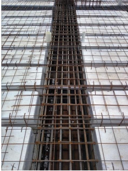
Figura 3.4.6.4 Armado de losa
