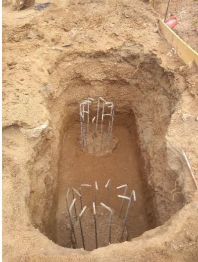
Figura 3.3.2.1 Excavación de cabezal
