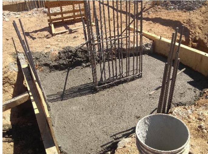
Figura 3.3.2.4 Hormigonado de cabezal
