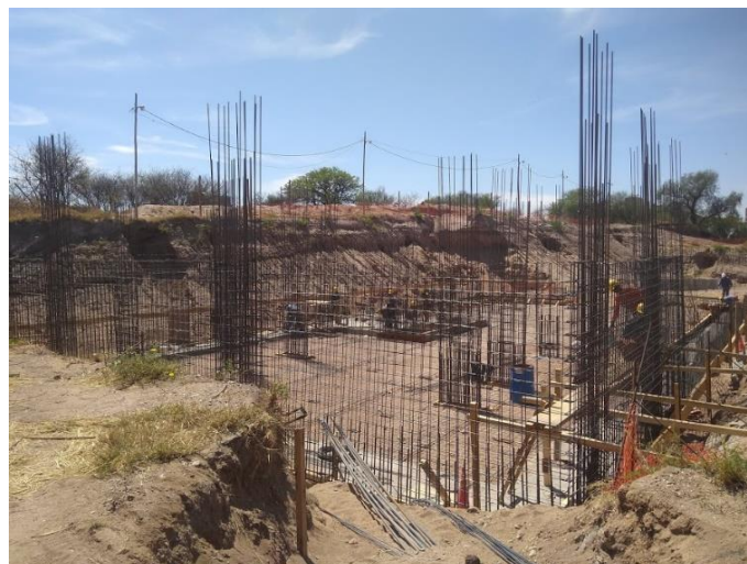
Figura 3.4.1.3 Armadura muro perimetral
