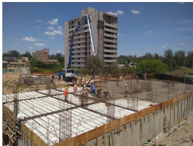
Figura 3.4.6.6 Llenado de losa
