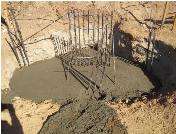
Figura 3.3.2.6 Solución de cabezal
