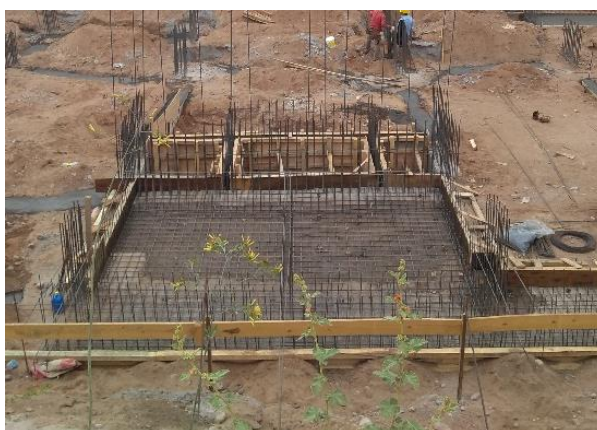
Figura 3.4.4.1 Armado platea Cisterna
