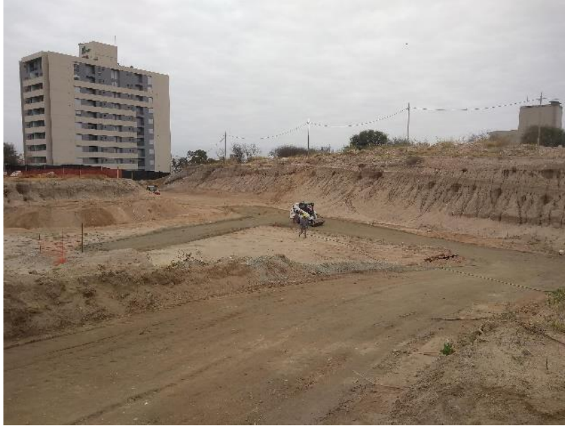
Figura 3.1.2 Mejoramiento de rampa
