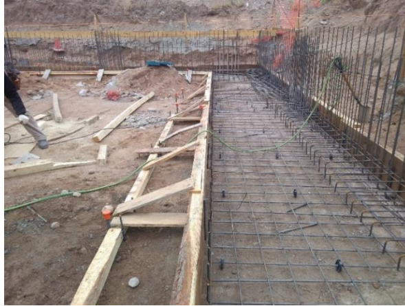
Figura 3.4.1.1 Armado de zapata MP1
