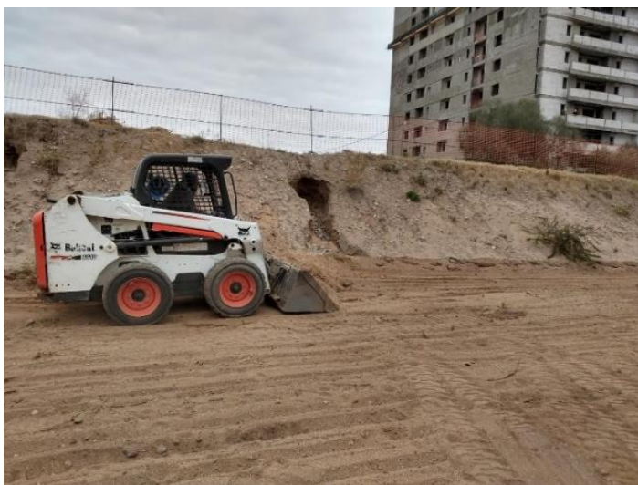
Figura 3.1.1 Limpieza de terreno
