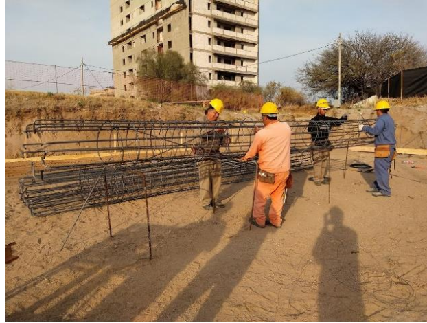
Figura 3.3.1.4 Armadura de pilotes
