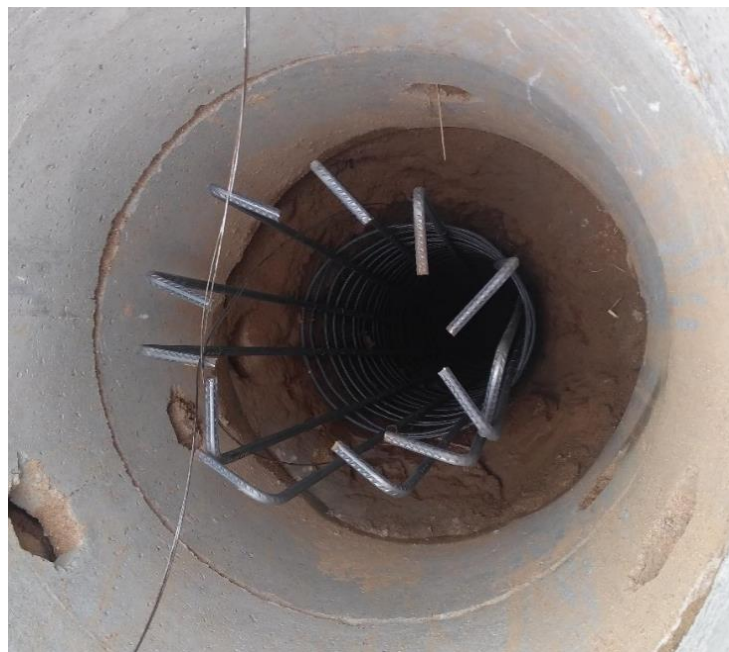
Figura 3.3.1.5 Colocación de armadura
