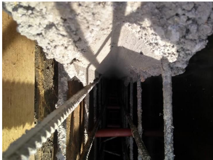
Figura 3.4.1.5 Diente en muro perimetral
