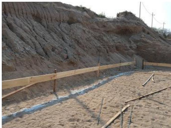
Figura 3.2.2 Cerco de replanteo
