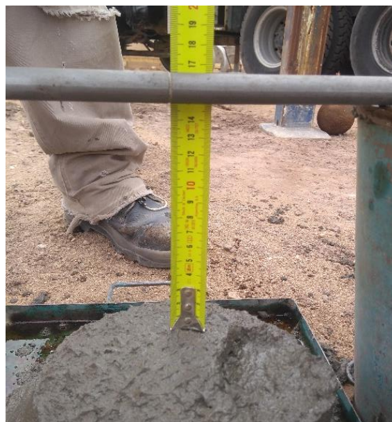
Figura 3.3.2.5 Control de asentamiento
