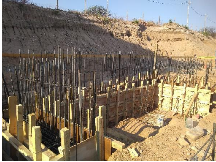
Figura 3.4.3.2 Encofrado tabique
