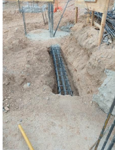
Figura 3.3.2.2 Armadura viga riostra
