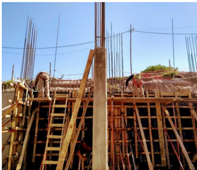
Figura 3.4.3.4 Encofrado y llenado tabique
