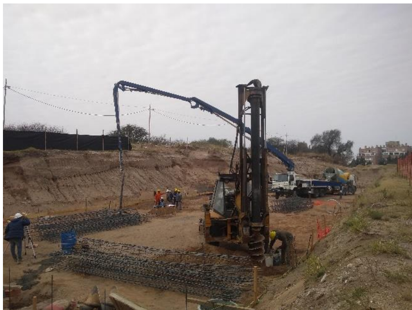
Figura 3.3.1.6 Hormigonado pilotes
