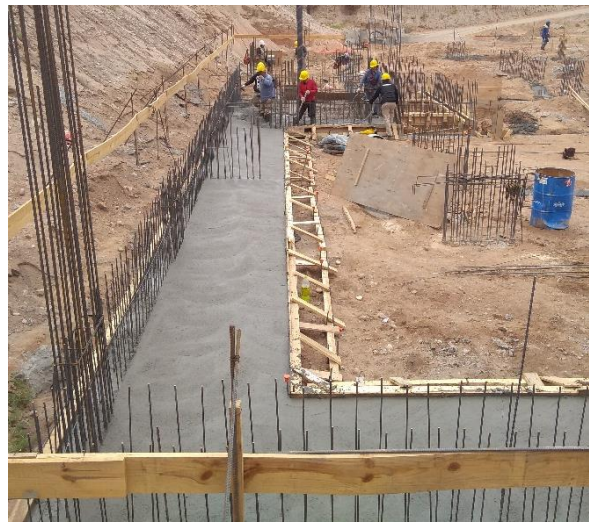
Figura 3.4.1.2 Hormigonado Zapata MP1
