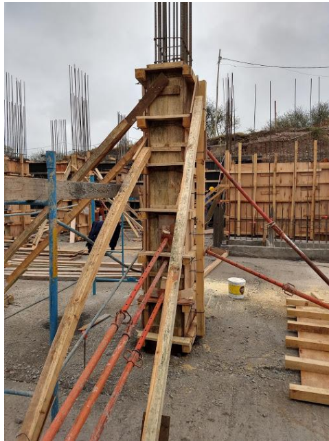
Figura 3.4.5.1 Encofrado de columna
