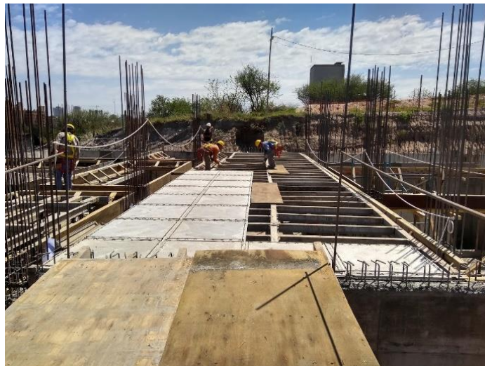
Figura 3.4.6.3 Placa de hormigón
