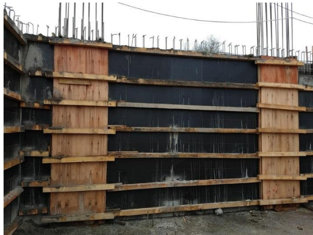
Figura 3.4.5.2 Columnas en el muro perimetral
