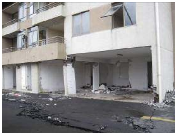
a: Vista general fachada Oeste
