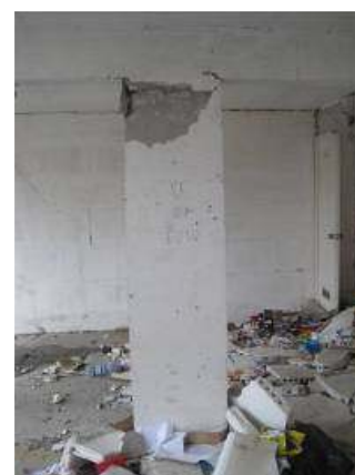
c: Vista general muro Eje U - 27
