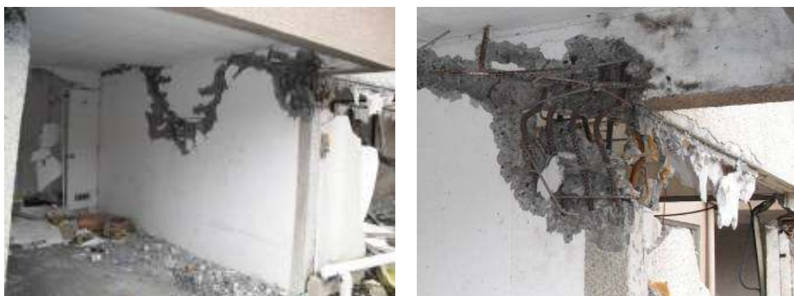
a: Vista general muro Eje P
