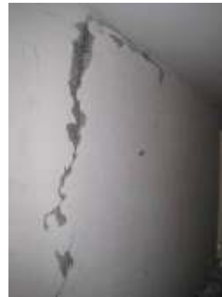
b: Muro Eje 29 entre Ejes P y Q.
