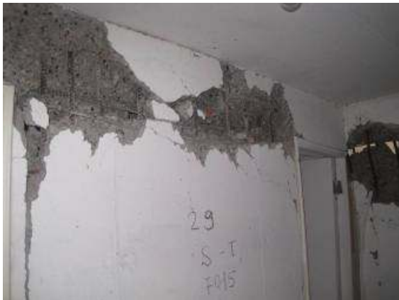
a: Muro Eje 29 entre Ejes S y T.
