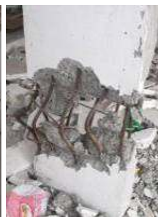
c: Muro corto interior.
