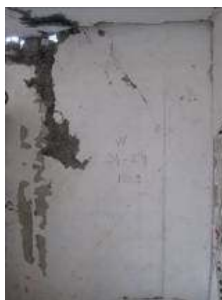
b: Muro eje W entre eje 29 y 31 (vista interior)
