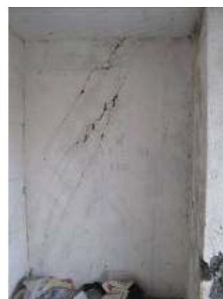
c: Muro eje W entre eje 27 y 5 (vista interior)
