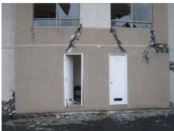
a: Vista general de muros en eje W (vista exterior)
