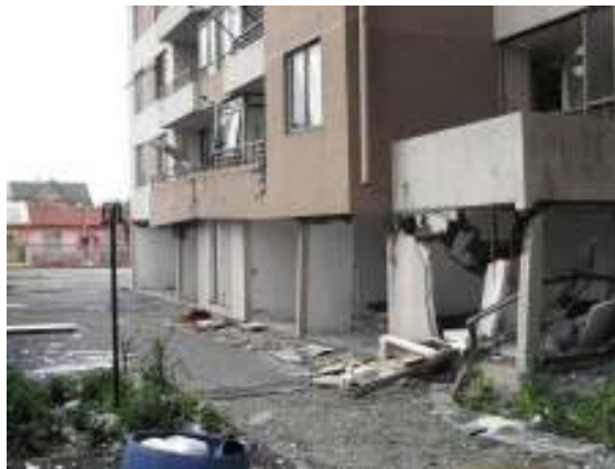
Figura 9: Vista General Fachada Este.
