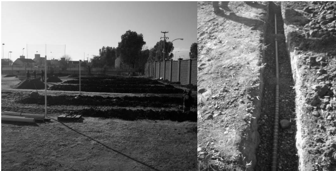
Figura 5. Materialización del sistema de riego
