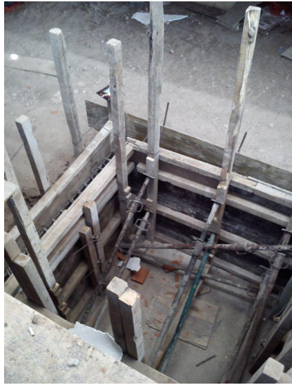
Fig. 3.40. Encofrado de la estructura del ascensor
