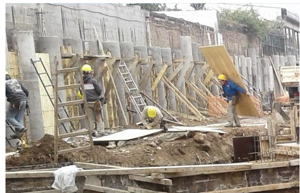
Fig. 3.7. Encofrado de tabiques entre pilotines.
