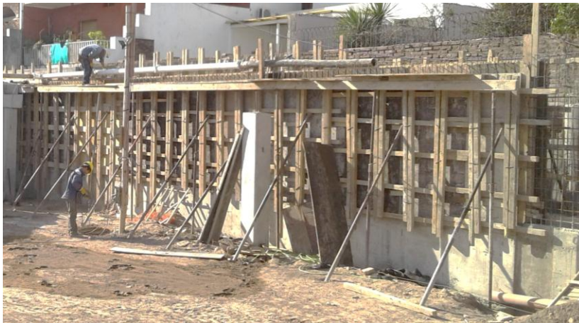
Fig. 3.32. Encofrado y colado de hormigón de los tabiques perimetrales.
