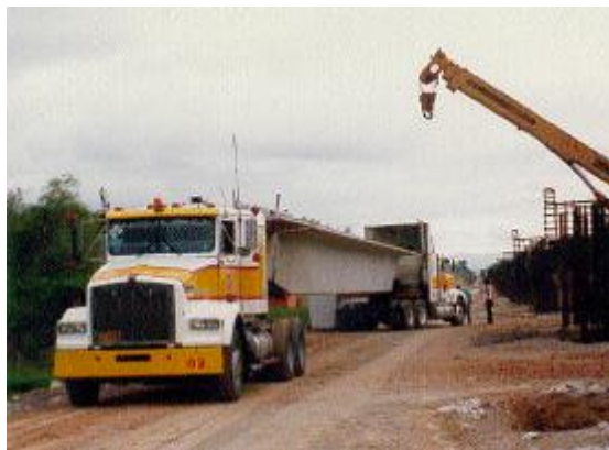
Fig. 2.12 Maniobra “espalda con espalda”.
