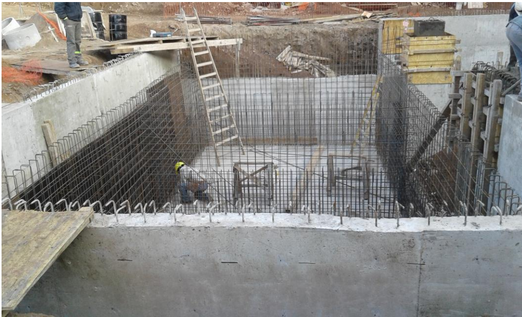
Fig. 3.20 Armaduras de los tabiques del tanque de agua para incendio
