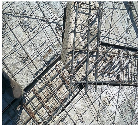
Fig. 4.18 Detalle de unión de armaduras en paneles y vigas
