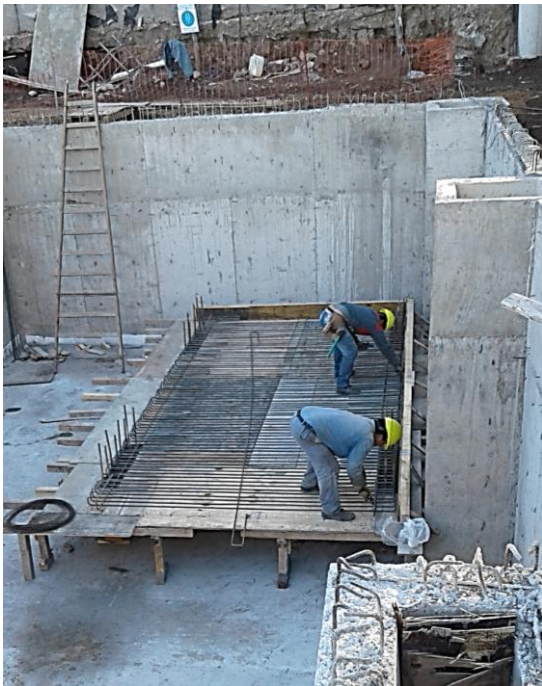
Fig. 3.23. Encofrado de losa de fondo del tanque de reserva de agua para incendio.
