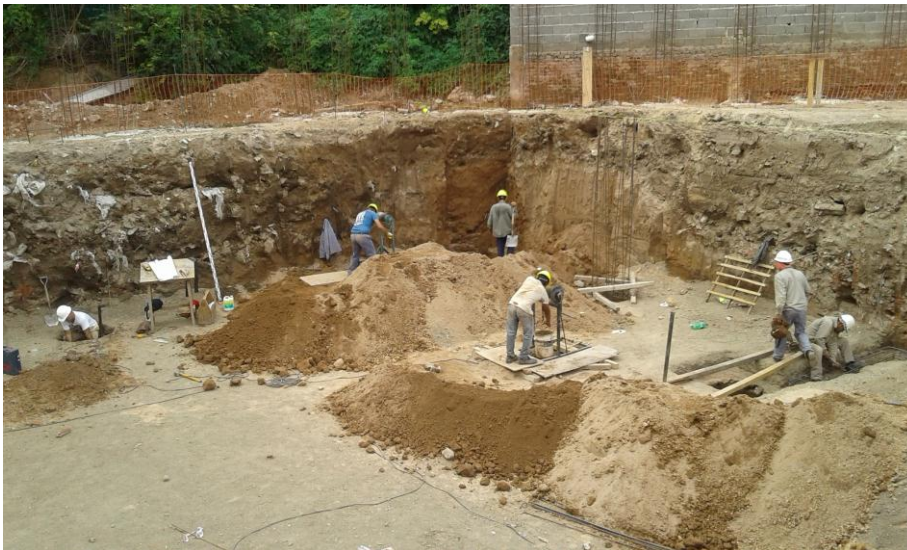
Fig. 3.11. Excavación de pilotes de segundo subsuelo.
