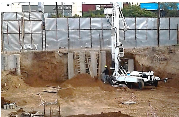
Fig. 3.6. Excavación de pilotines.
