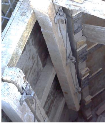
Fig. 3.30. Encofrado cara interior de los tabiques perimetrales
