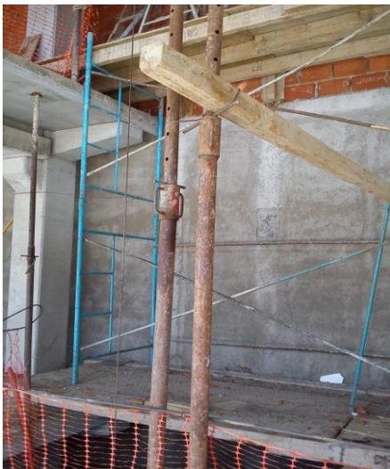
Fig. 4.22 Andamio para levantamiento de mampostería encadenada
