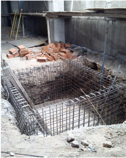
Fig. 3.39. Armadura de la estructura del ascensor.
