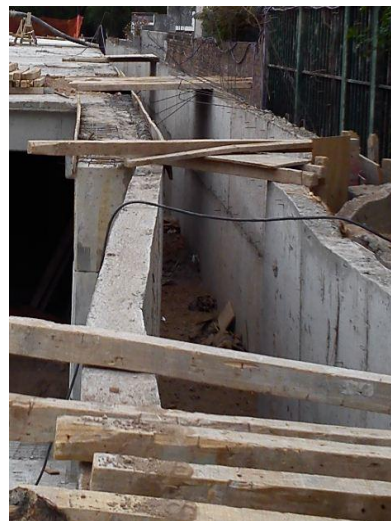
Fig. 3.37. Desagüe pluvial terminado.
