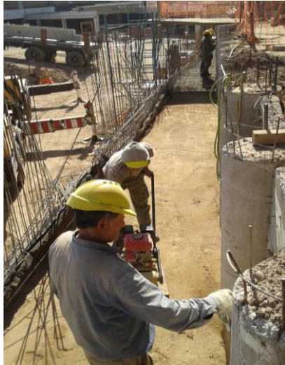
Fig. 3.34. Compactado de la base de asiento del desagüe pluvial
