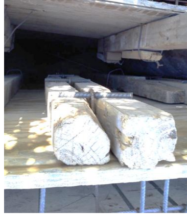
Fig. 3.31. Encofrado cara exterior de los tabiques perimetrales.
