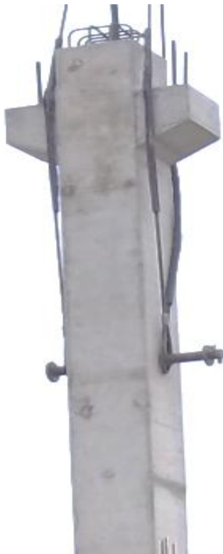
Fig. 4.8 Izaje de columna
