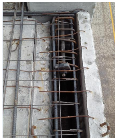
Fig. 4.21 Detalle de unión previo hormigonar
