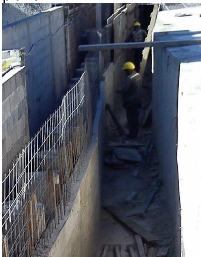
Fig. 3.36. Atado de la armadura del desagüe pluvial
