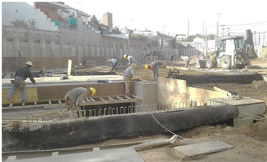
Fig. 3.18. Encofrado de la losa del segundo subsuelo.
