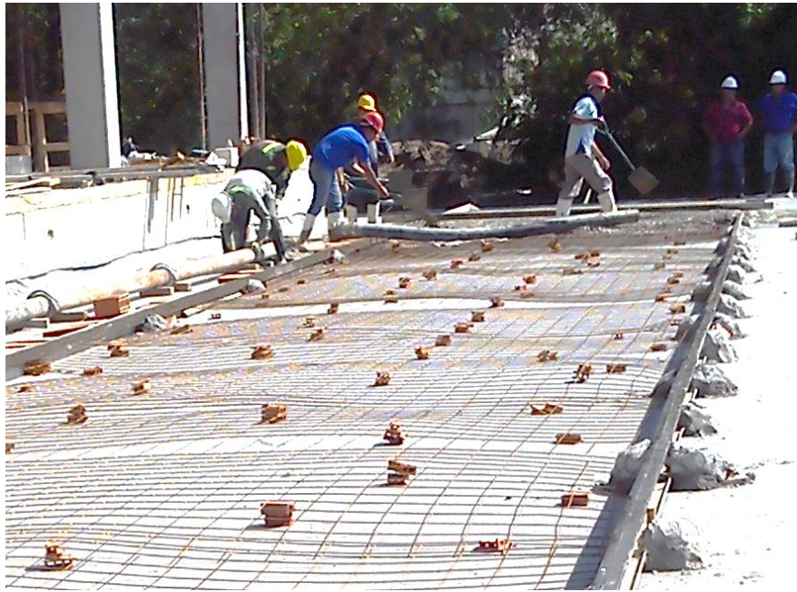
Fig. 4.24 Pavimento rígido planta baja, llenado de hormigón.
