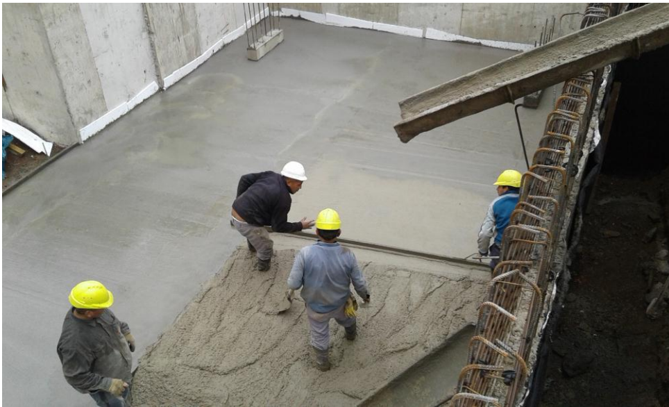
Fig. 3.25. Construcción del piso de hormigón armado de segundo subsuelo.
