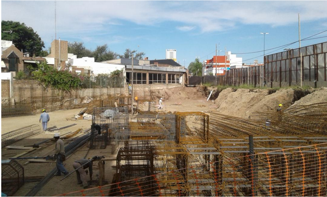
Fig. 3.2. Vista panorámica del obrador.
