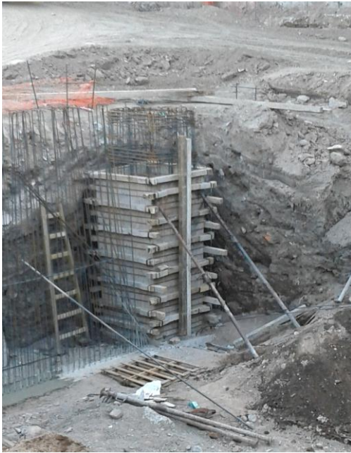
Fig. 3.16. Encofrado de los cabezales.
