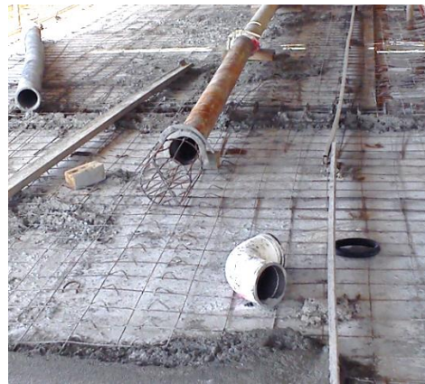
Fig. 2.7 Verificación del conducto
