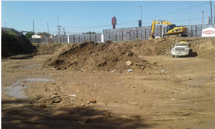
Fig. 3.3. Excavación del primer subsuelo.
