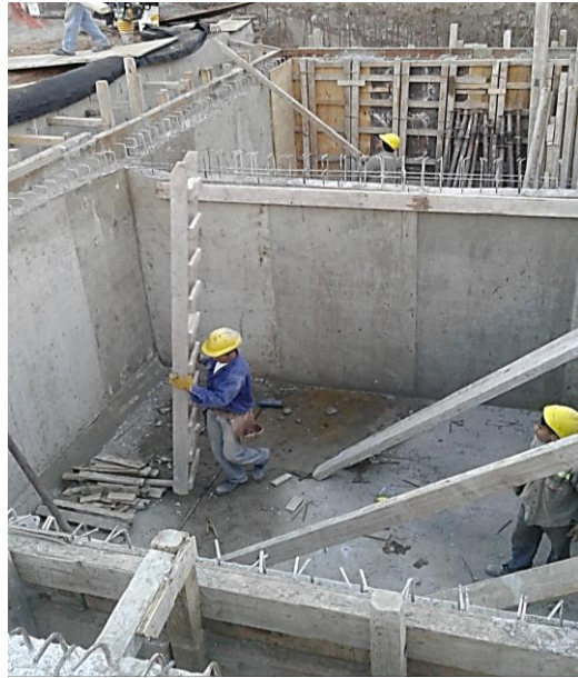
Fig. 3.22 Encofrado de la losa tapa del tanque de agua de reserva para incendio.
