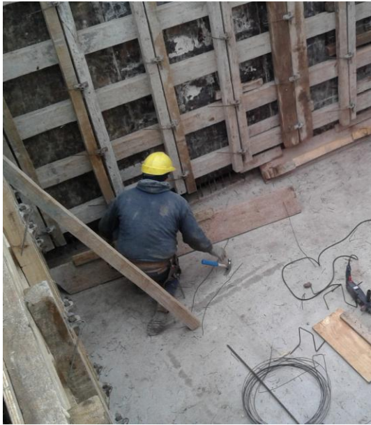
Fig. 3.21. Encofrado de tabiques del tanque de agua de reserva para incendio.
