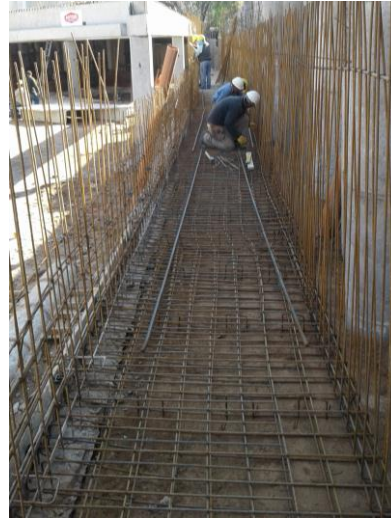
Fig. 3.35. Armado de la base asiento del desagüe pluvial.
