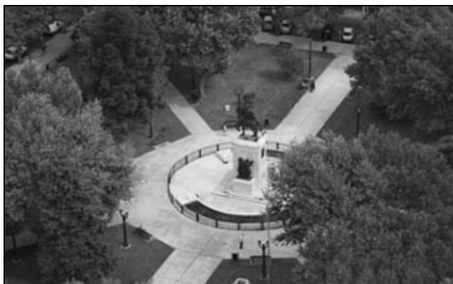
Figura 1 Vista aérea de la Plaza San Martín
