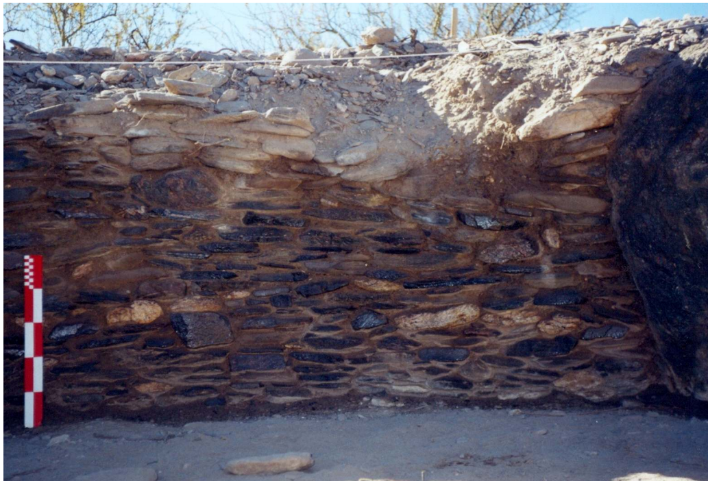
Figura 16. Rincón Chico 8 – Estructura 2. Detalle de muro interno.
