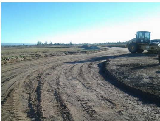
Ilustración 5.8 - Trabajos sobre la rotonda
