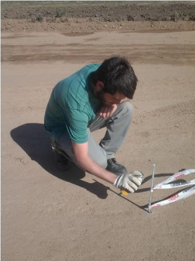
Ilustración 5.10 - Replanteo de alumbrado público
