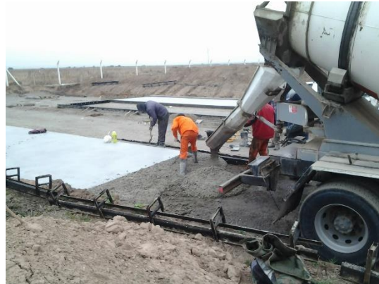
Ilustración 4.12 - Colocación del hormigón fresco
