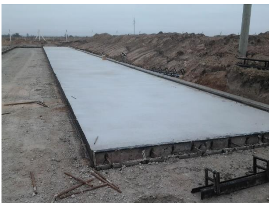
Ilustración 4.13 - Hormigón colocado sin desmoldar
