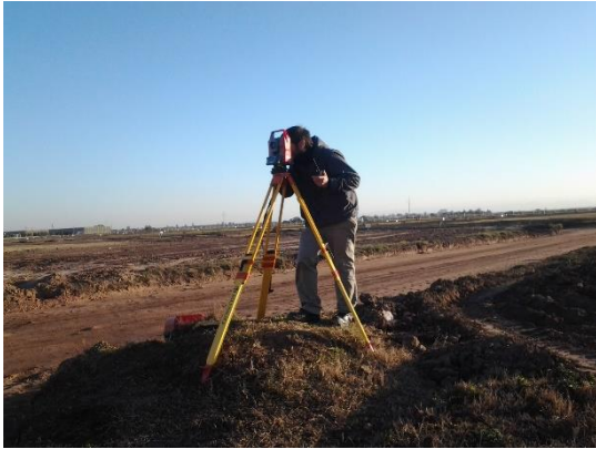
Ilustración 5.6 - Replanteo con estación total
