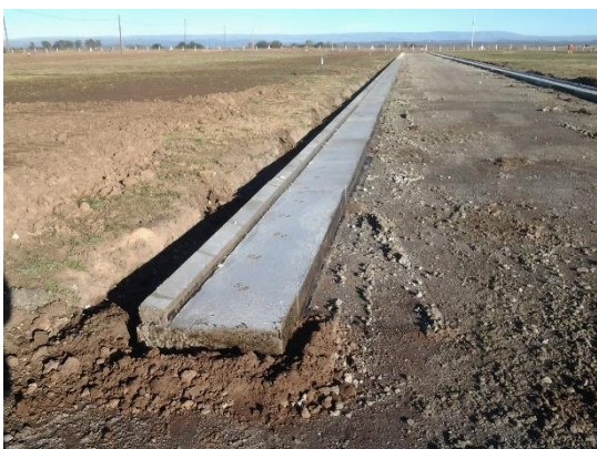
Ilustración 4.20 - Cordón cuneta recién desmoldado
