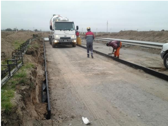
Ilustración 4.11 - Moldes para la pavimentación
