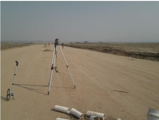
Ilustración 4.29 - Verificación de niveles
