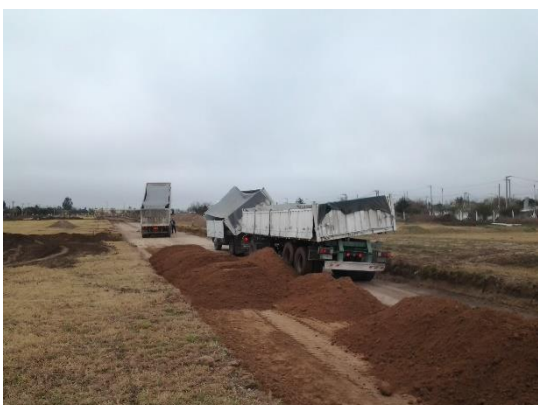
Ilustración 4.9 - Descarga de suelo arena
