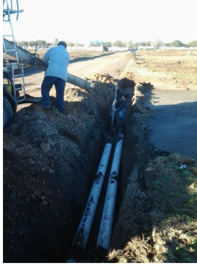
Ilustración 4.23 - Colocación del hormigón fresco
