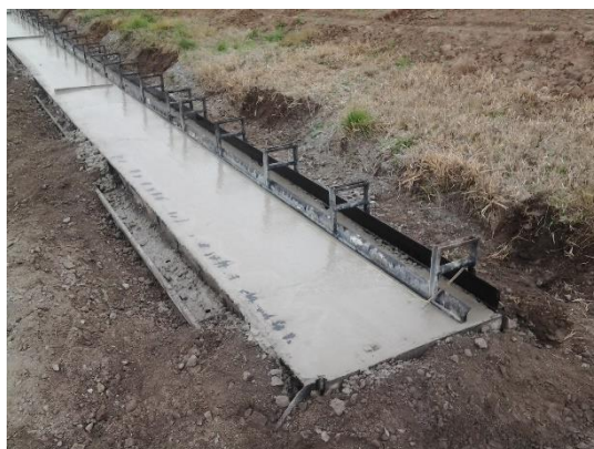
Ilustración 4.21 - Cordón cuneta sin desmoldar
