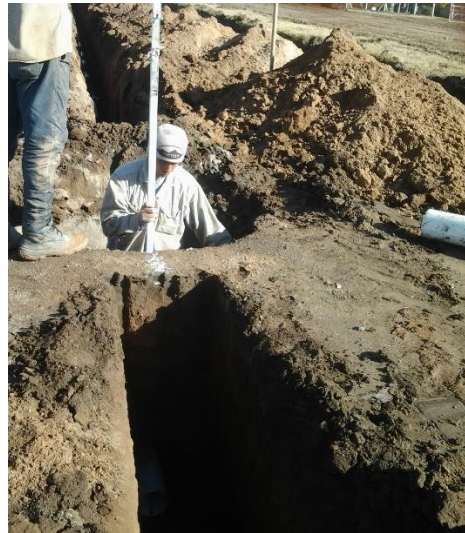
Ilustración 5.2 - Regla para el control de red cloacal
