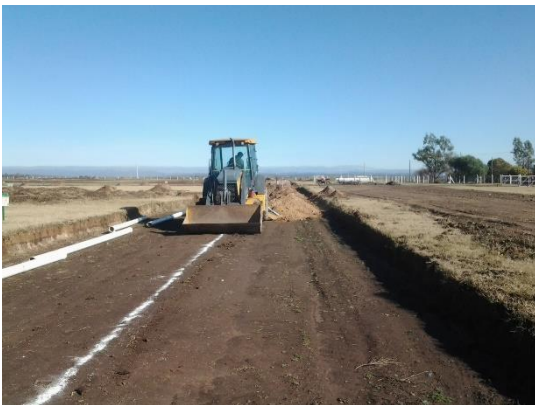
Ilustración 4.3 - Demarcación red cloacal
