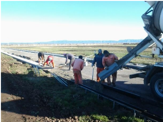
Ilustración 4.18 - Colocación del hormigón fresco
