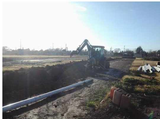
Ilustración 4.4 - Apertura de zanjas
