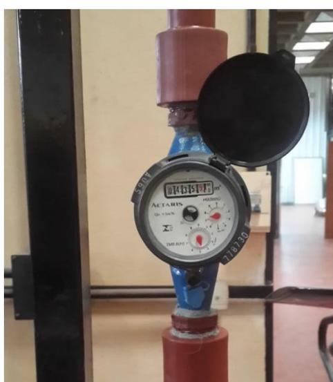
Figura 4: Caudalímetro mecánico
