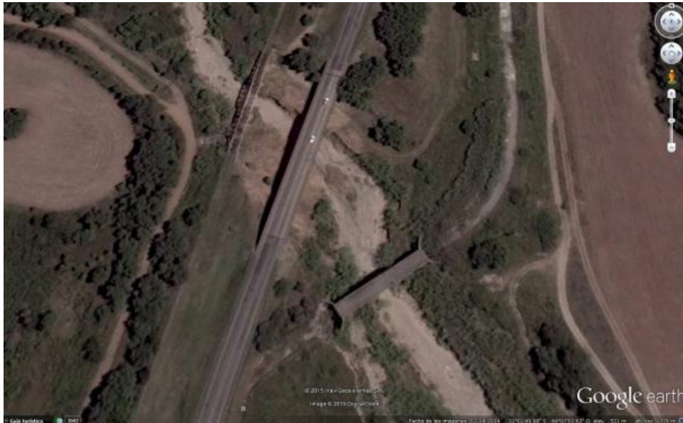
Figura 1.1. Imagen satelital con ubicación del puente sobre el Río Carnero en la RN9
