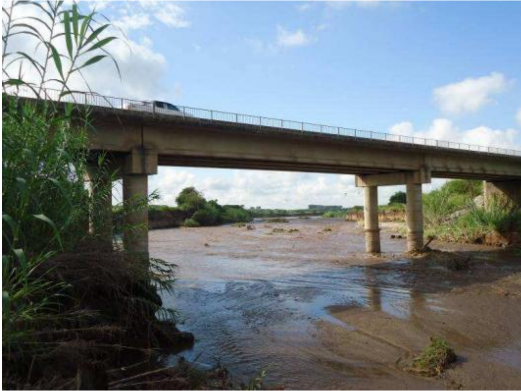
Figura 1.2. Vista general del Puente sobre el Río Carnero
