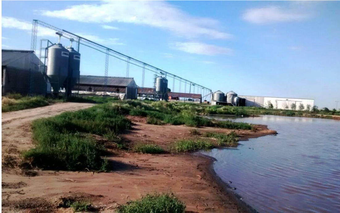
Figura 14: Lagunas de almacenamiento de los efluentes del criadero
