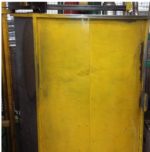
FIGURA 49: BARRERA FÍSICA PARA IMPEDIR INGRESO DE CORRIENTE DE AIRE
