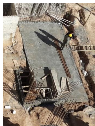
Figura 4.3.20-Losa finalizada
