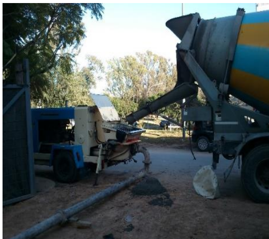
Figura 4.3.9-Hormigón bombeado
