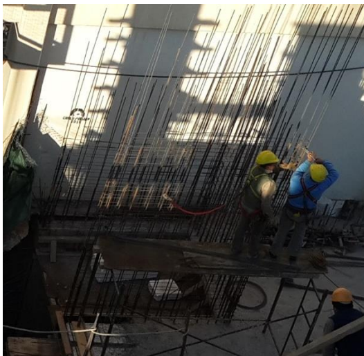
Figura 4.3.72-Armado del tabique
