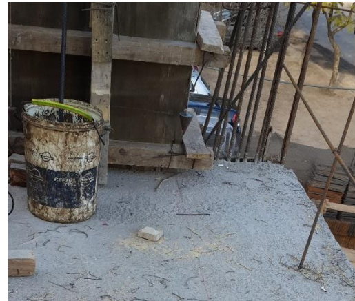
Figura 4.3.61-Demarcación de ejes sobre losa
