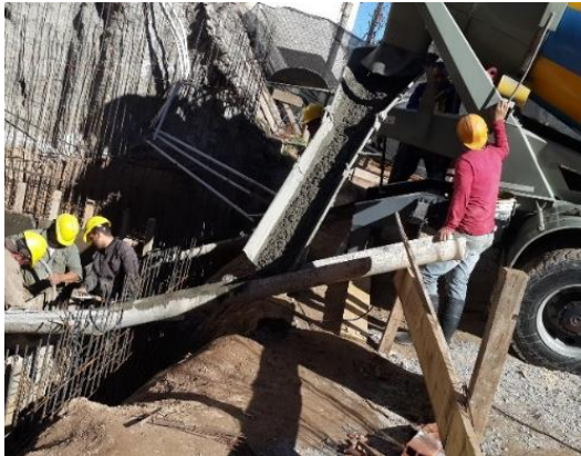
Figura 4.3.7-Hormigonado mediante camión mezclador
