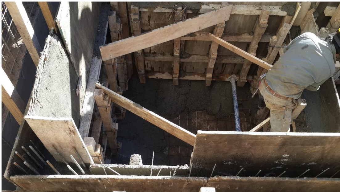
Figura 4.3.16-Hormigonado de cisterna
