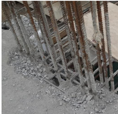
Figura 4.3.63-Picado de columna
