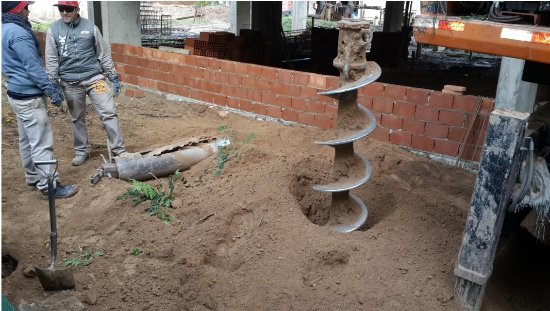
Figura 4.1.1-Ejecución del pozo para un pilote
