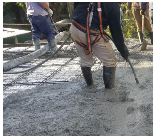
Figura 4.3.10-Vibrado durante el hormigonado de una losa
