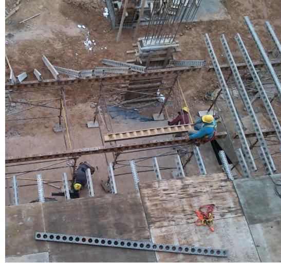
Figura 4.3.42-Vista aérea del encofrado de losa
