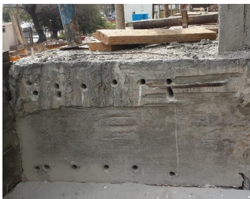
Figura 4.3.53-Perforaciones para anclaje químico
