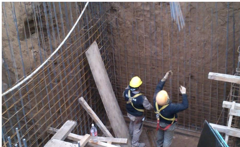
Figura 4.3.11-Proceso de armado del tabique del recinto
