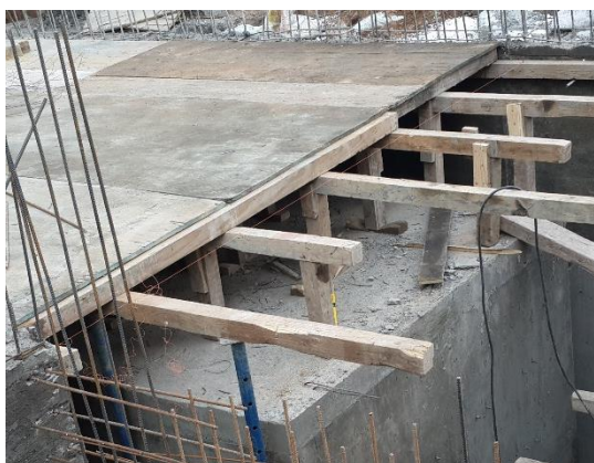
Figura 4.3.18-Encofrado de la losa del recinto
