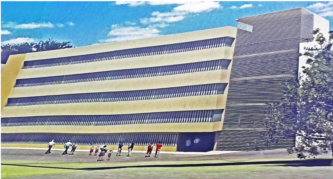
Figura 2.2.2-Aspecto terminado del edificio
