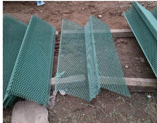
Figura 4.2.2-Acopia de piezas metálicas
