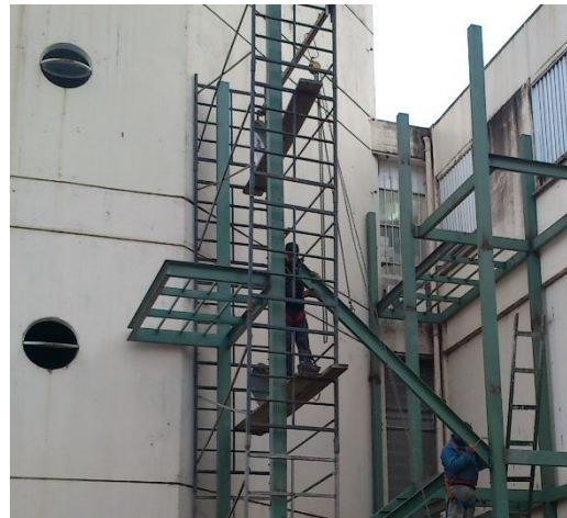
Figura 4.2.4-Izado de un perfil
