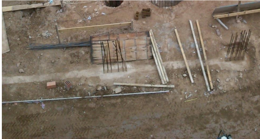
Figura 4.3.24-Limpieza sobre el terreno
