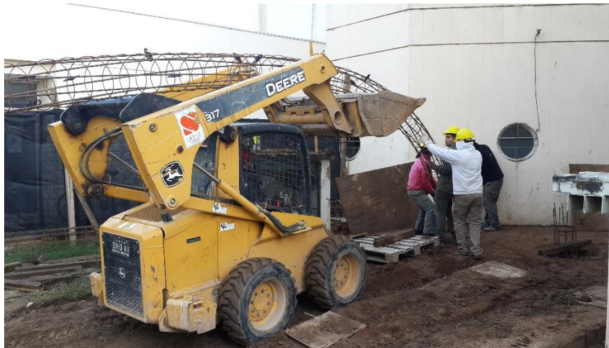
Figura 4.1.2-Colocación armadura del pilote
