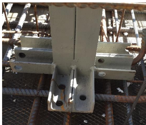
Figura 4.3.55-Parrilla de anclaje del tensor
