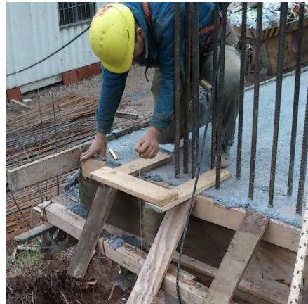
Figura 4.3.59-Traslado de ejes a pisos superiores
