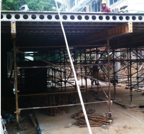
Figura 4.3.41-Vista frontal del encofrado de losa
