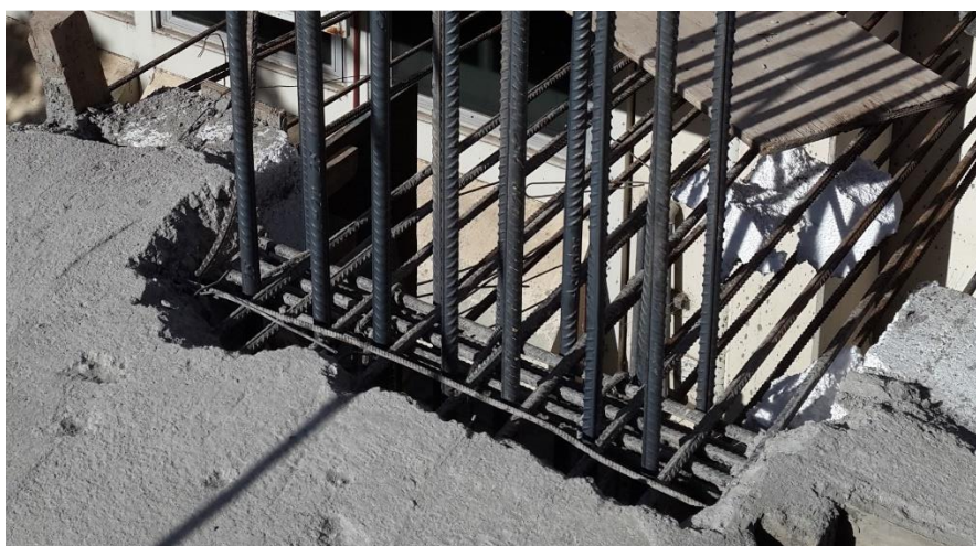
Figura 4.3.64-Remplazo de barras por las correspondientes
