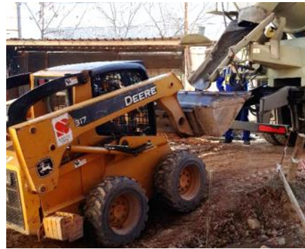
Figura 4.3.8-Hormigonado mediante mini cargadora
