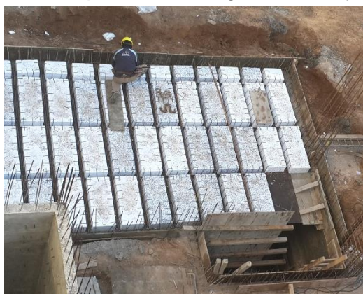
Figura 4.3.19-Proceso de armado losa de recinto
