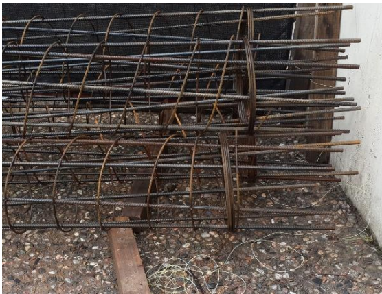
Figura 4.3.3-Armado como pizas
