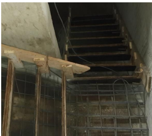
Figura 4.3.68-Armadura de la escalera
