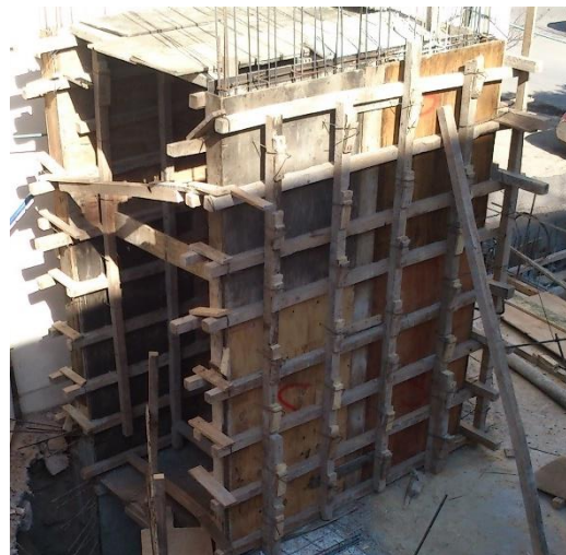
Figura 4.3.73-Encofrado del tabique
