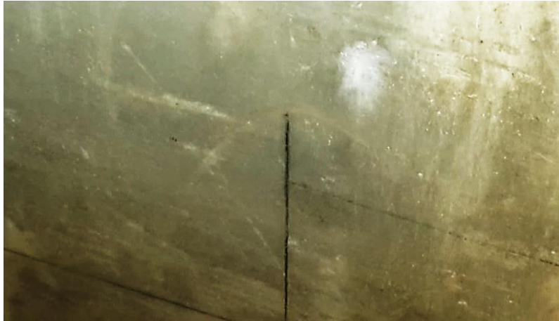
Figura 4.3.65-Replanteo de escalera a sala de cisterna
