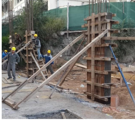
Figura 4.3.32-Encofrado de columna
