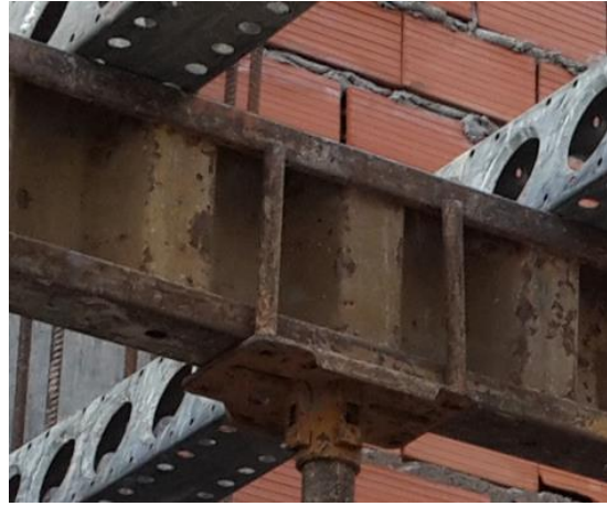
Figura 4.3.39-Dispositivo de fijación de banquina
