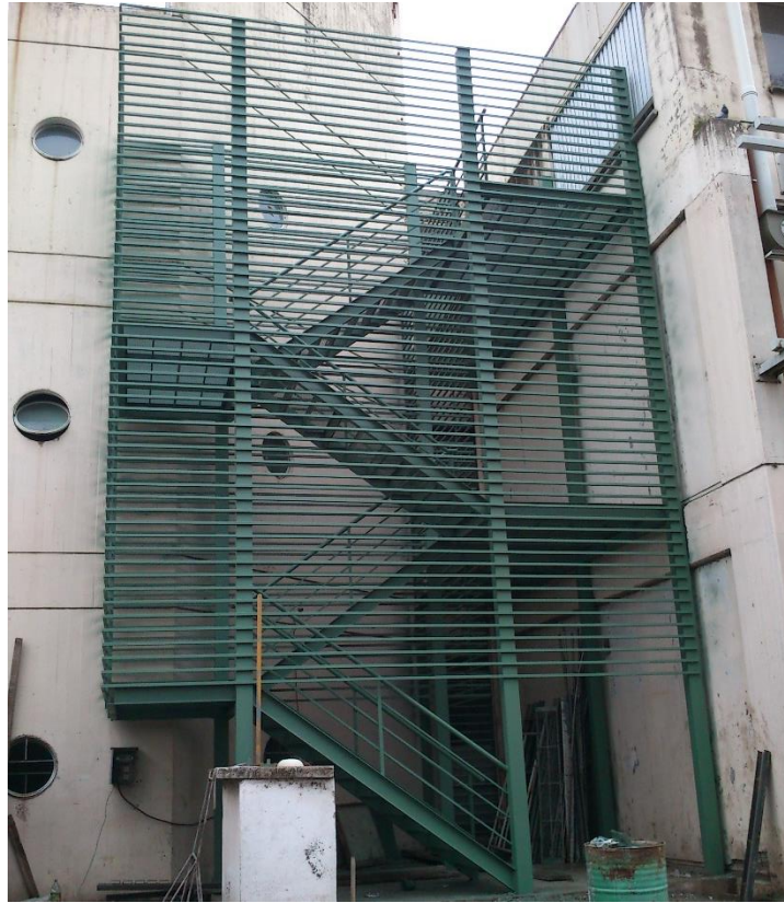
Figura 4.2.13-Escalera terminada sobre Av. Haya de la Torre
