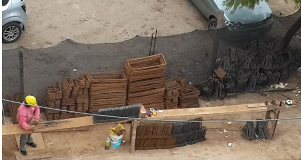
Figura 4.3.2-Banco de Armado
