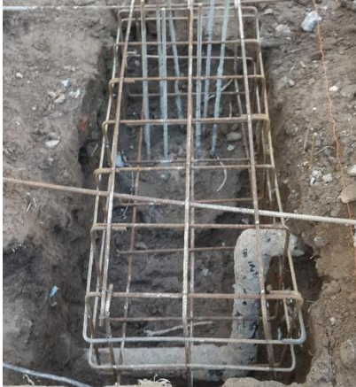
Figura 4.1.5-Caño de abastecimiento de gas FCQ
