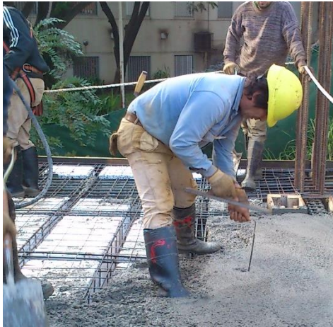
Figura 4.3.49-Nivelado de losa durante hormigonado
