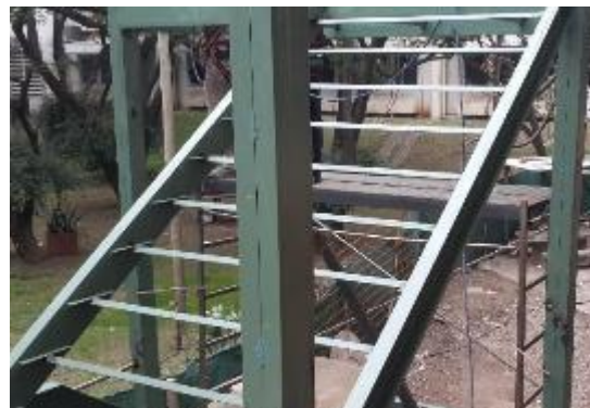
Figura 4.2.15-Refuerzo en huellas
