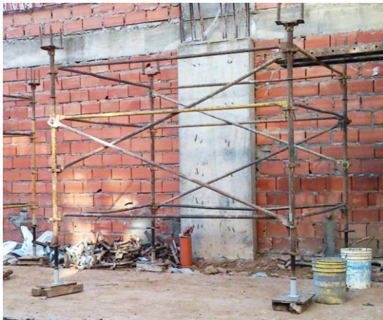
Figura 4.3.36-Módulo estructural
