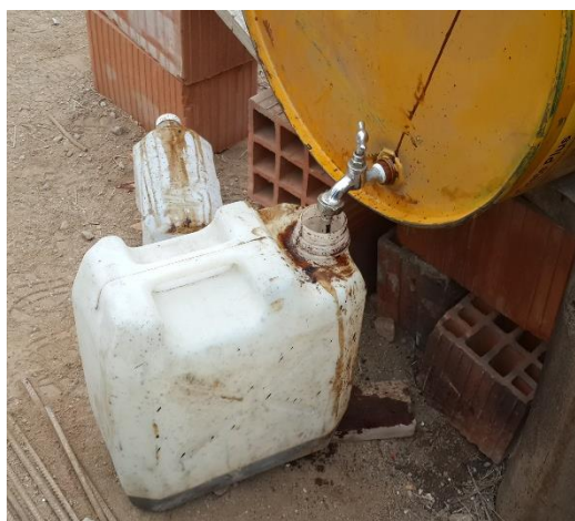
Figura 4.3.33-Dosificación del aditivo (25 litros)
