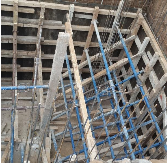
Figura 4.3.13-Encofrado de los tabiques del recinto
