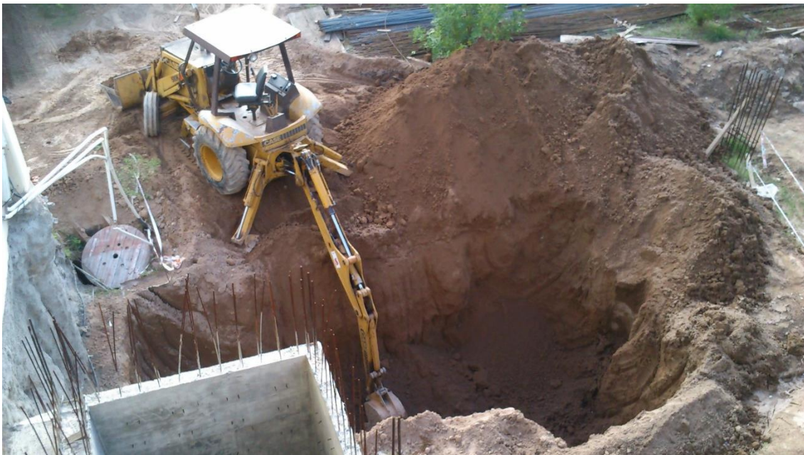
Figura 4.1.5-Movimiento de suelo para sala de cisterna
