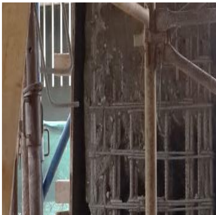
Figura 4.3.62-Picado de columna
