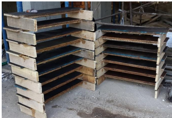
Figura 4.3.67-Encofrado de escalones
