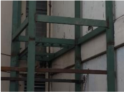
Figura 4.2.7-Arriostamientos estructurales
