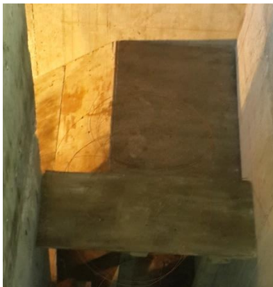
Figura 4.3.66-Encofrado losa de escalera a cisterna
