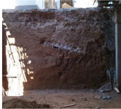
Figura 4.1.11-Corte vertical sobre el suelo
