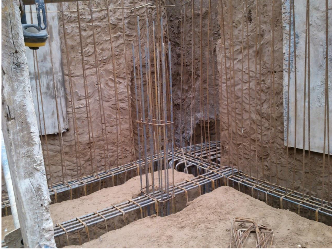
Figura 4.1.9-Armaduras en espera dentro del recinto
