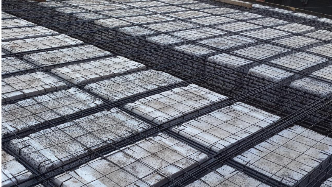
Figura 4.3.48-Losa en espera del hormigón
