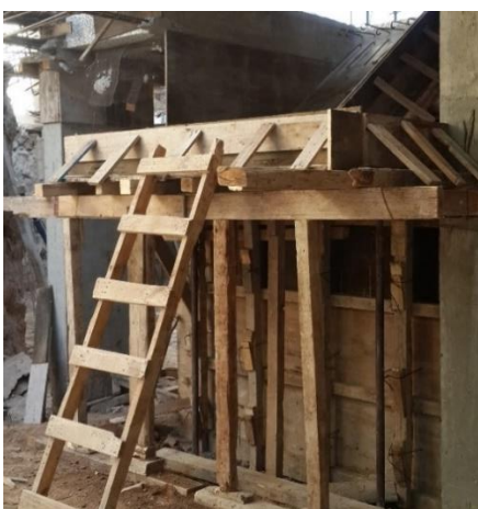
Figura 4.3.70-Encofrado de la escalera
