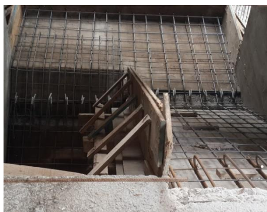
Figura 4.3.71-Armadura de la escalera
