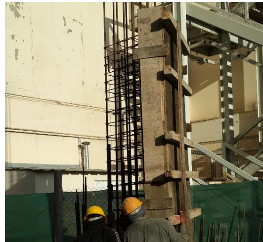
Figura 4.3.30-Montaje de una pieza de encofrado de columna
