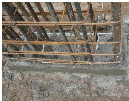
Figura 4.3.27-Dado de replanteo
