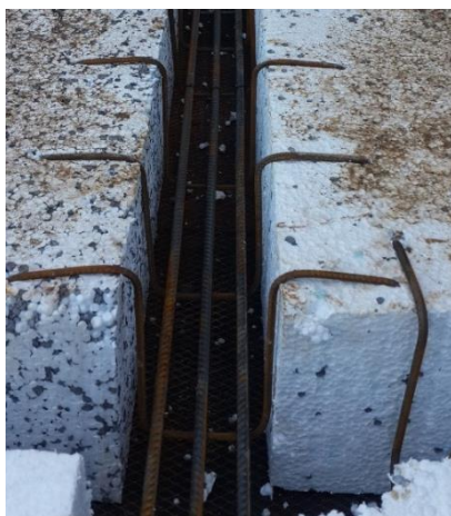
Figura 4.3.46-Disposición de estribos en losa nervurada
