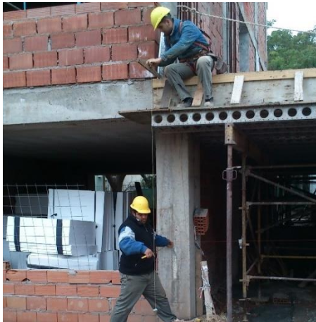
Figura 4.3.58-Traslado de ejes a pisos superiores
