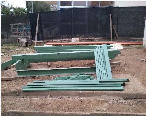
Figura 4.2.1-Acopia de piezas metálicas
