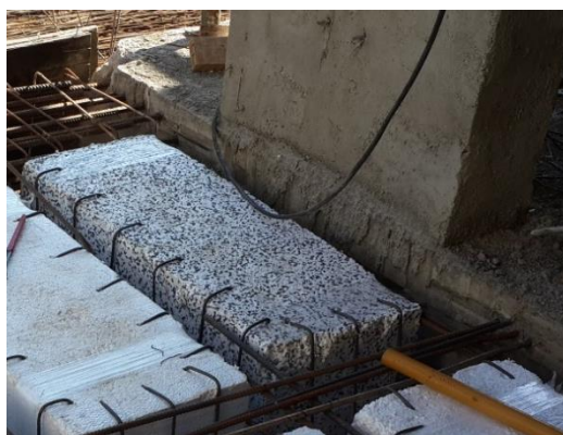
Figura 4.3.54-Anclajes ejecutados
