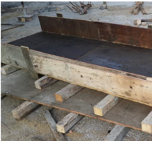
Figura 4.3.29-Encofrado de columna en dos piezas
