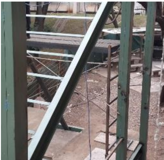
Figura 4.2.5- Arriostramientos auxiliares
