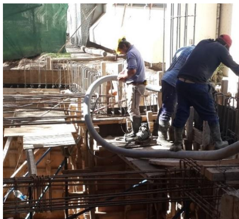
Figura 4.3.76-Hormigonado del tabique de contención
