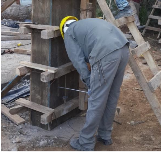
Figura 4.3.31-Verticalización de columnas
