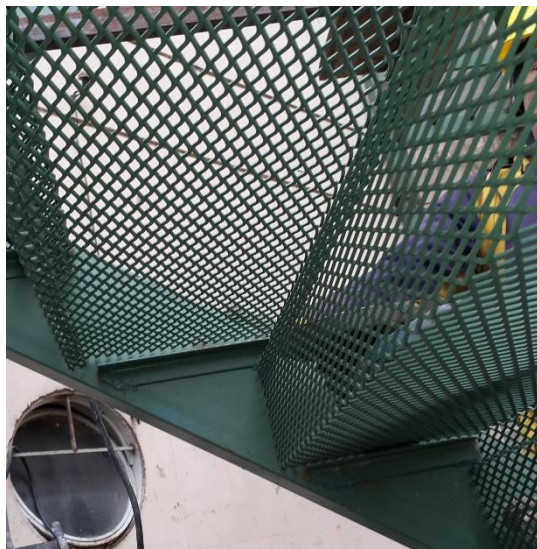
Figura 4.2.9-Apoyos de escalones en laterales de vigas de tramo
