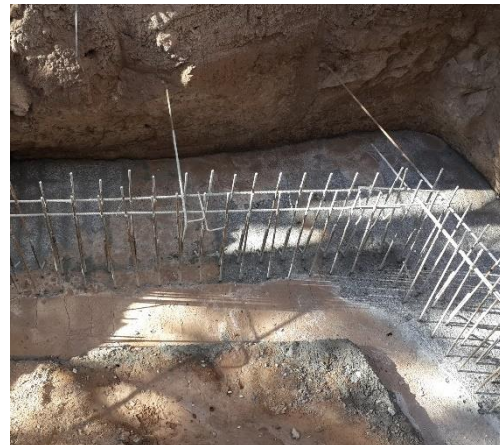
Figura 4.3.75-Armadura en espera
