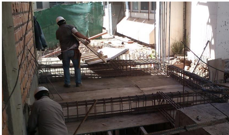
Figura 4.3.81-Terminación de la estructura del 1er SS
