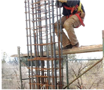
Figura 4.3.28-Armado de una columna
