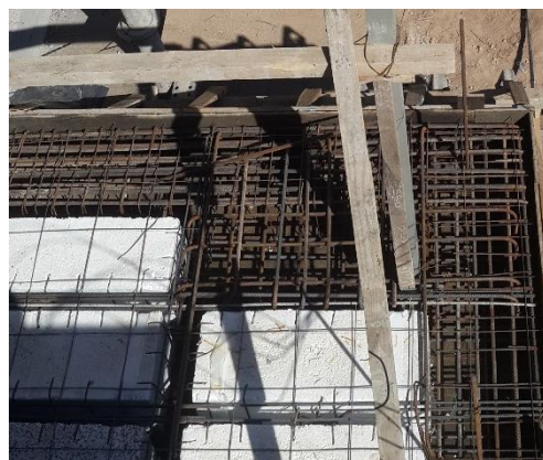
Figura 4.3.56-Disposición del tensor en la losa
