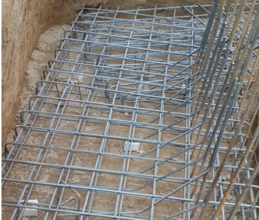
Figura 4.3.74-Armadura de zapata
