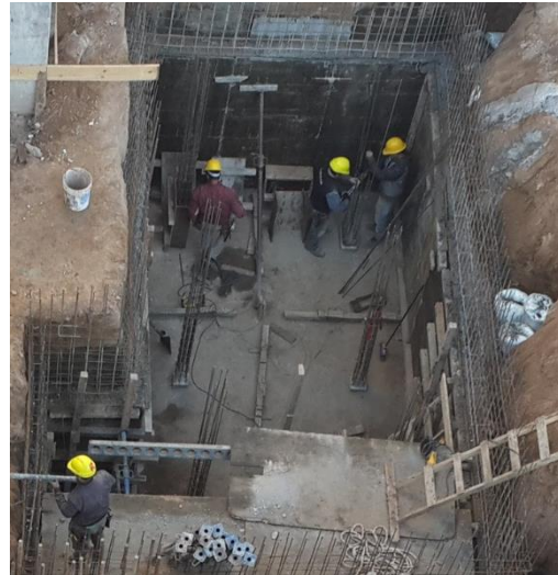
Figura 4.3.14-Desencofrado de los tabiques del recinto
