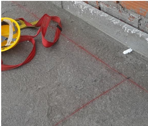
Figura 4.3.60-Demarcación de ejes sobre losa
