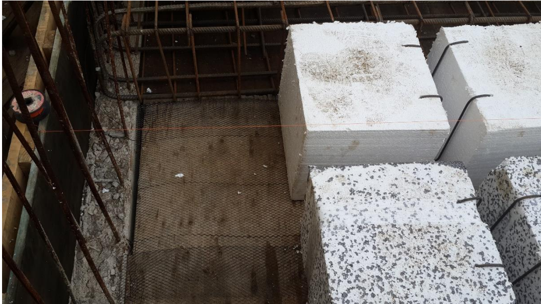
Figura 4.3.45-Proceso de armado de losa nervurada
