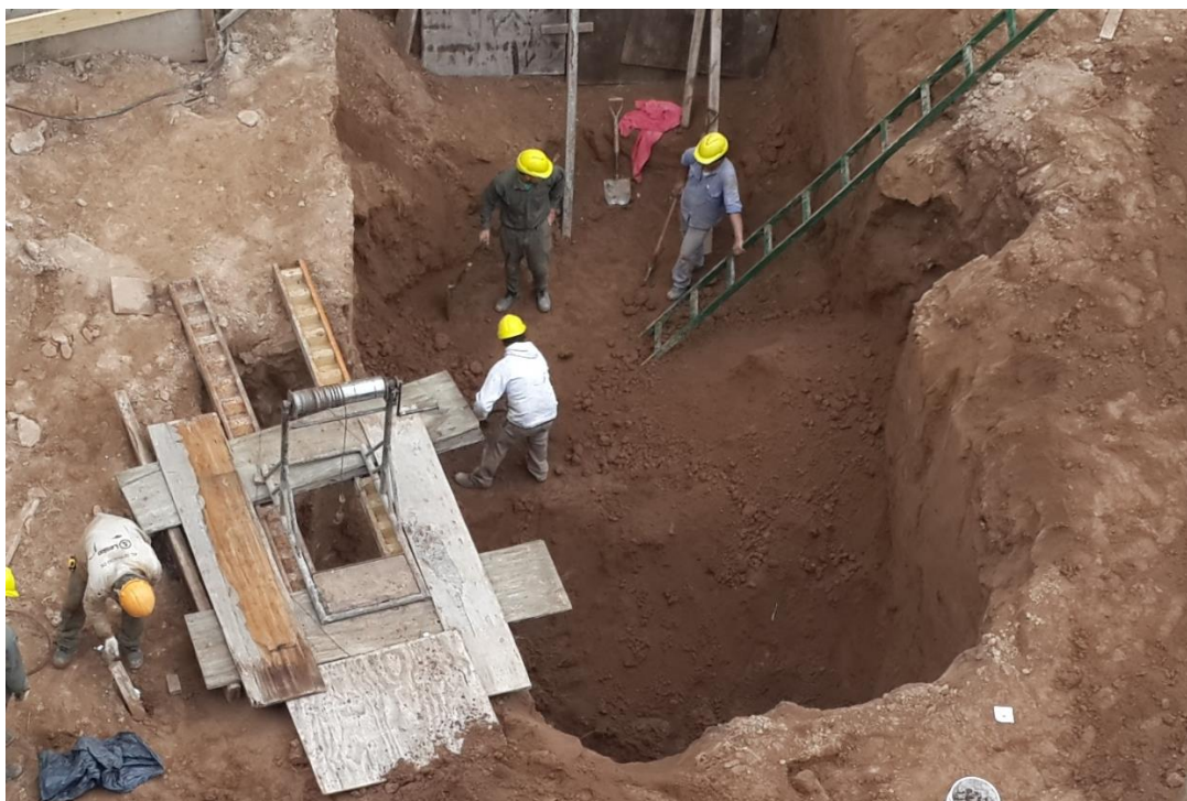
Figura 4.1.6-Perfilamiento manual del recinto
