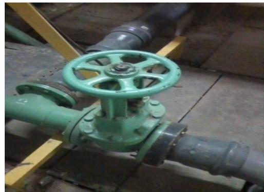
Figura 22 – Llave de maniobra del canal experimental
