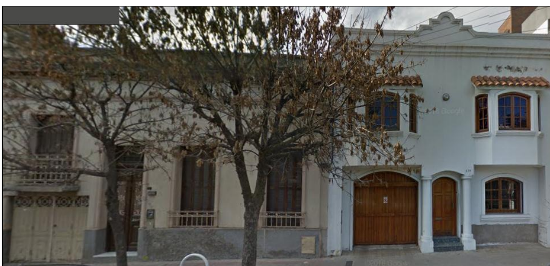
Figura 5.- Vivienda contigua al inmueble a demoler. Construida aproximadamente en 1970, actualmente es utilizada como estudio jurídico.
