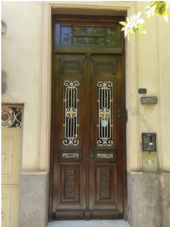
Figura 17.- Puerta de Ingreso Principal
