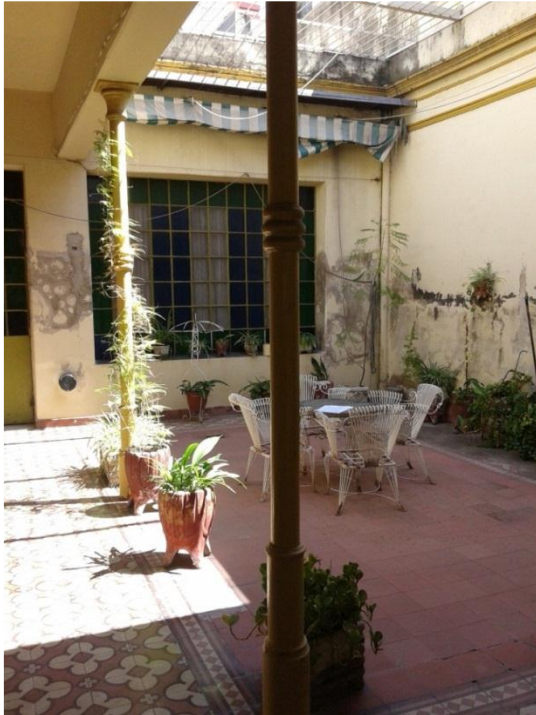
Figura 26.- Columnas en galería de patio interno
