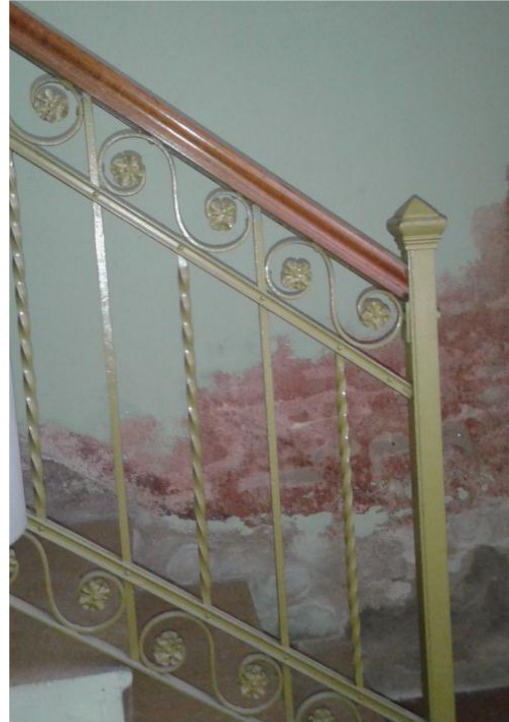
Figura 27.- Baranda de escalera.
