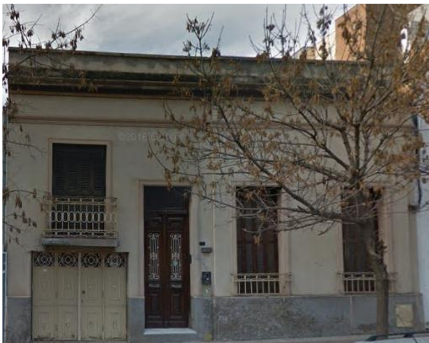
Figura 3.- Fachada de la vivienda cuya posible demolición se analizó en esta PS
