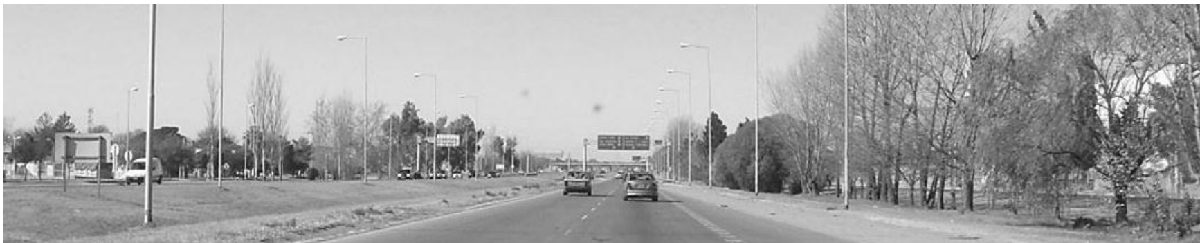
Imagen de vía canalizada con vegetación de borde.
