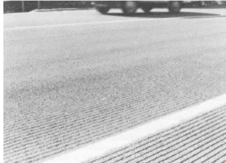
Figura 7.5 Pavimento ranurado, para aumentar la resistencia a la fricción.
