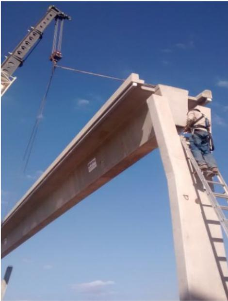
**FIGURA 157:** Señalero posicionando la viga en la columna.
