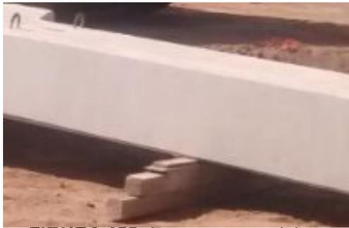
**FIGURA 120:** Forma en que deben apoyar las columnas.
