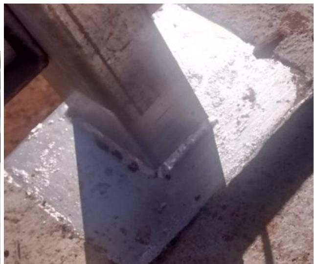
**FIGURA 182:** Soldadura pintada con galvanita y aluminio.
