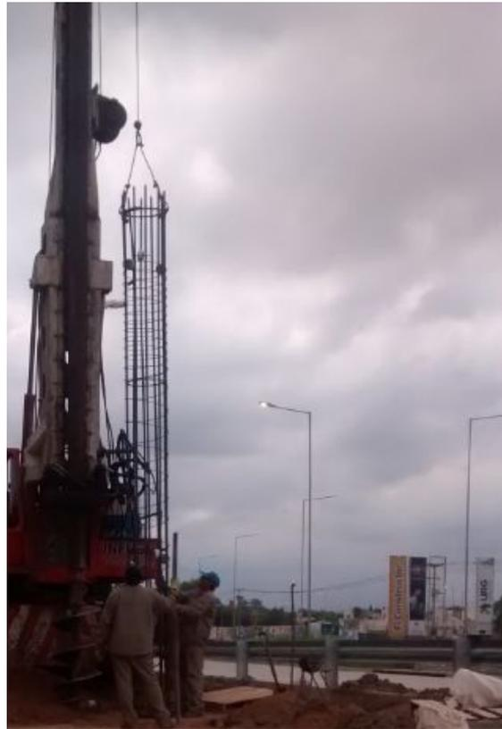
**FIGURA 77:** Descenso de la armadura.
