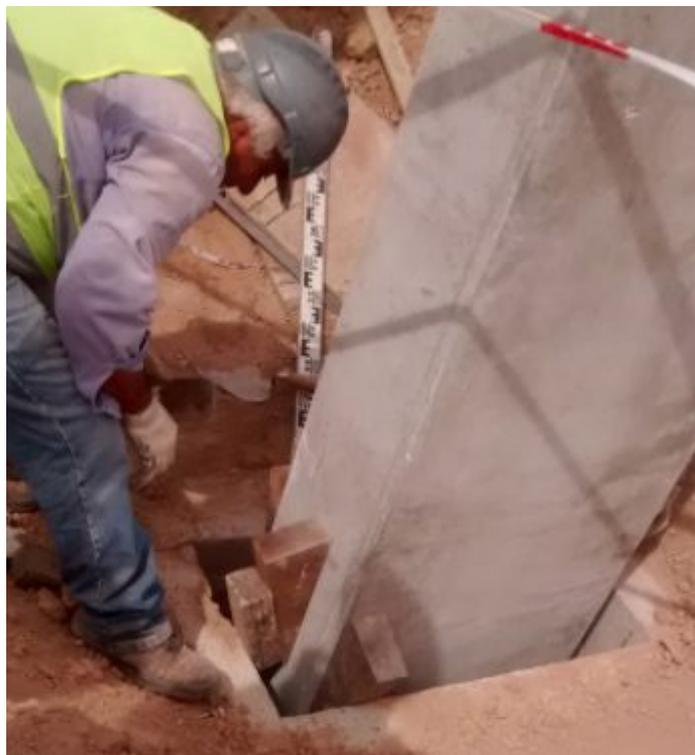
**FIGURA 138:** Cuñas de madera entre el cabezal y la columna golpeándolas con una masa.
