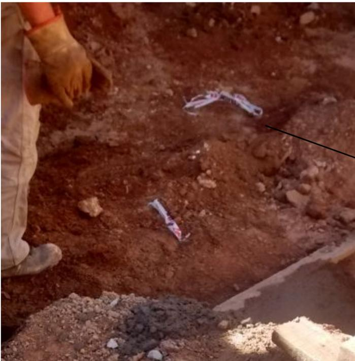
Replanteo del centro del pilote y materializado con estaca.
