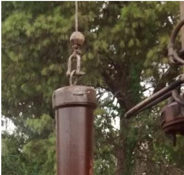
**FIGURA 83:** Levantamiento del tubo tremie usando grillete.
