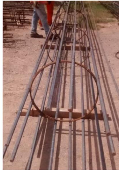
**FIGURA 57:** Marcado de las barras con tiza para las vueltas del zunchado.
