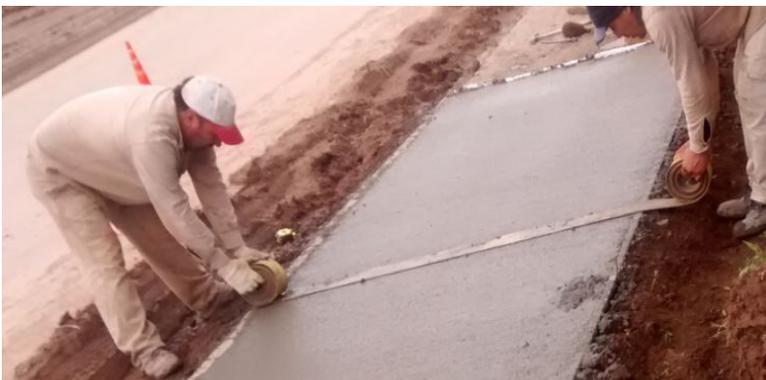
**FIGURA 203:** Método de encintado para dar rugosidad.
