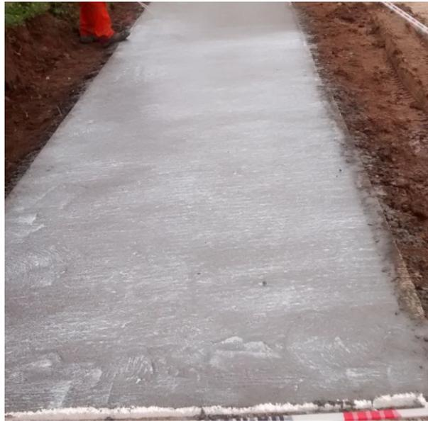
**FIGURA 204:** Antisol en toda la superficie de la vereda.
