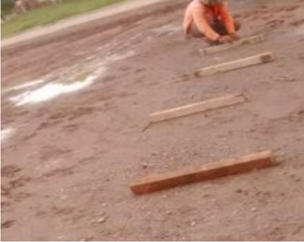
**FIGURA 54:** Se ubican los distintos apoyos para las barras longitudinales.
