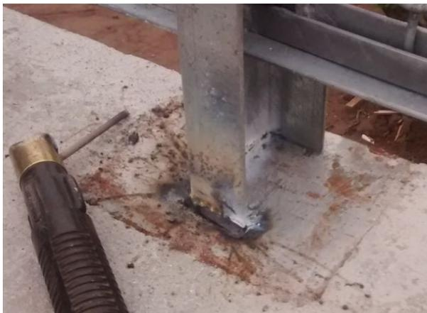
**FIGURA 183:** Unión de la baranda mediante soldadura.
