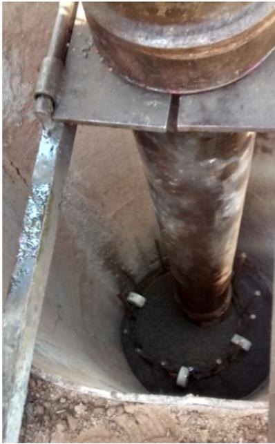
**FIGURA 90:** Penetración tubo tremie en el hormigón.
