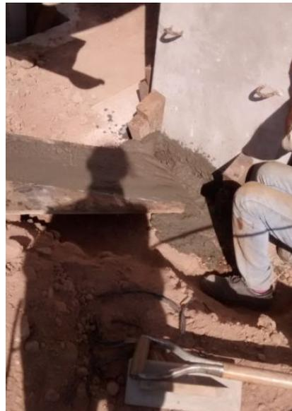
**FIGURA 141:** Vertido del hormigón H-21.
