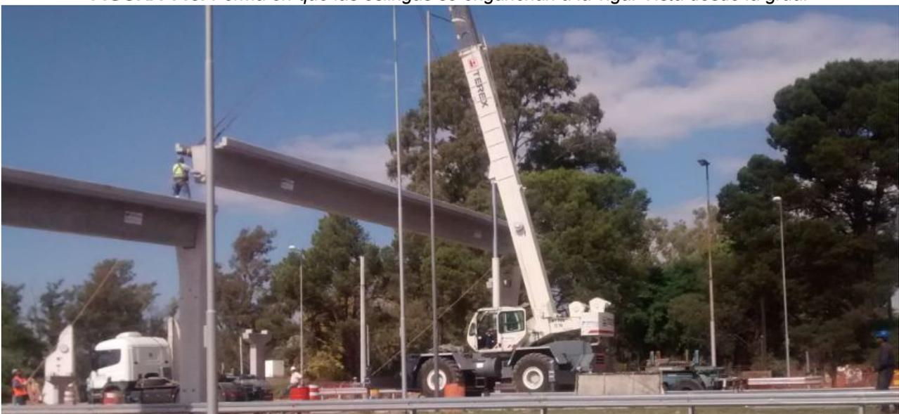
**FIGURA 149:** Dos señaleros posicionando la viga y dos sogueros del lado de la izquierda direccionándola.
