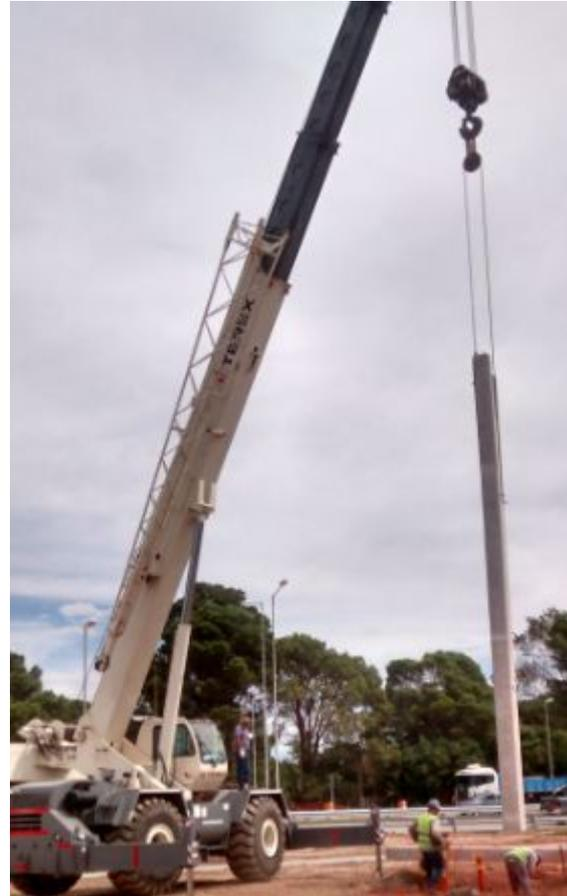
**FIGURA 133:** Columna colocada en su correspondiente cabezal.
