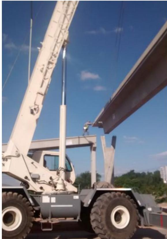
**FIGURA 155:** Señalero posicionando la viga en la columna.
