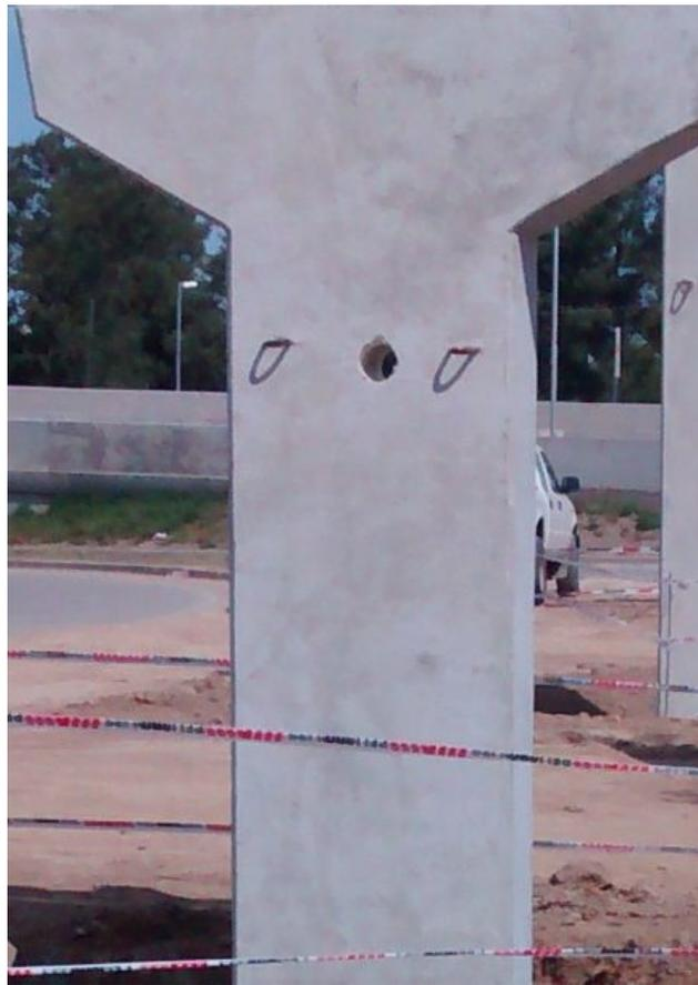
**FIGURA 140:** Ganchos y orificio central para el montaje.
