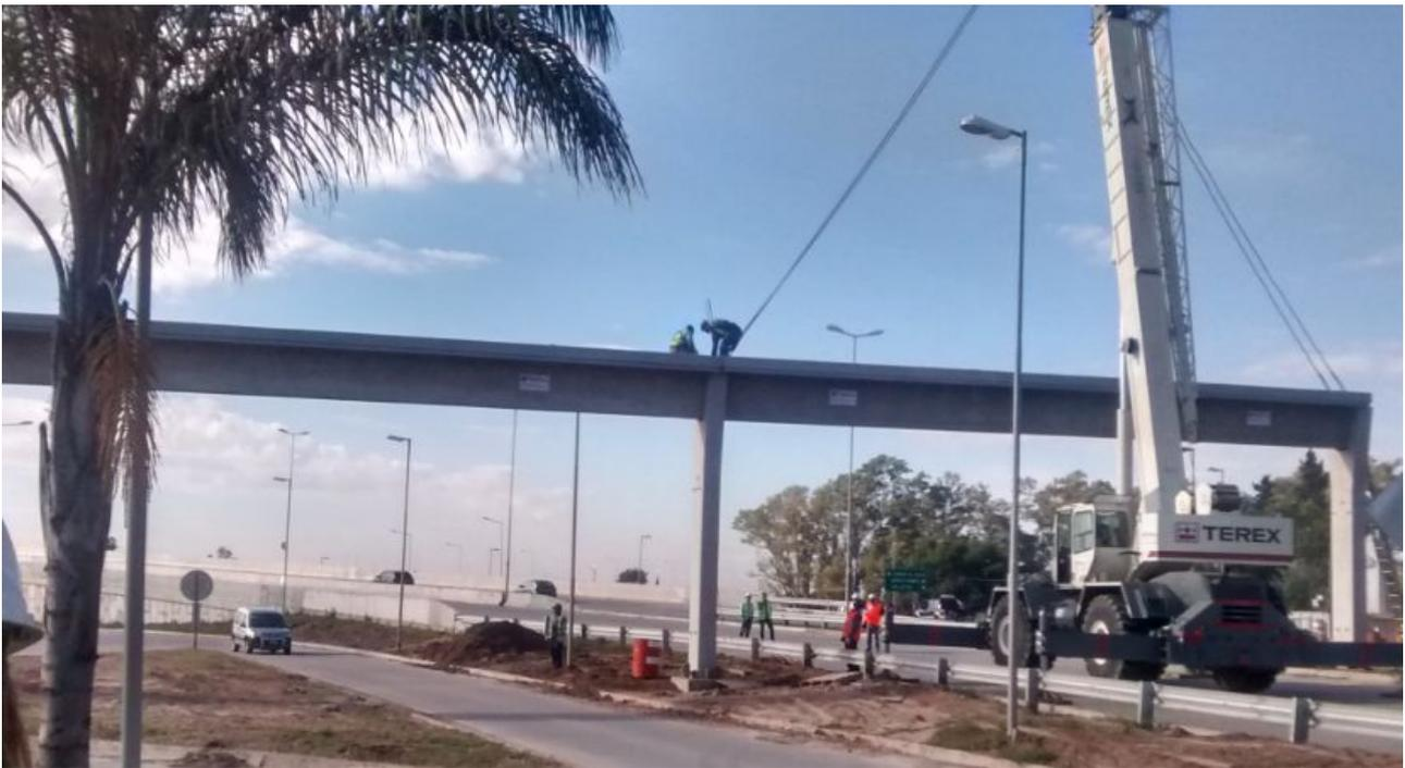
**FIGURA 151:** Señaleros retirando las eslingas.
