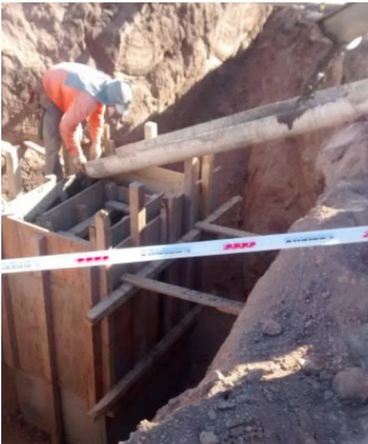
**FIGURA 99:** Encofrado y hormigonado del cabezal.
