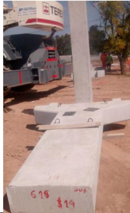
**FIGURA 122:** Columna para el descanso de la pasarela.
