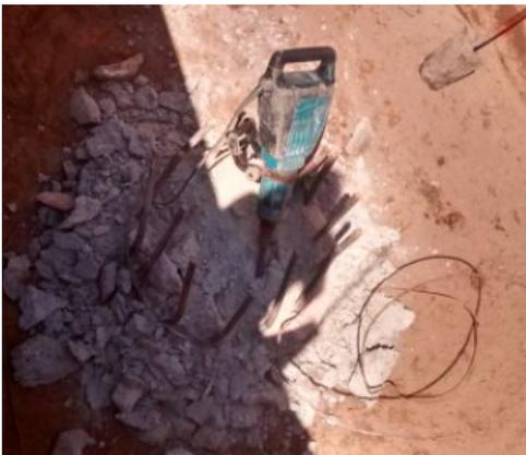
**FIGURA 92:** Picado del hormigón con martillo neumático.
