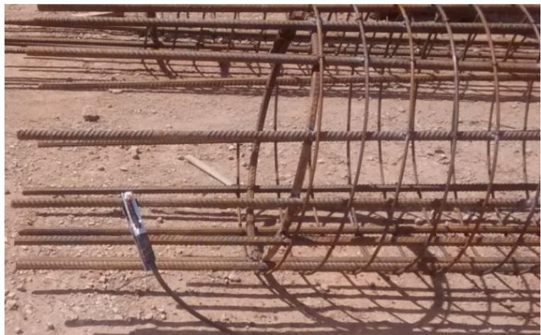
**FIGURA 60:** Atadura con alambre y posterior soldado.
