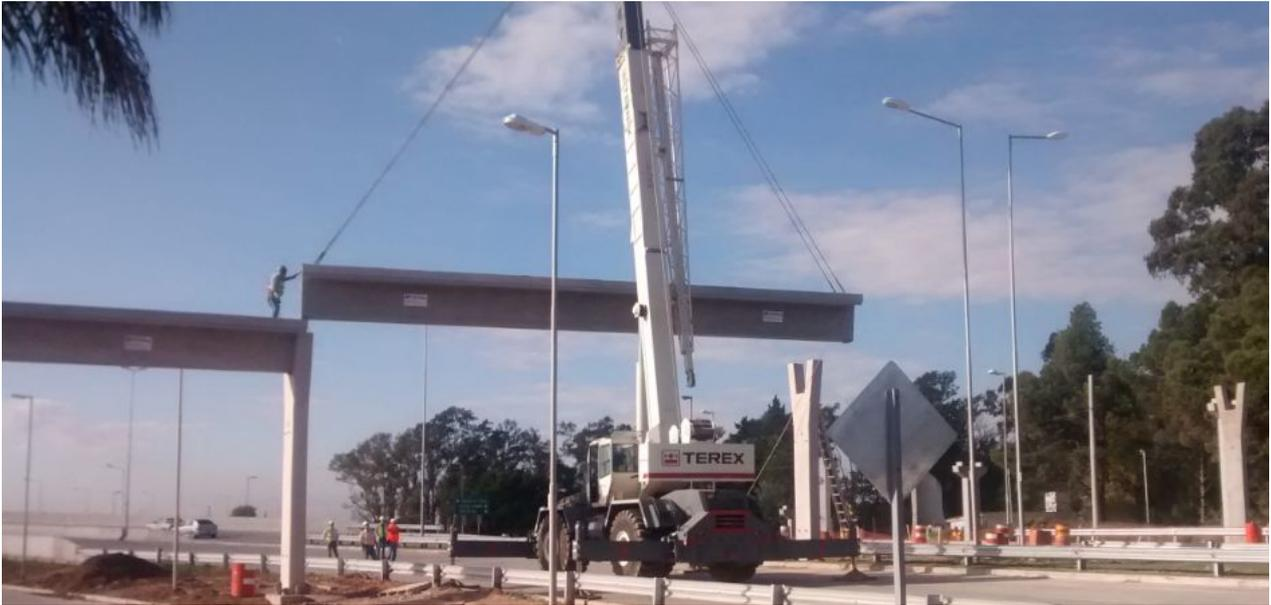
**FIGURA 150:** Dos operarios en los extremos de viga haciendo coincidir los centros de las piezas.
