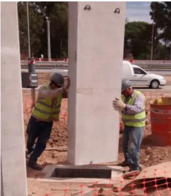
**FIGURA 134:** Posicionamiento de la columna.
