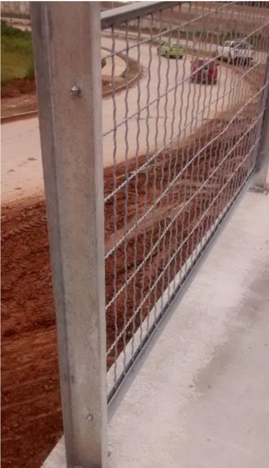
**FIGURA 180:** Detalle de vinculación entre perfiles y paneles de la baranda.
