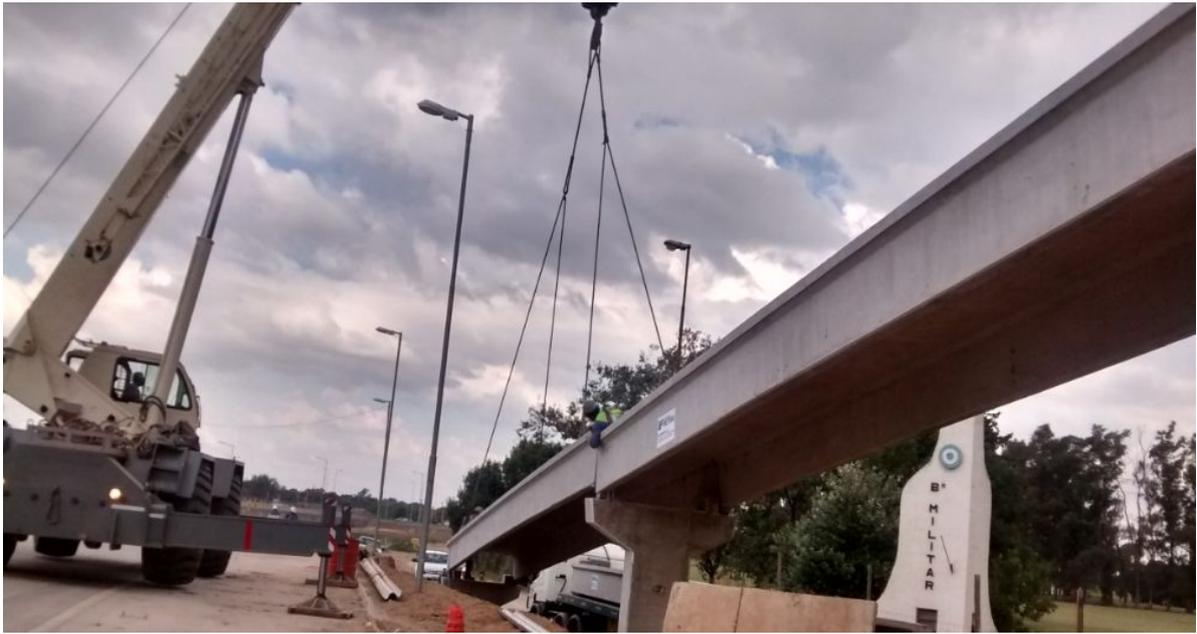
**FIGURA 165:** Eslingas con distintas longitudes por ir la viga con pendiente.
