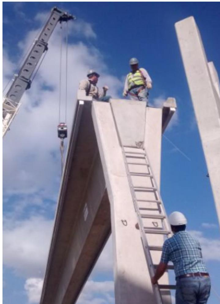
**FIGURA 159:** *Coordinación para corregir algún error de montaje.*
