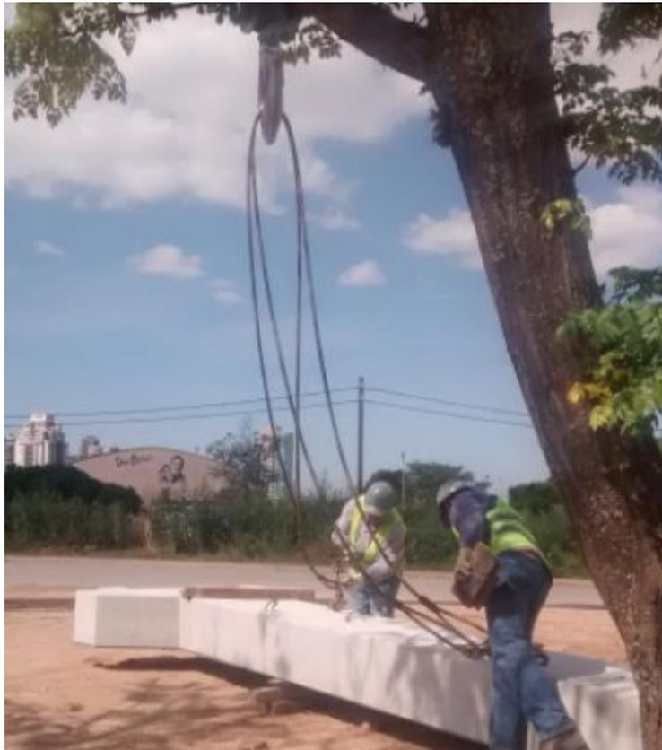
**FIGURA 130:** Después de la descarga. Se retiran las eslingas.
