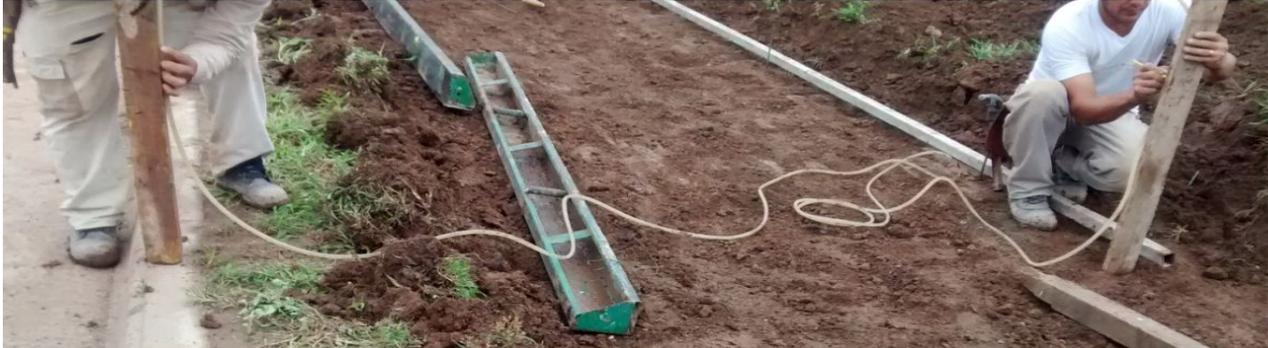
**FIGURA 195:** Verificación de la pendiente con nivel de manguera.
