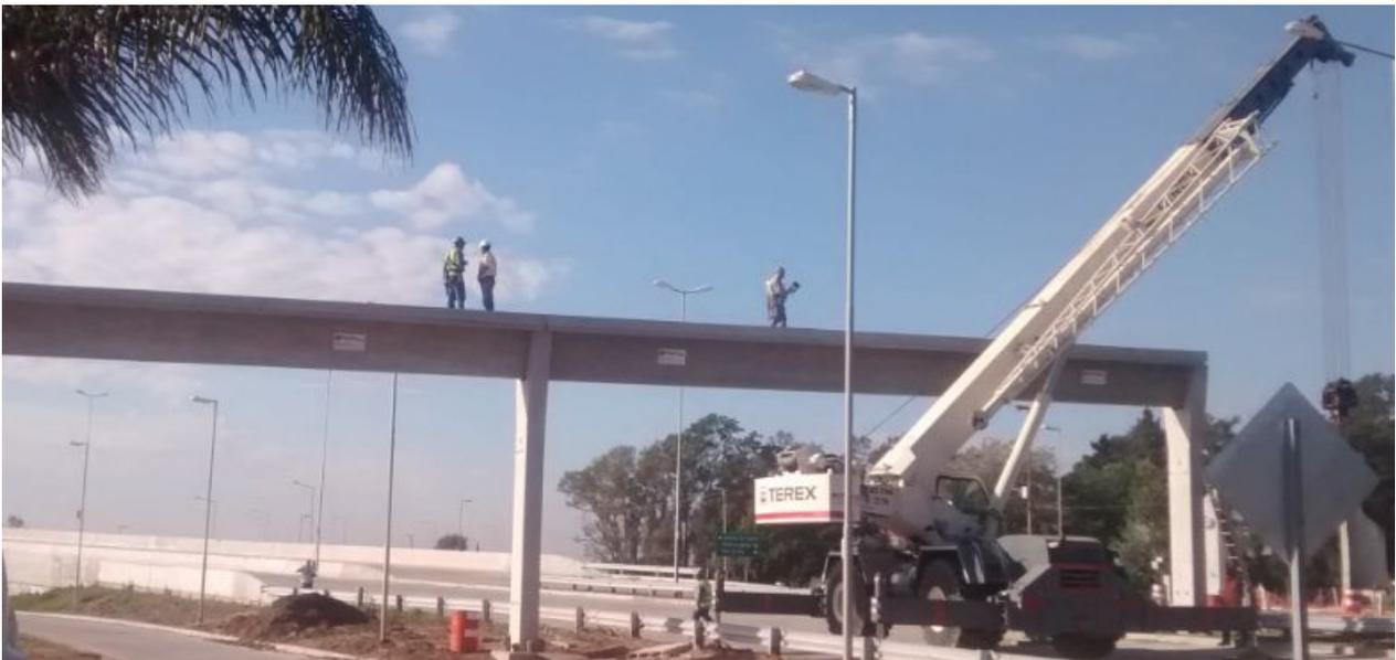
**FIGURA 152:** Operarios e ingeniero corroborando cualquier defecto luego de montar la viga.
