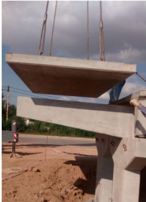
**FIGURA 171:** Montaje del descanso que apoya en dos columnas con voladizo.
