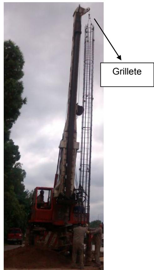
**FIGURA 76:** Izado de la armadura.
