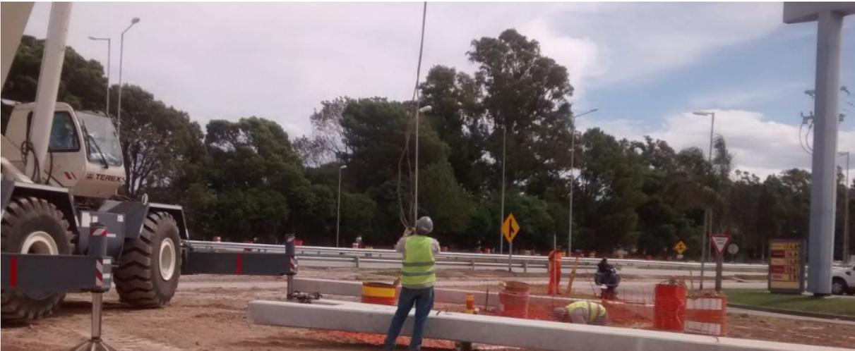
**FIGURA 131:** Colocación de las eslingas para su correspondiente izado.
