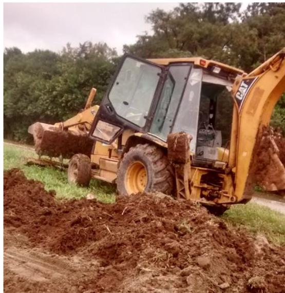
**FIGURA 194:** Extracción del suelo vegetal con retroexcavadora.
