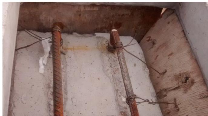
**FIGURA 174:** Forma de realizar el encofrado de los núcleos húmedos.
