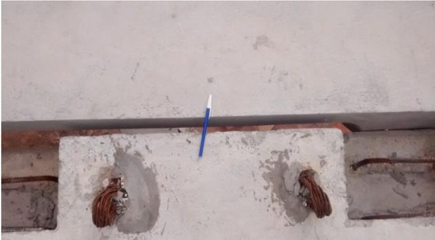
**FIGURA 160:** *Separación de 3 cm en la unión de dos vigas.*
