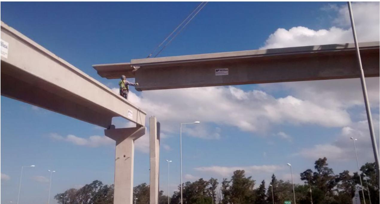
**FIGURA 156:** Apoyos de neoprenos en la parte en donde la viga va a apoyar sobre la columna.
