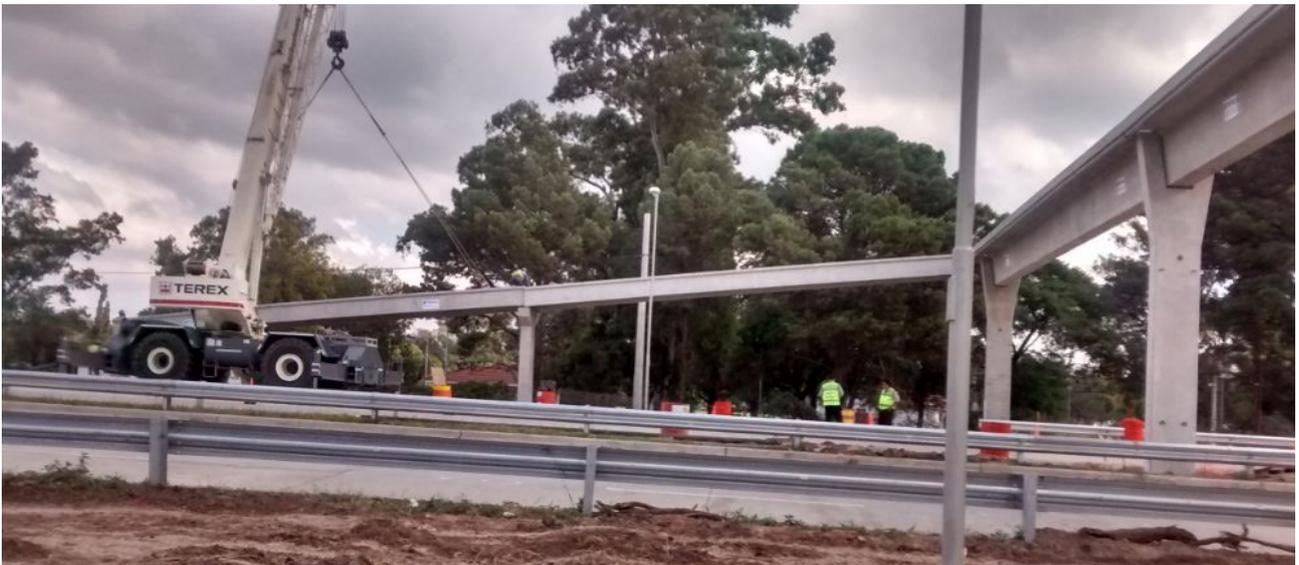
**FIGURA 162:** *Montaje de vigas con pendientes.*
