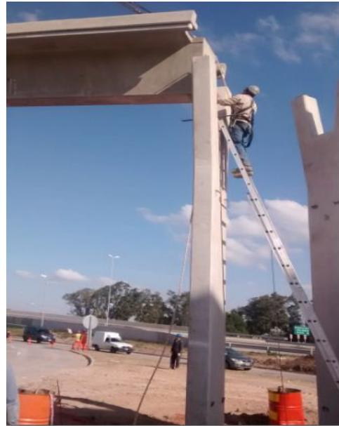
**FIGURA 158:** Señalero verificando la posición de la viga
