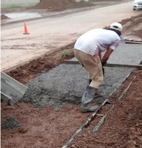
**FIGURA 199:** Distribución del hormigón en toda la superficie.
