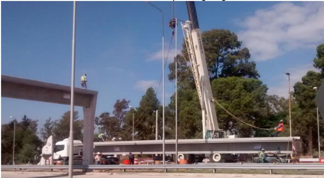
**FIGURA 146:** Operarios colocando eslingas para la descarga y montaje de la viga.
