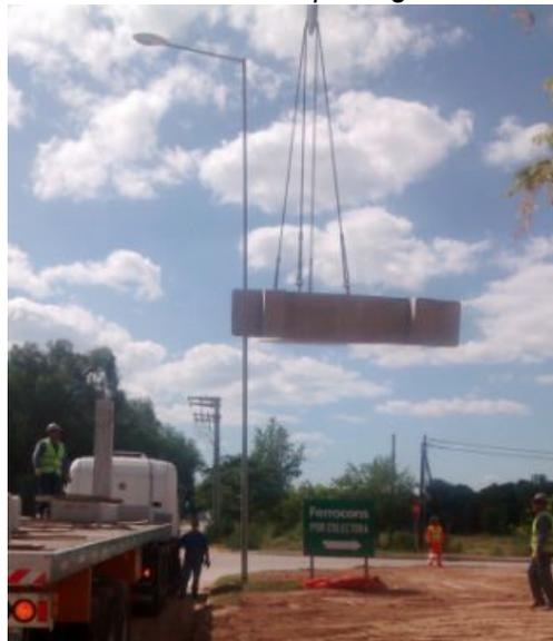
**FIGURA 118:** Columnas descargadas.
