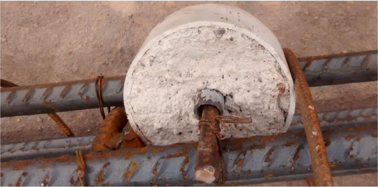
**FIGURA 61:** Raviolos que aseguran un recubrimiento de la armadura.
