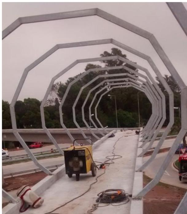
**FIGURA 185:** Soldadura eléctrica para vincular la jaula con la pasarela.
