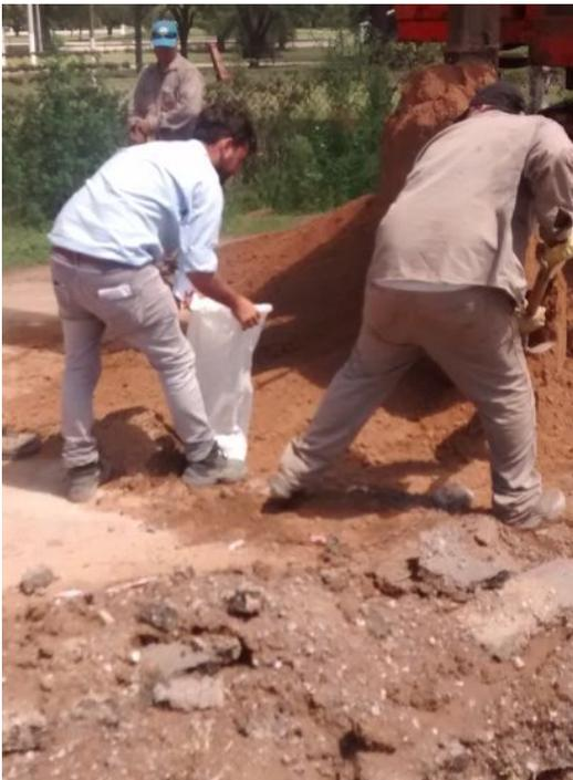
**FIGURA 74:** Toma de muestras para analizar en laboratorio.
