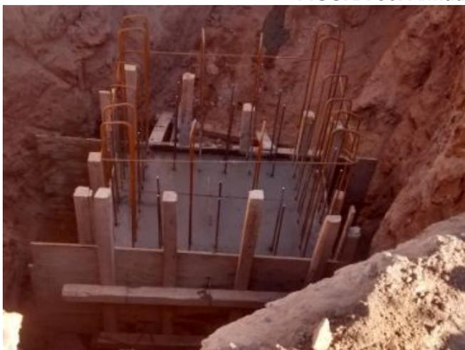
**FIGURA 97:** Encofrado y hormigonado del cabezal.
