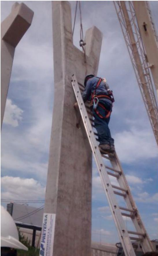
**FIGURA 139:** Operario retirando eslingas.
