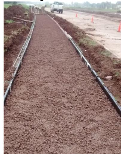
**FIGURA 197:** Detalle de los encofrados de madera y metal.
