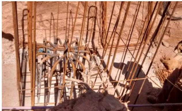
**FIGURA 96:** Armadura de cabezales.
