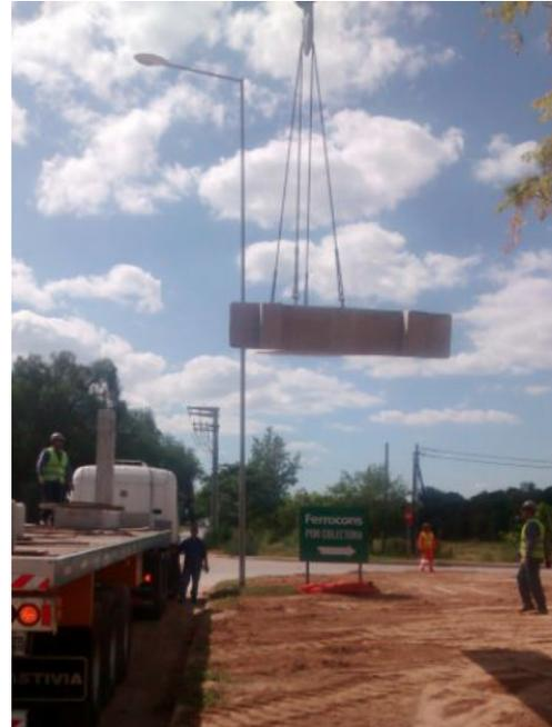
**FIGURA 128:** Forma en que se deben descargar las columnas.
