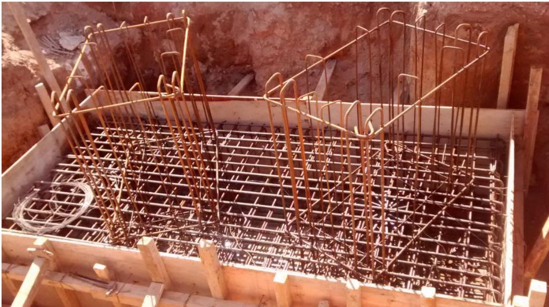
**FIGURA 104:** Cabezales arriostrados con armadura.
