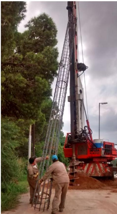
**FIGURA 75:** Ascenso de la armadura.
