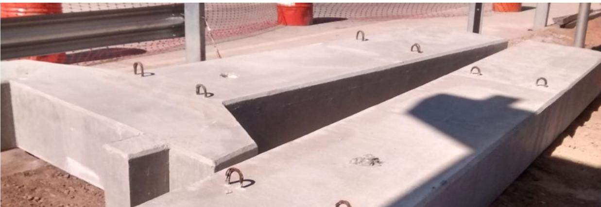
**FIGURA 127:** Ganchos para descarga e izado de columnas.
