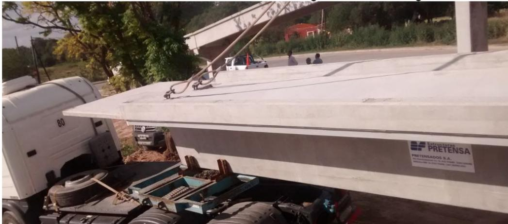
**FIGURA 148:** Forma en que las eslingas se enganchan a la viga. Vista desde la grúa.
