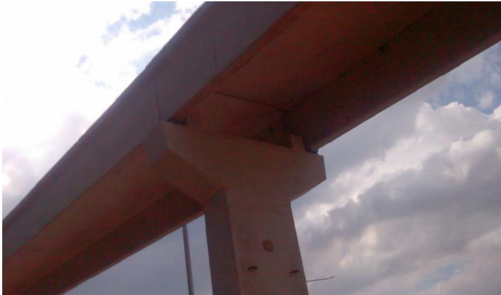
**FIGURA 164:** Unión viga-columna-viga.
