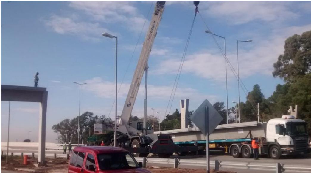
**FIGURA 147:** Grúa realizando la descarga e izado de la viga.
