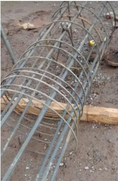
**FIGURA 59:** Colocación del zunchado.
