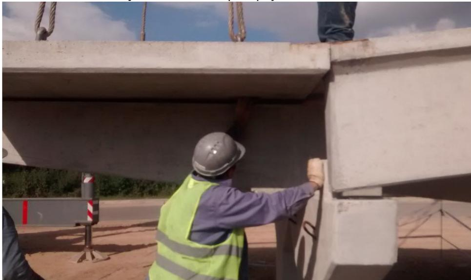
**FIGURA 172:** Operario colocando neopreno para corregir escalonamiento.
