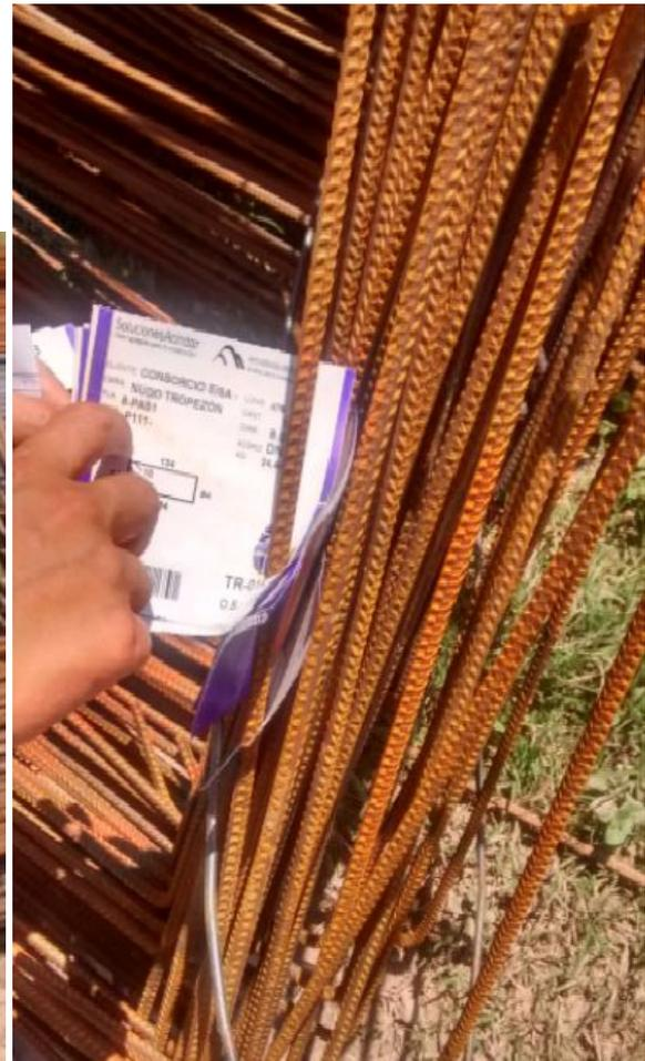
**FIGURA 53:** Identificación y recepción de armadura.
