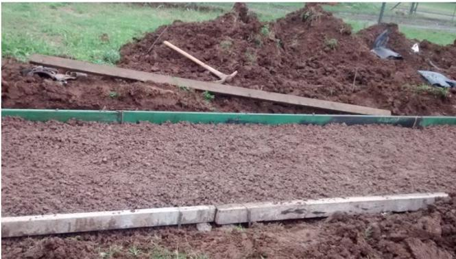
**FIGURA 196:** Preparación de encofrados.
