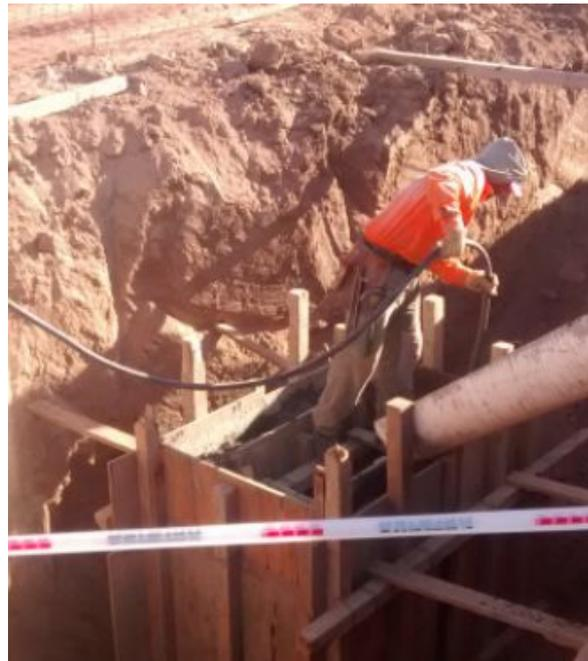
**FIGURA 100:** Vibrado del cabezal.
