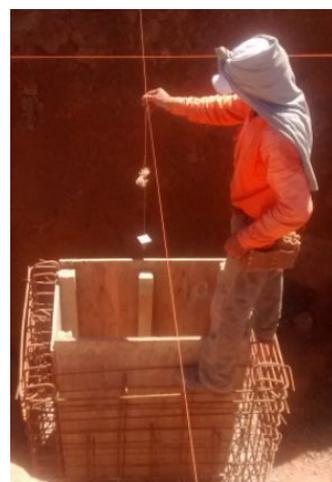
**FIGURA 98:** Verificación de la centralidad con la plomada.
