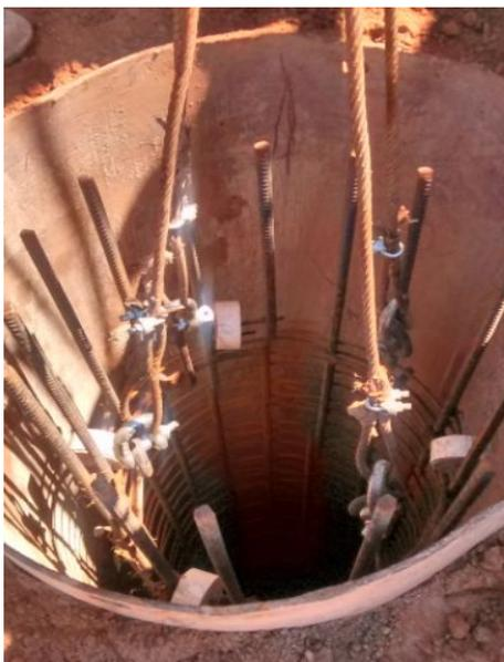
**FIGURA 89:** Colocación de la armadura.
