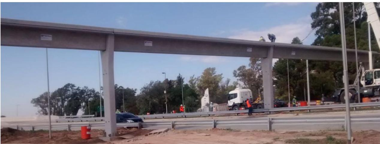
**FIGURA 154:** Señaleros retirando eslingas y verificando la posición de la viga que se montó.
