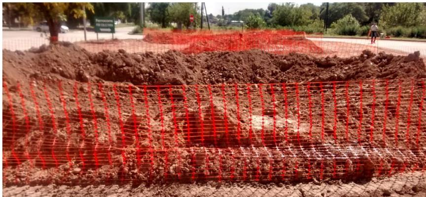
**FIGURA 103:** Señalización de cada pilote.
