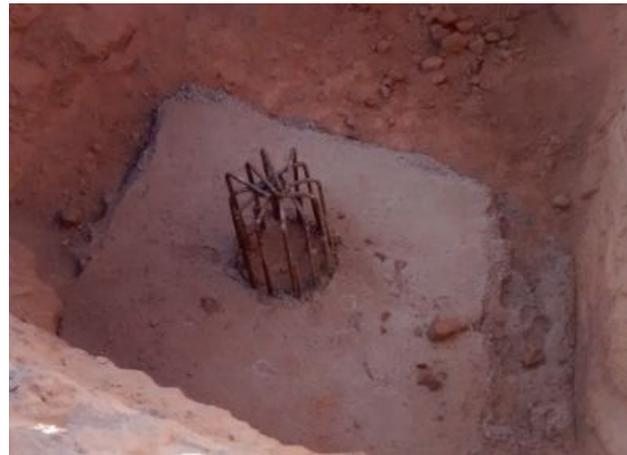
**FIGURA 95:** Superficie de hormigón terminada.
