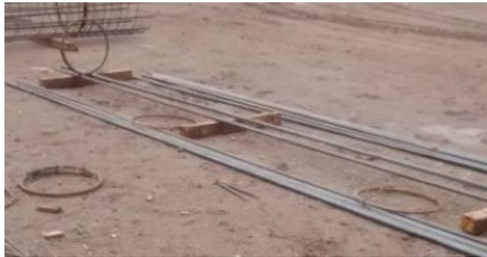
**FIGURA 55:** Se colocan los aros rigidizadores.
