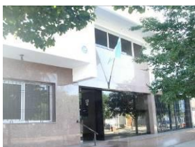
Edificio de la Municipalidad de Isla Verde, Año 2011.
