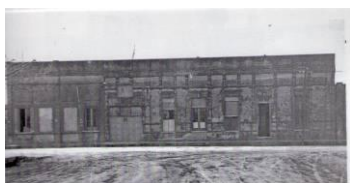
Antiguo edificio. Año 1959
