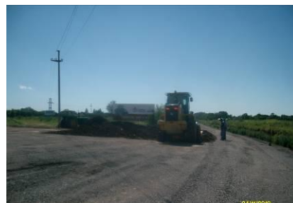
Obras para desvío del tránsito pesado
