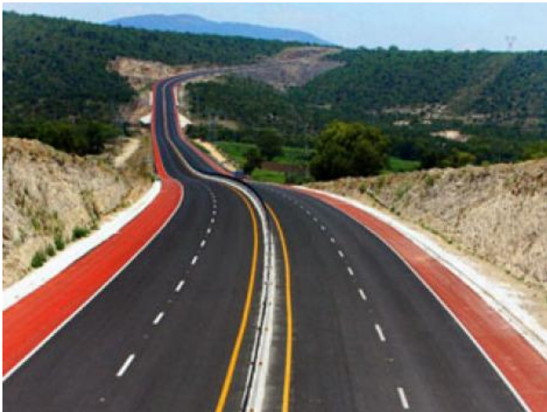
Foto 7: Broken back horizontal, mal diseño
