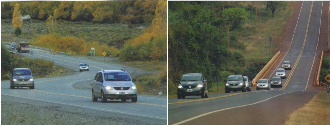
Foto 4: Aproximación a puentes
