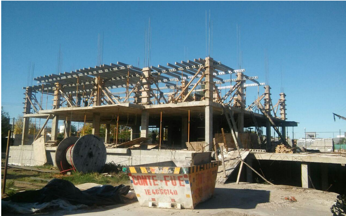
Fig.3: Estado parcial Torre V del Condominio Fontanas del Sur
