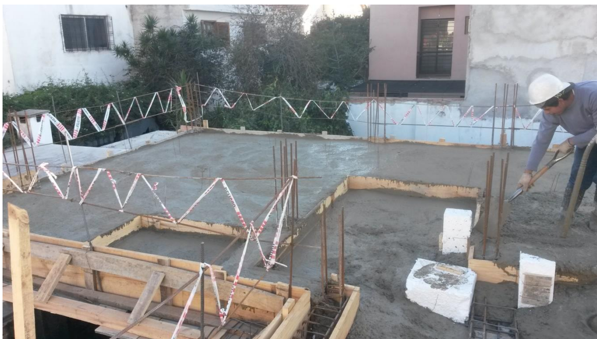
Figura 6.4.6: Losa hormigonada
