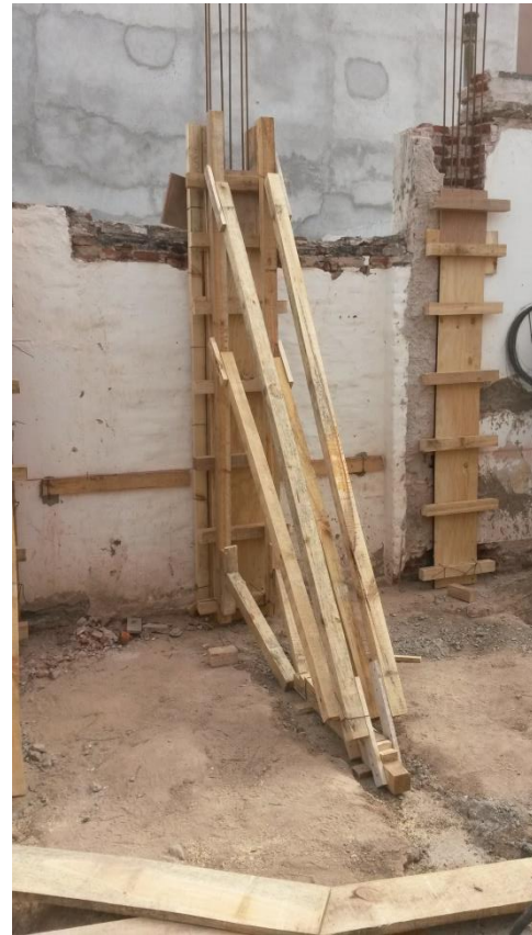
Figura 6.1.2: Encofrado de columnas
