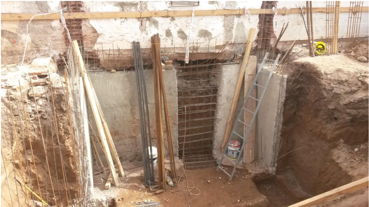
Figura 5.8: Armadura de tramo de tabique restante
