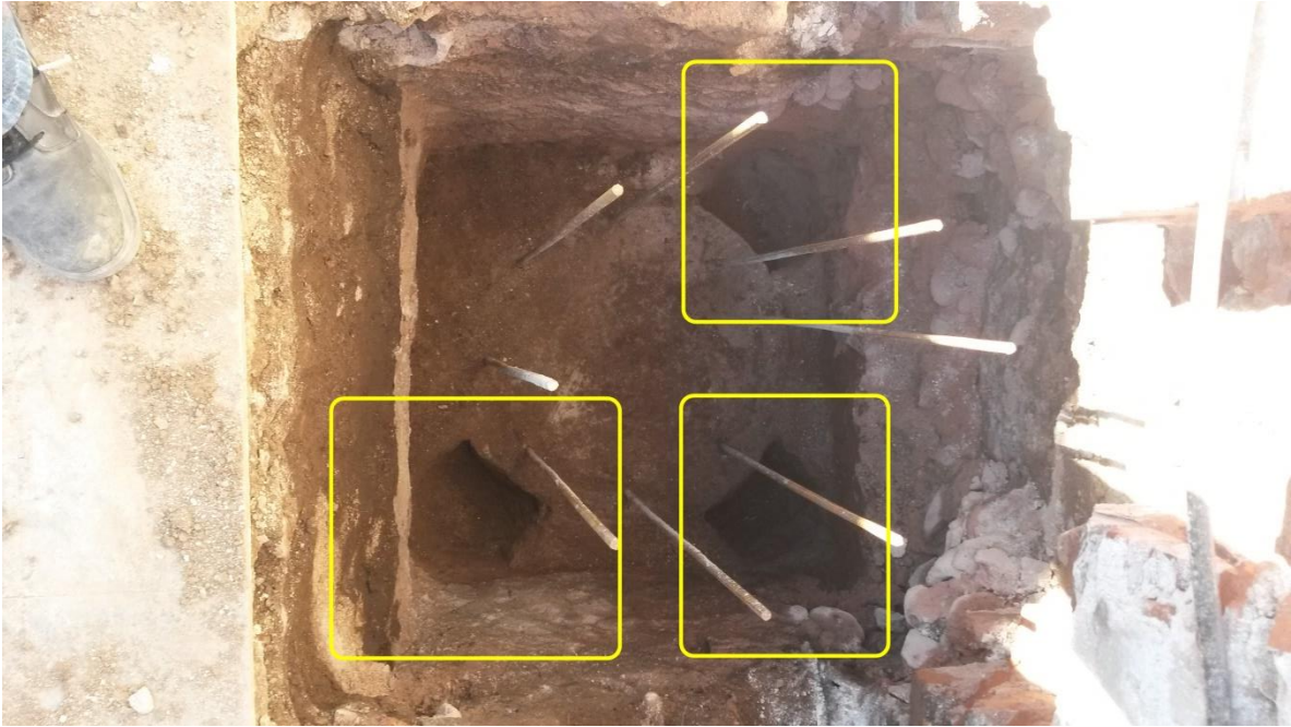
Figura 4.9: Hendiduras practicadas para la limpieza del pilote
