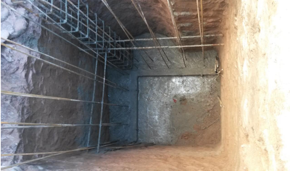
Figura 5.4: Fundación de tabique hormigonada, con armadura en espera
