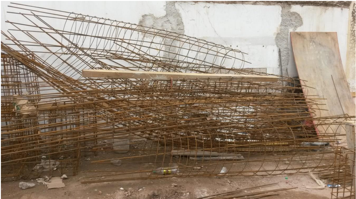
Figura 4.1: Armaduras de pilotes
