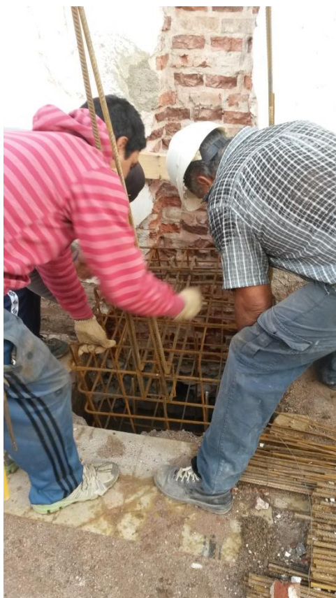
Figura 4.7: Colocación de armadura de cabezal
