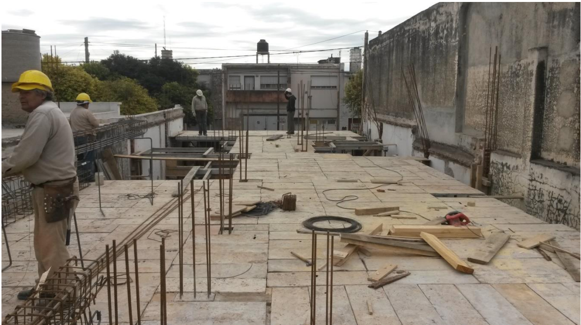
Figura 6.1.12: Armado de vigas sobre encofrado de losa
