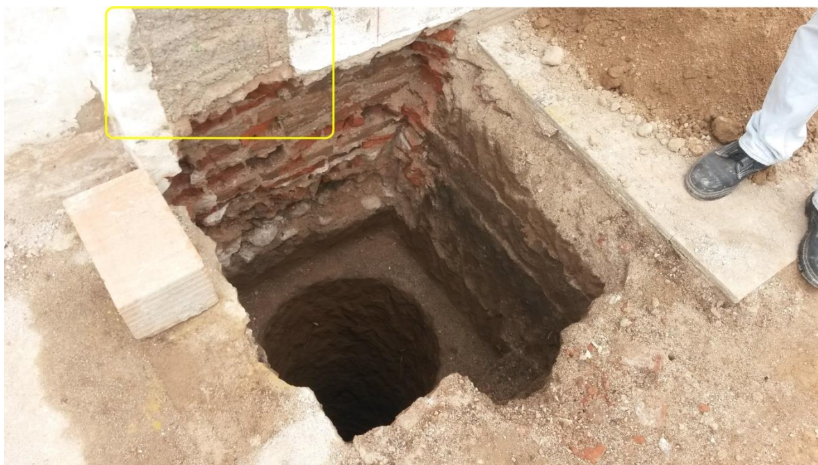
Figura 3.3: Detalle de fundación de muro medianero
