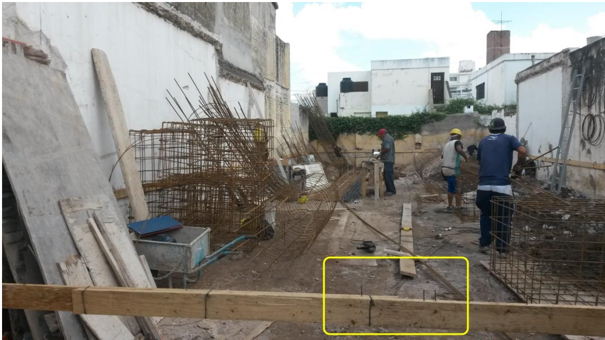
Figura 2.2: Replanteo de ejes
