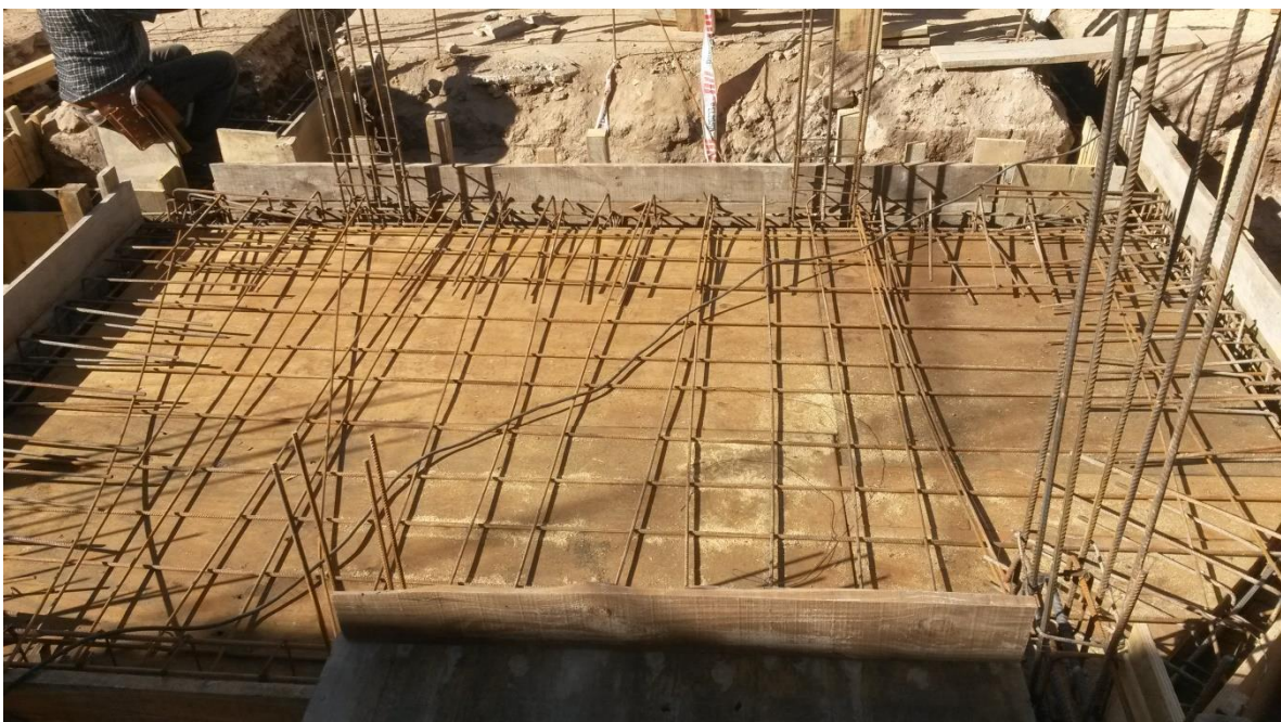
Figura 5.31: Encofrado y armadura de losa sobre subsuelo
