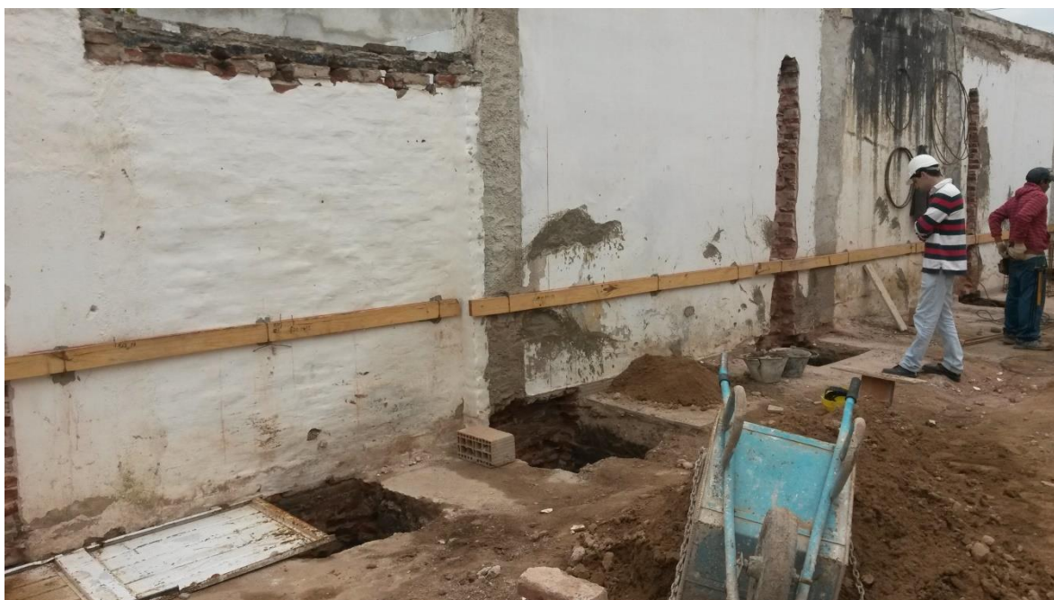
Figura 3.4: Pozos en medianera oeste
