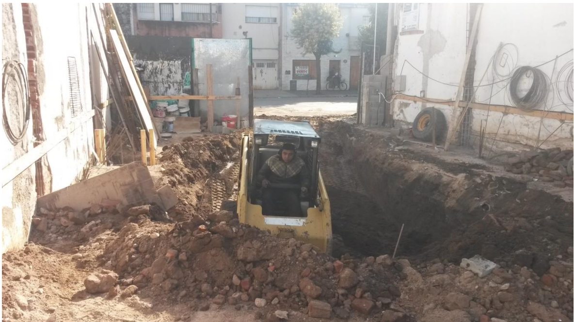
Figura 3.10: Excavación mecánica de subsuelo
