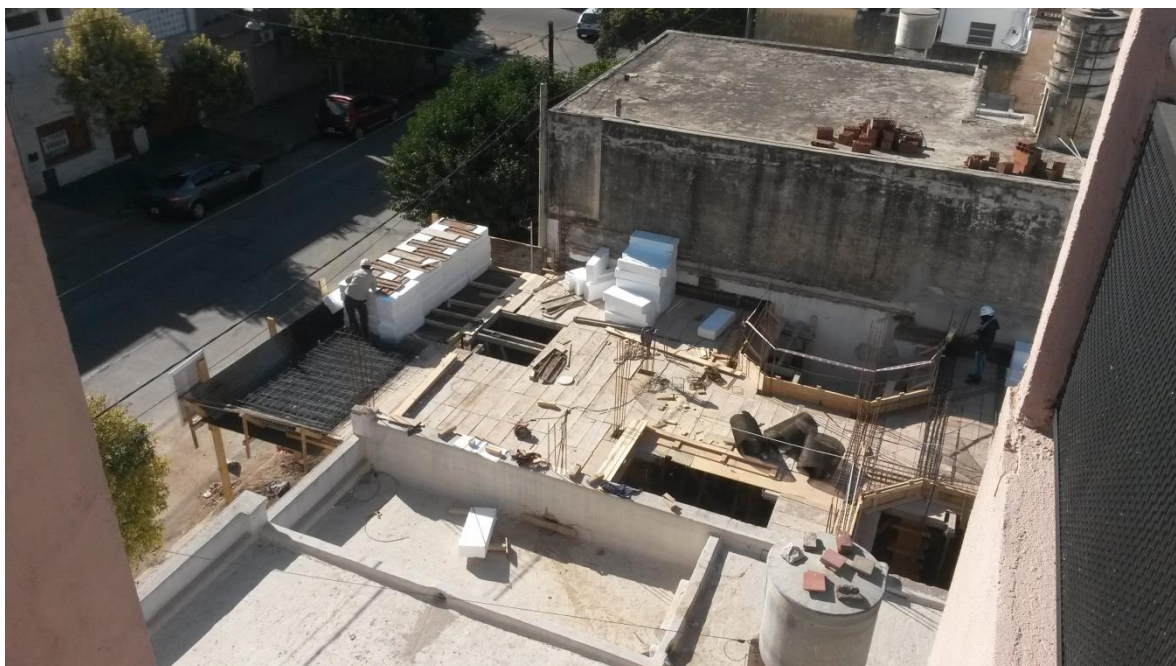
Figura 6.2.7: Acopio de ladrillos de telgopor y mallas electrosoldadas
