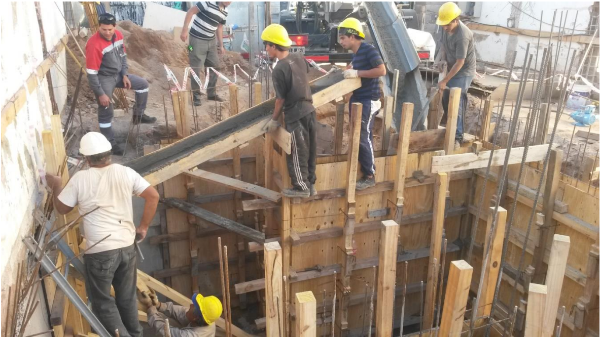
Figura 5.20: Hormigonado de tabique de subsuelo
