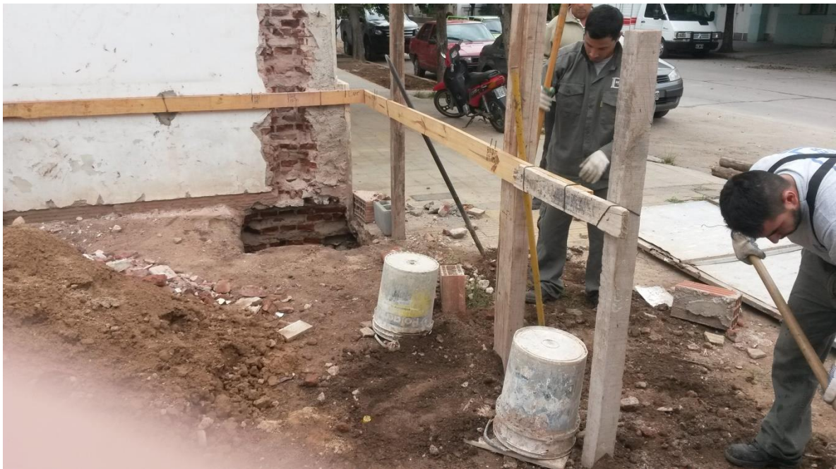
Figura 2.1: Cierre de obra
