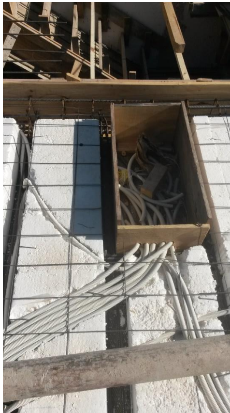
Figura 6.3.2: Montante eléctrica
