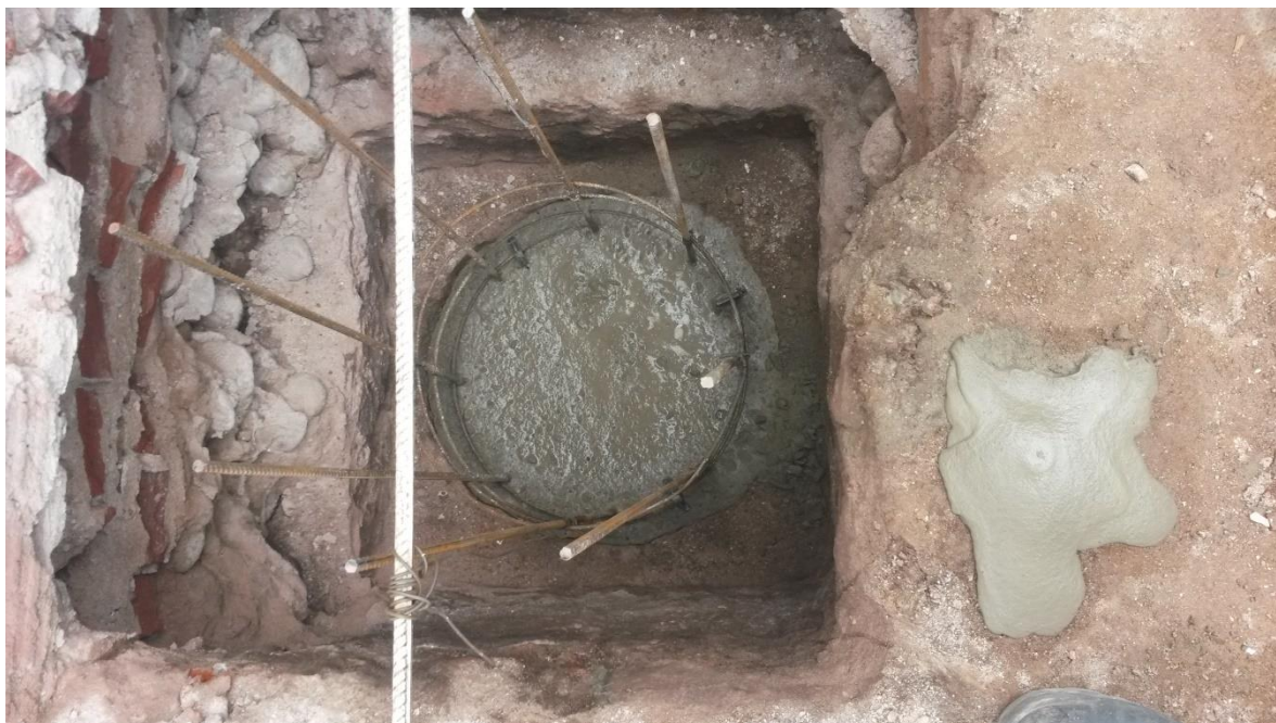
Figura 4.11: Pilote hormigonado y vibrado
