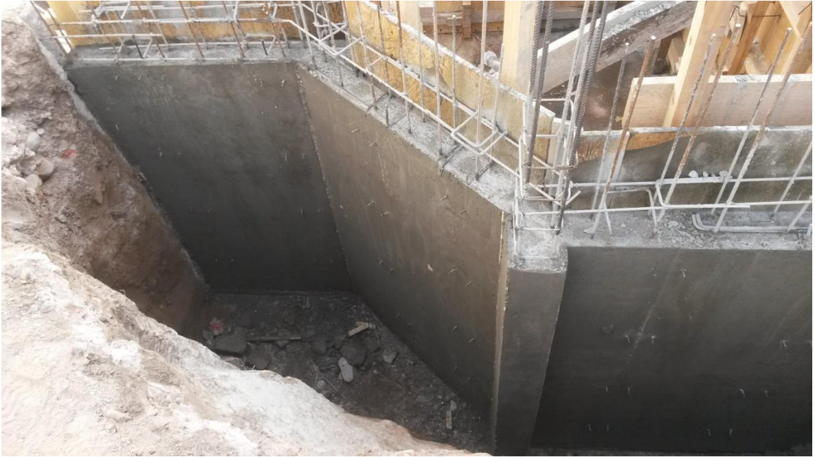
Figura 5.22: Desencofrado de tabique
