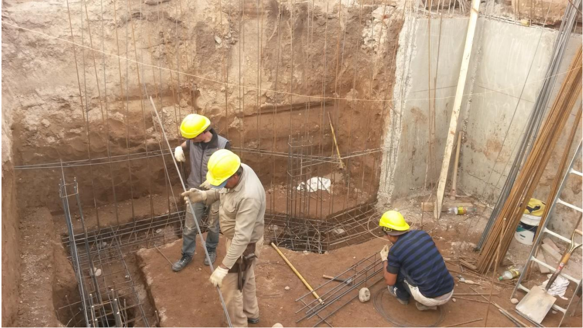
Figura 5.9: Zapata de fundación de tabique de subsuelo
