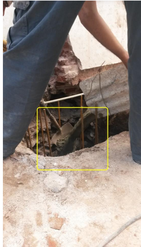
Figura 4.6: Colado de hormigón
