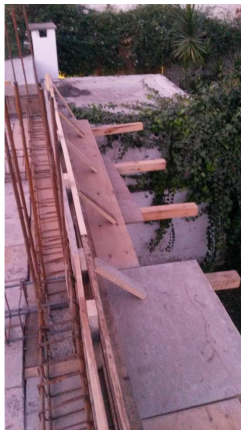
Figura 6.1.14: Encofrado de viga de borde Figura 6.1.15: Encofrado de viga de borde
