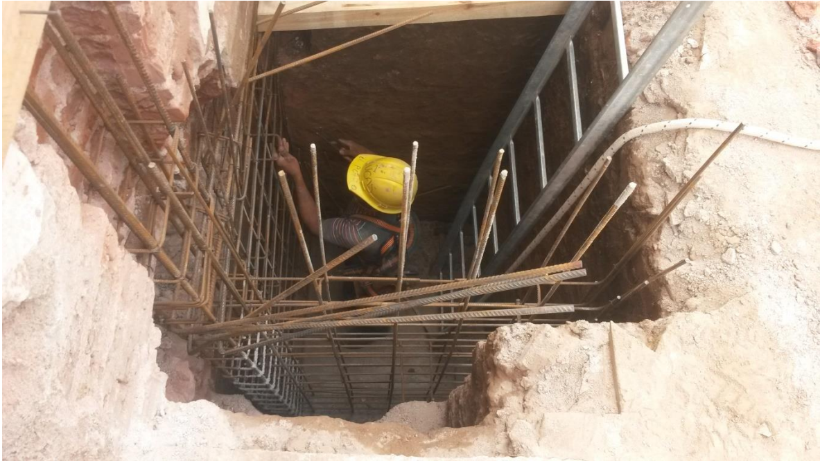
Figura 5.3: Armadura de tabique
