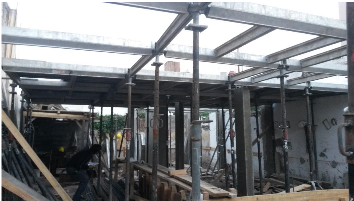
Figura 6.1.10: Encofrado de losa sobre planta baja
