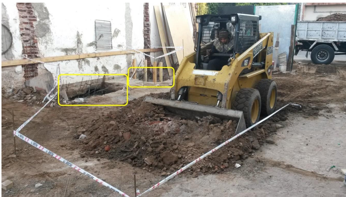
Figura 3.7: Demarcación y excavación mecánica de subsuelo
