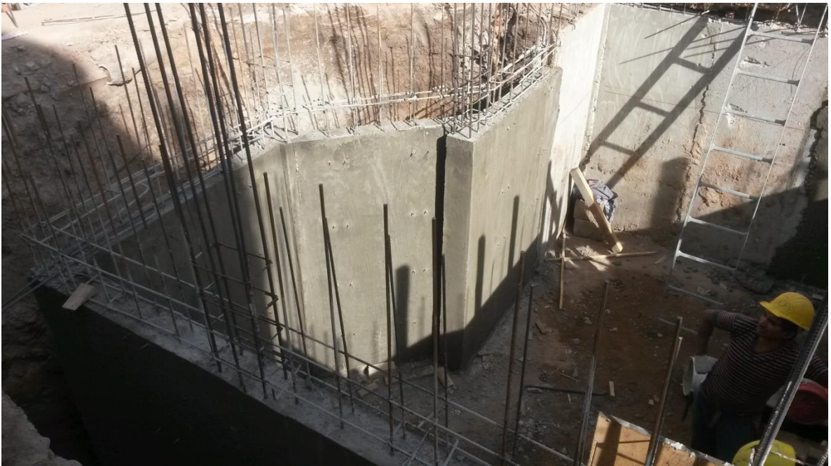
Figura 5.23: Desencofrado de tabique
