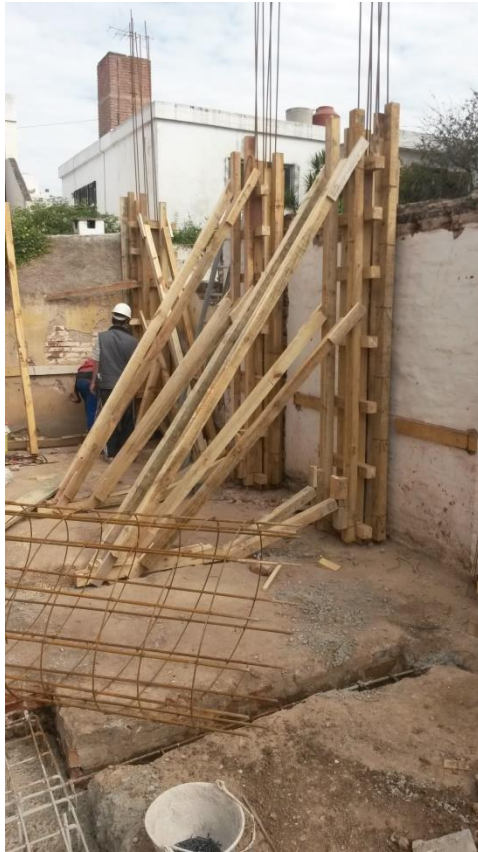
Figura 6.1.1: Encofrado de columnas
