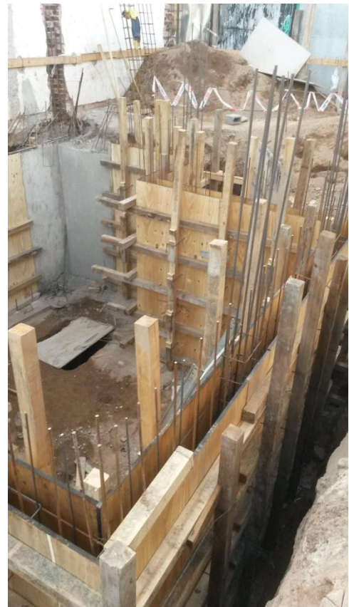
Figura 5.18: Refuerzos de encofrado
