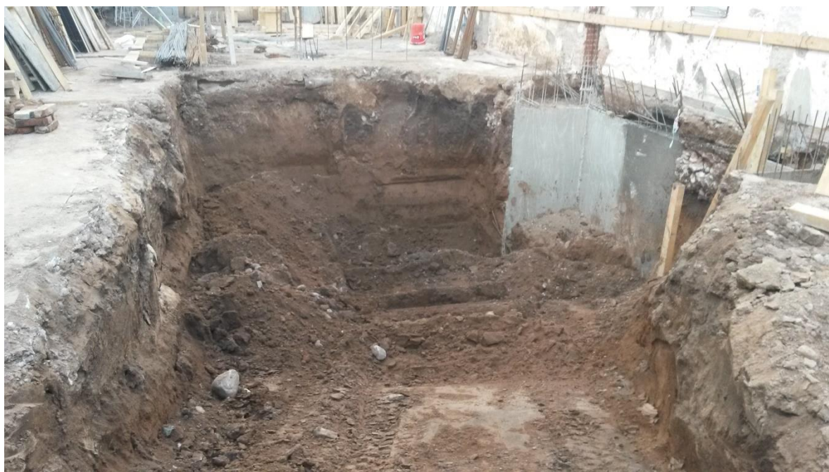
Figura 3.11: Subsuelo excavado
