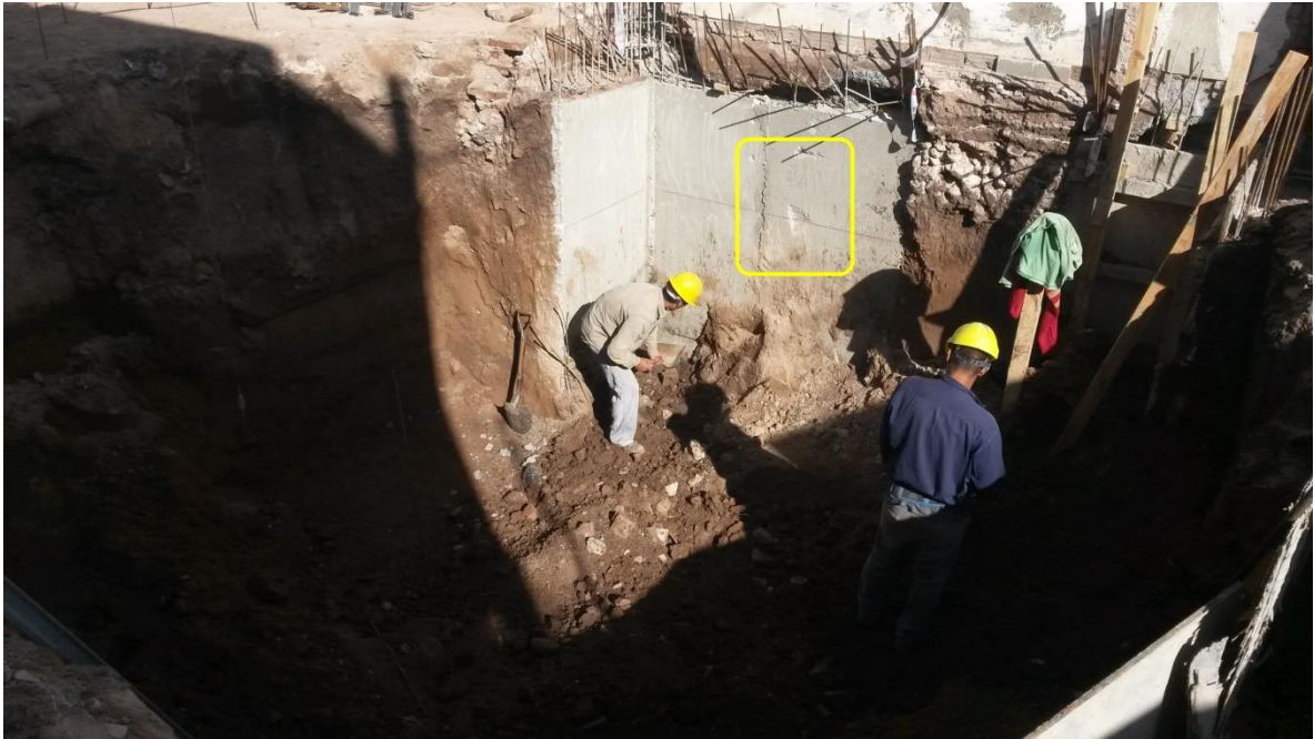
Figura 3.12: Excavación manual de subsuelo
