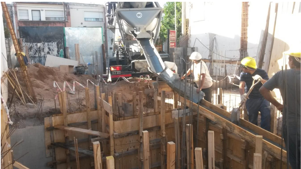
Figura 5.19: Hormigonado de tabique de subsuelo
