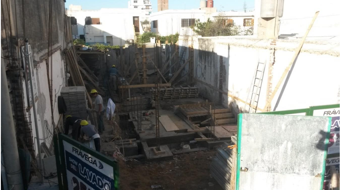
Figura 6.1.9: Fotografía panorámica de la obra
