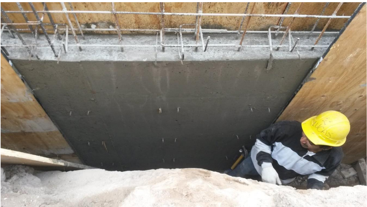
Figura 5.21: Desencofrado de tabique
