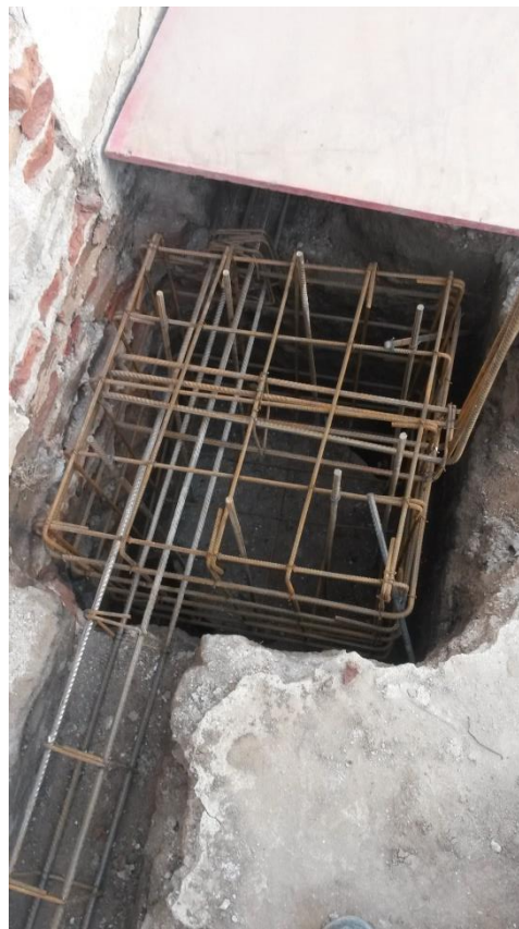
Figura 4.8: Armadura en posición
