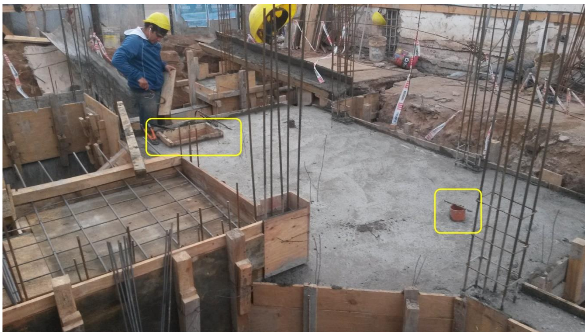
Figura 5.32: Losa sobre subsuelo hormigonada; pases de losa
