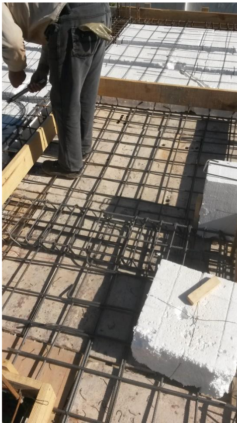
Figura 6.2.3: Losas rebajadas
