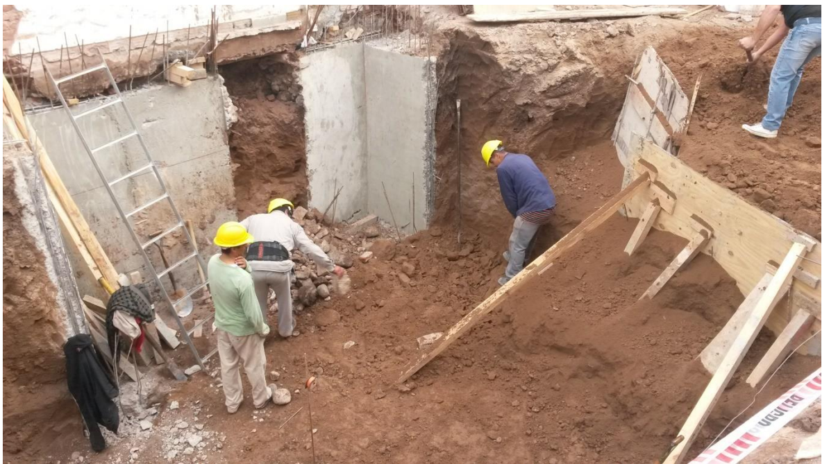
Figura 3.13: Excavación manual de subsuelo
