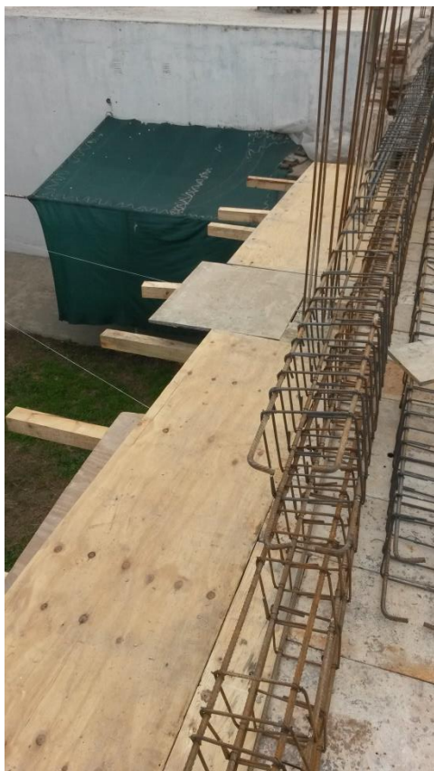
Figura 6.1.14: Encofrado de viga de borde Figura 6.1.15: Encofrado de viga de borde
