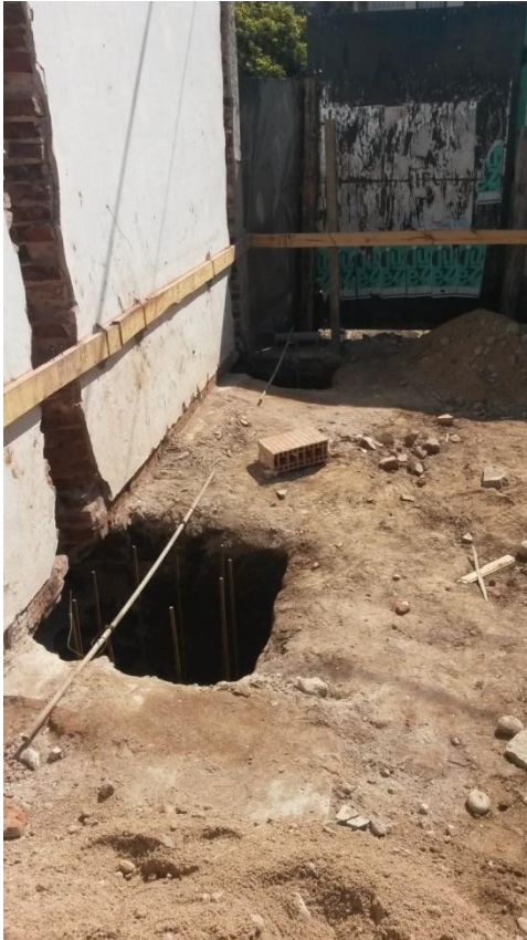
Figura 4.5: Armadura en posición
