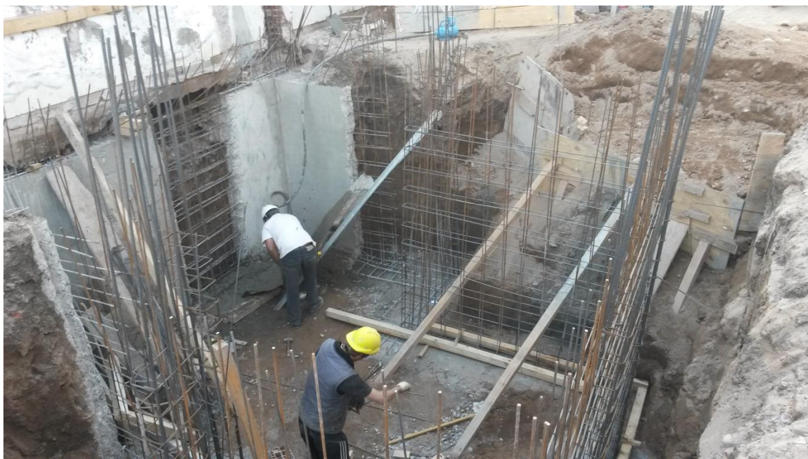
Figura 5.15: Vista panorámica de la armadura del tabique de subsuelo
