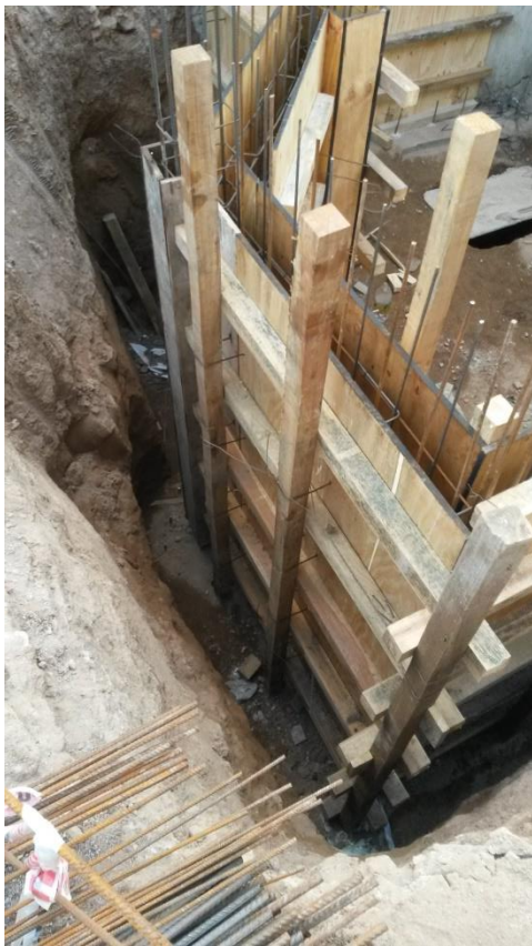
Figura 5.17: Refuerzos de encofrado
