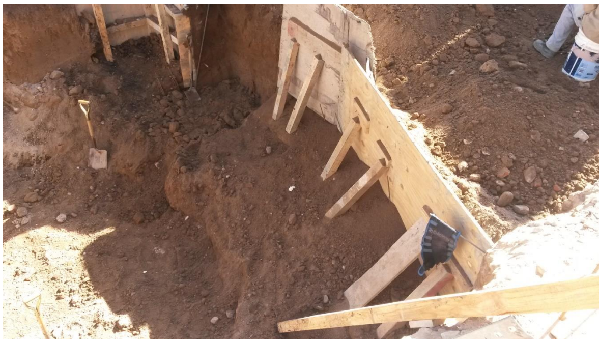
Figura 3.14: Entibado de material suelto
