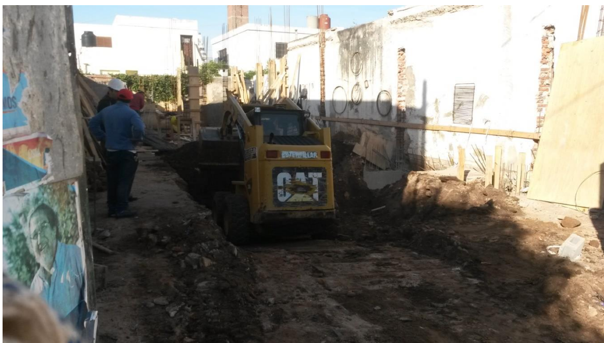
Figura 3.8: Excavación mecánica de subsuelo
