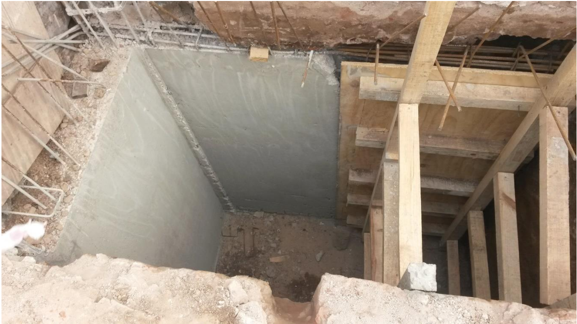
Figura 5.5: Tabique de subsuelo, tramo hormigonado y tramo encofrado
