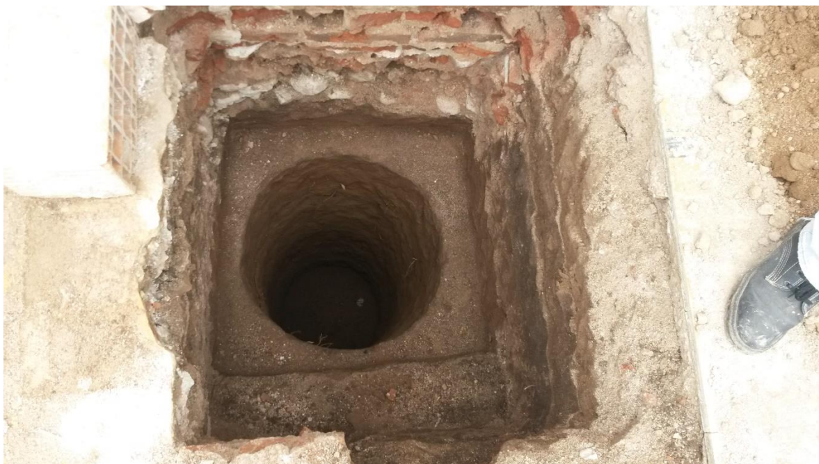
Figura 3.2: Pozo excavado
