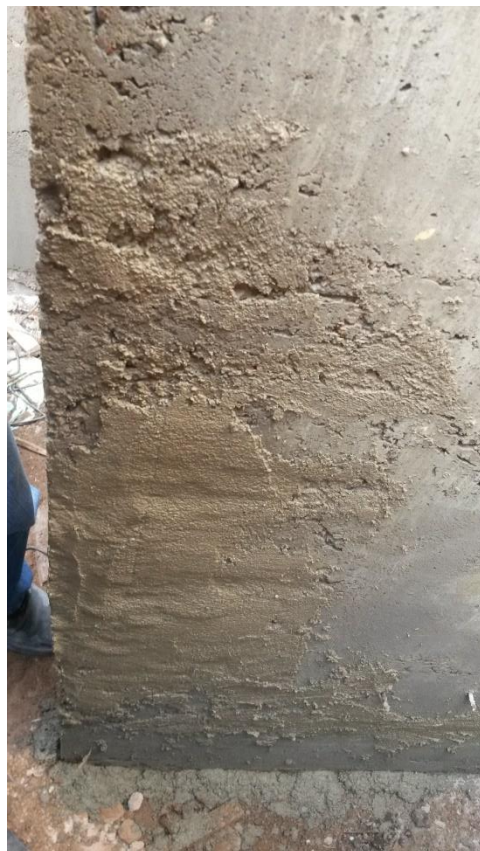
Figura 5.26: Reparación de oquedad en tabique
