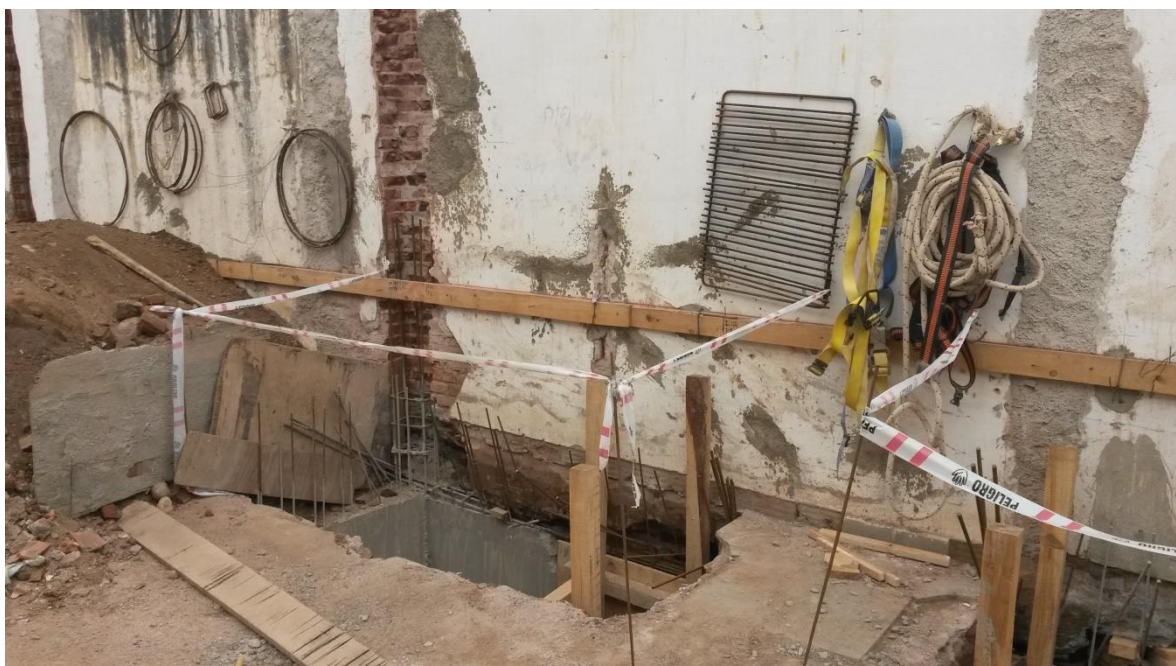
Figura 3.6: Vallado de excavaciones
