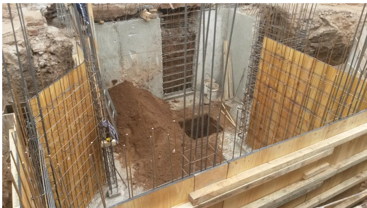
Figura 5.27: Excavación de pozo achique en subsuelo
