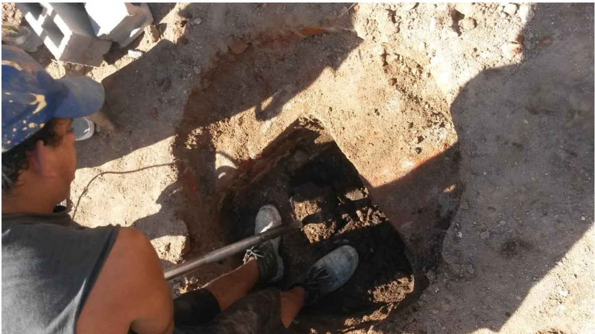
Figura 3.1: Excavación de pozos
