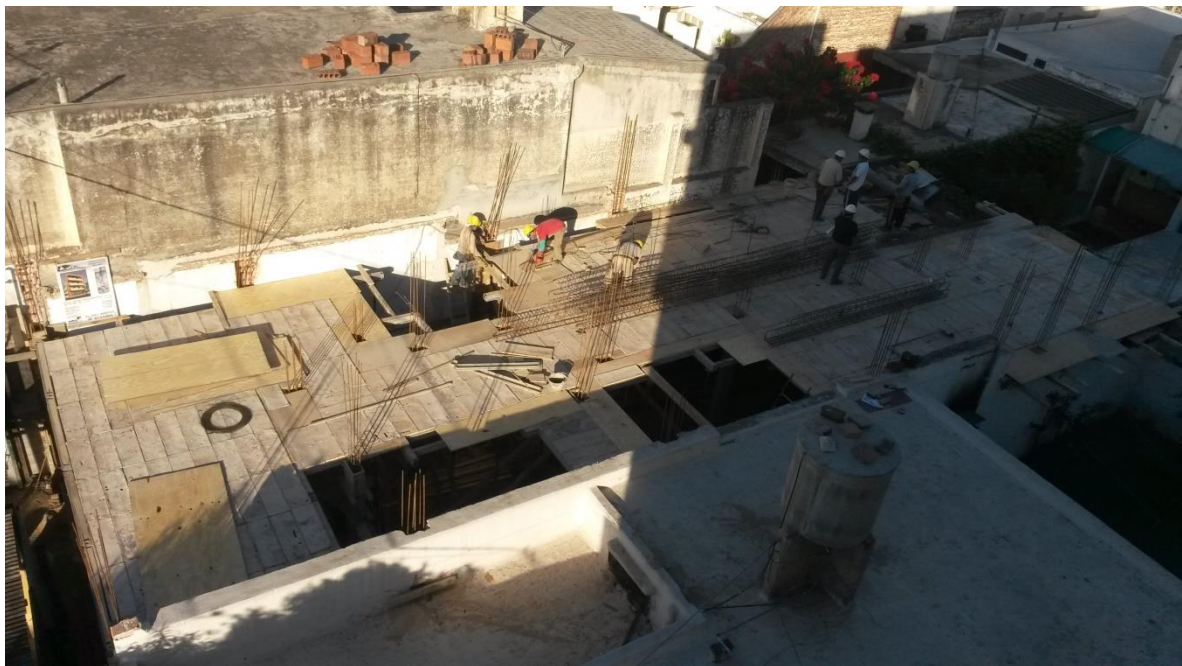
Figura 6.2.1: Imagen panorámica del encofrado de losa sobre planta baja
