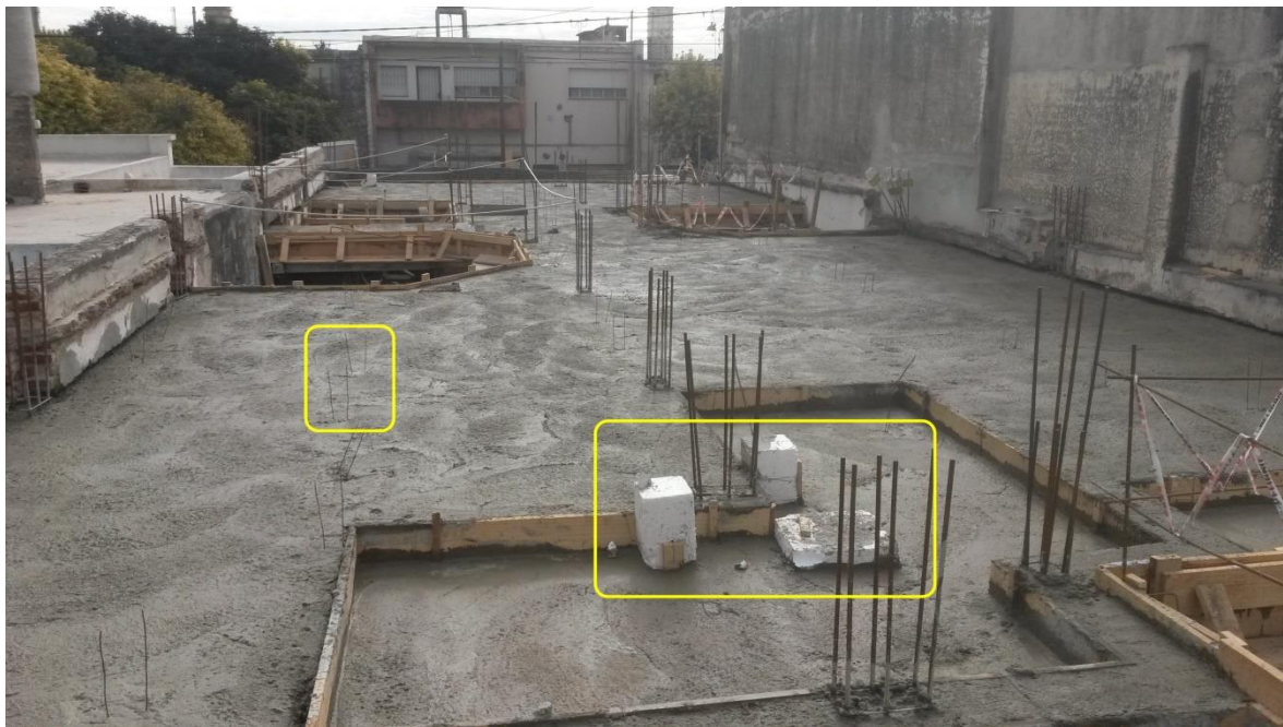
Figura 6.4.7: Vista panorámica de losa hormigonada; pases de losa
