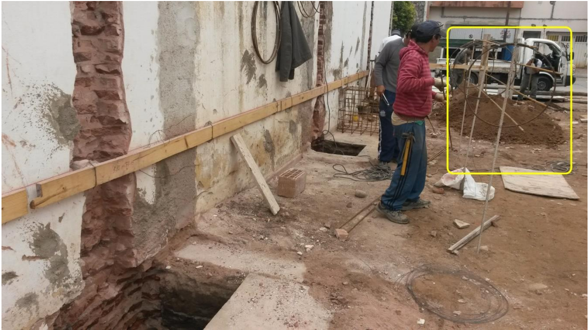
Figura 4.2: Armadura de pilotes
