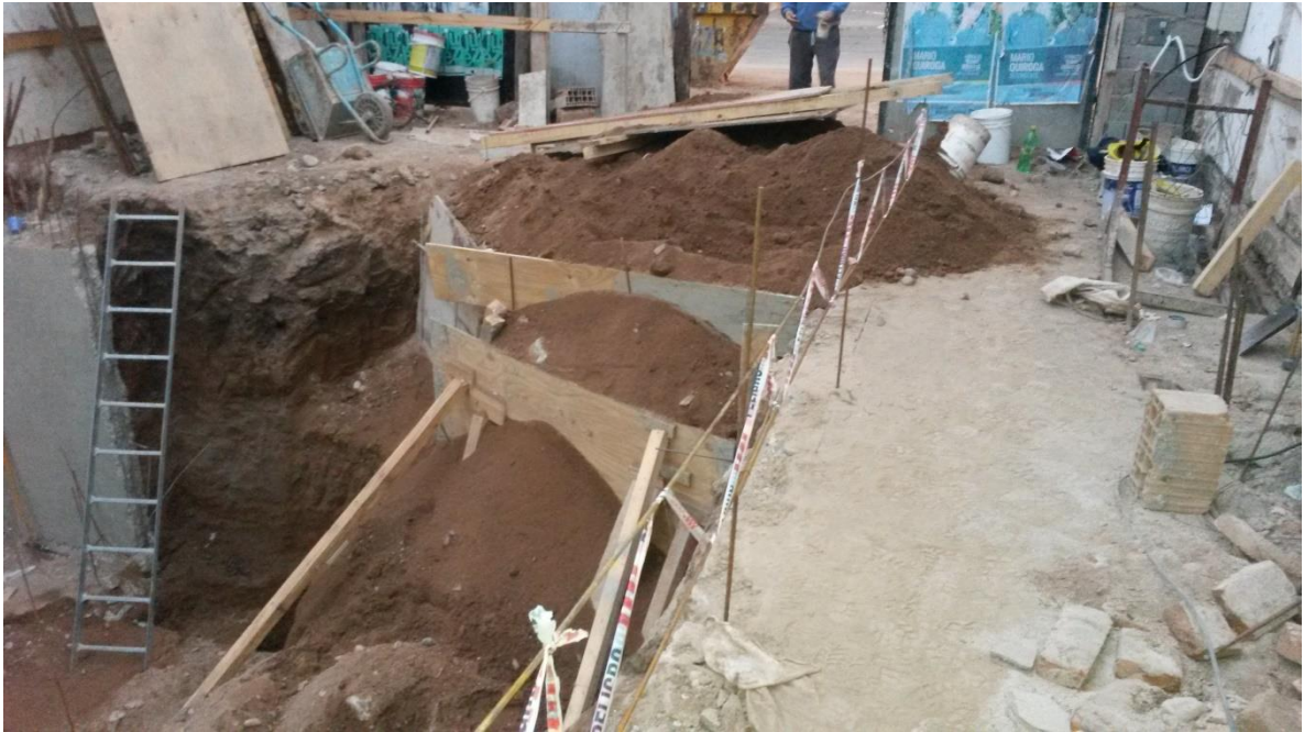
Figura 3.15: Entibado de material suelto
