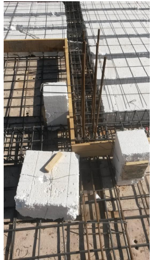
Figura 6.2.4: Losas rebajadas
