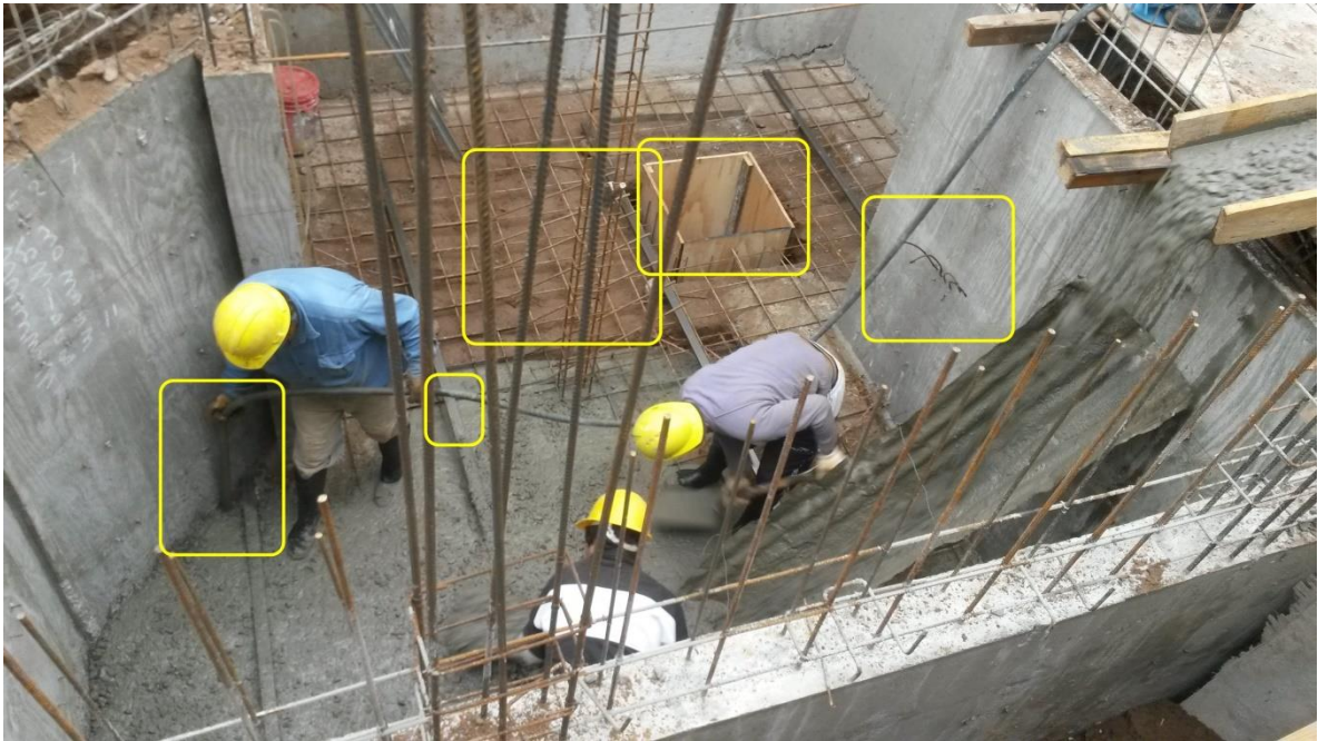
Figura 5.28: Colado de losa de piso de subsuelo
