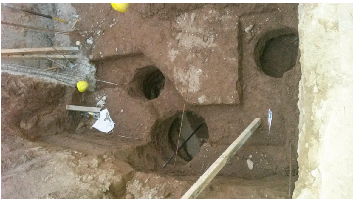
Figura 3.16: Excavación de fundaciones de tabique de subsuelo
