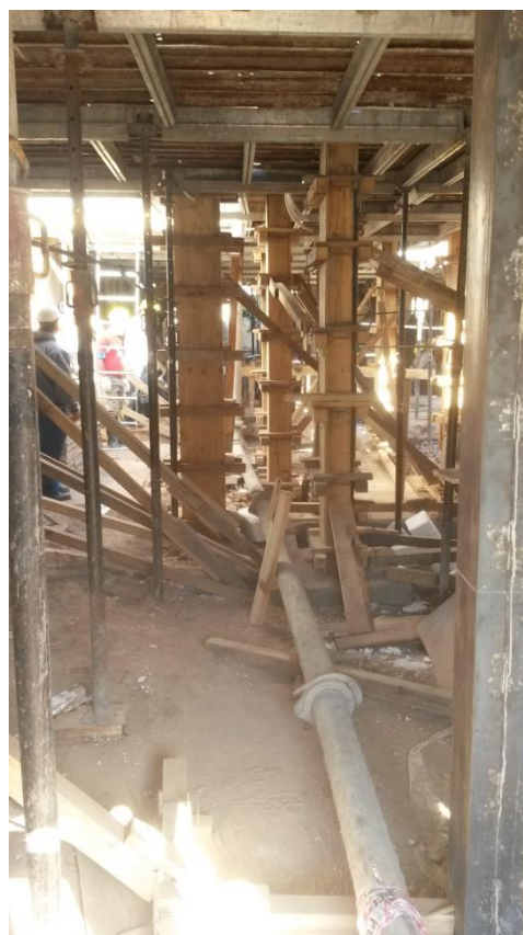
Figura 6.4.1: Bomba de hormigón Figura 6.4.2: Conducción de hormigón bombeado
