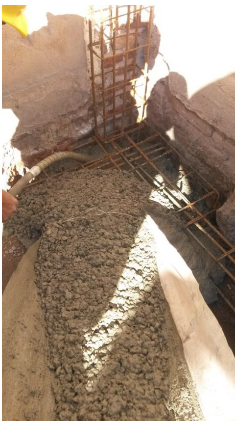
Figura 4.12: Hormigonado de cabezal
