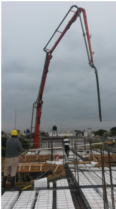
Figura 6.4.4: Grúa de autobomba de hormigón
