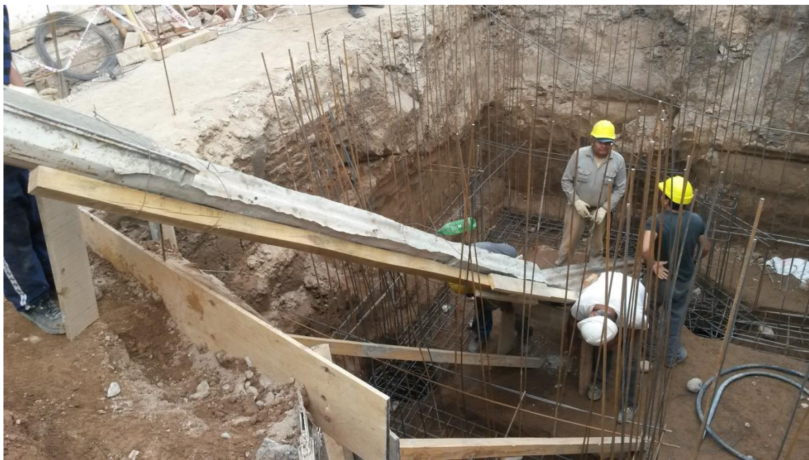
Figura 5.10: Colado del hormigón de zapata de fundación
