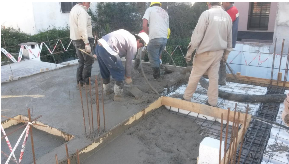
Figura 6.4.5: Colado de losa
