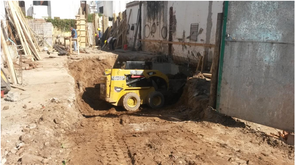
Figura 3.9: Excavación mecánica de subsuelo
