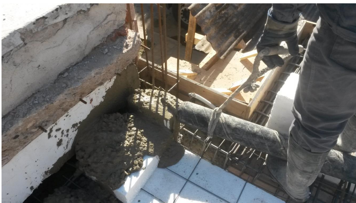
Figura 6.4.3: Colado de hormigón
