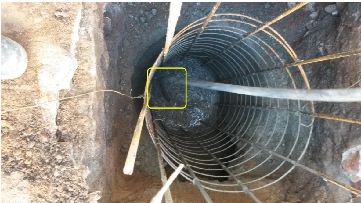
Figura 4.10: Vibrado del hormigón fresco
