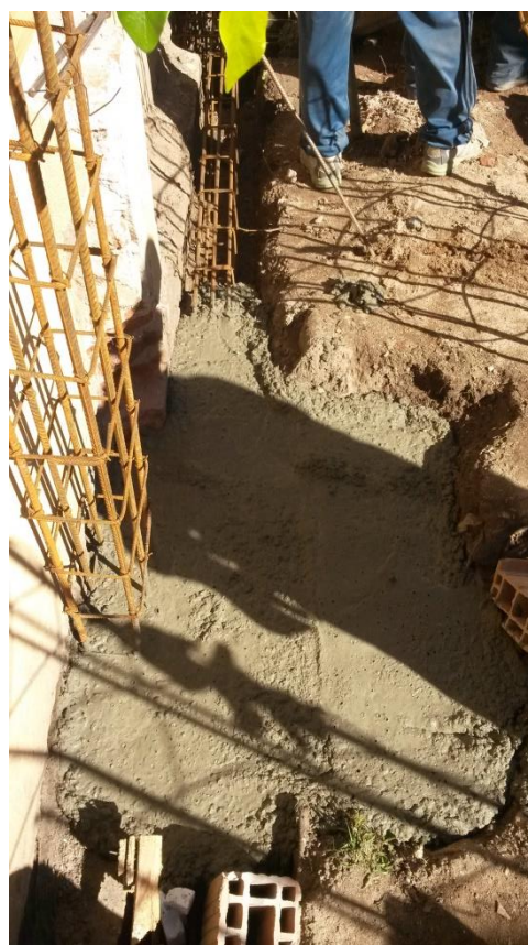
Figura 4.13: Cabezal hormigonado
