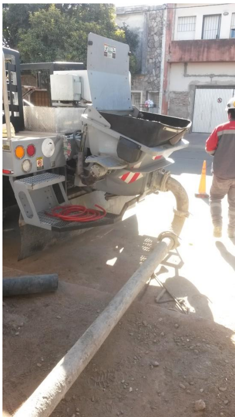
Figura 6.4.1: Bomba de hormigón Figura 6.4.2: Conducción de hormigón bombeado
