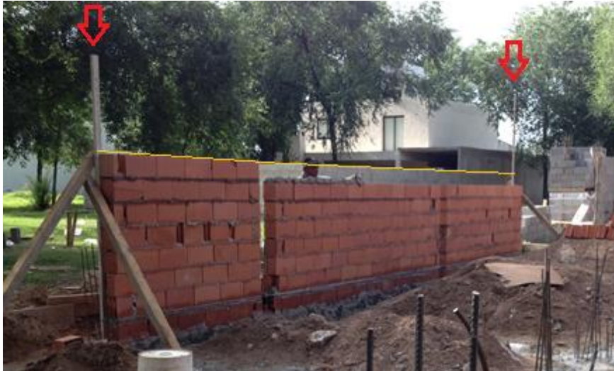
Figura 54: Levantamiento de muro
