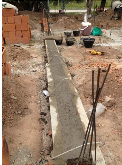
Figura 32: Capa aisladora horizontal de mortero
