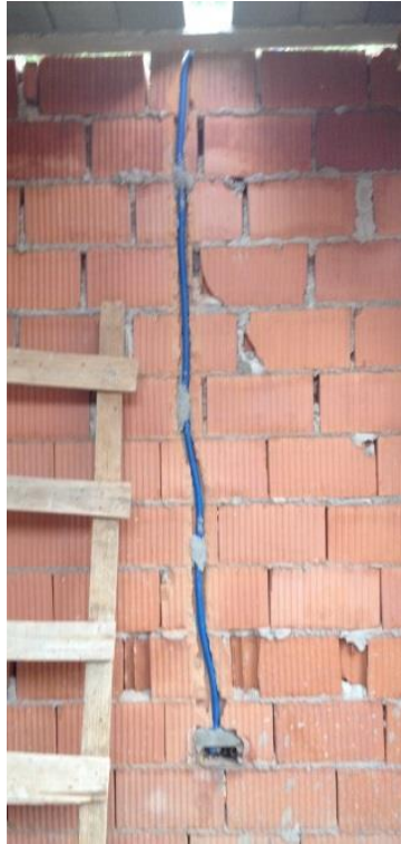
Figura 87: Cañerías sujetas al muro con mortera conectadas al toma corriente
