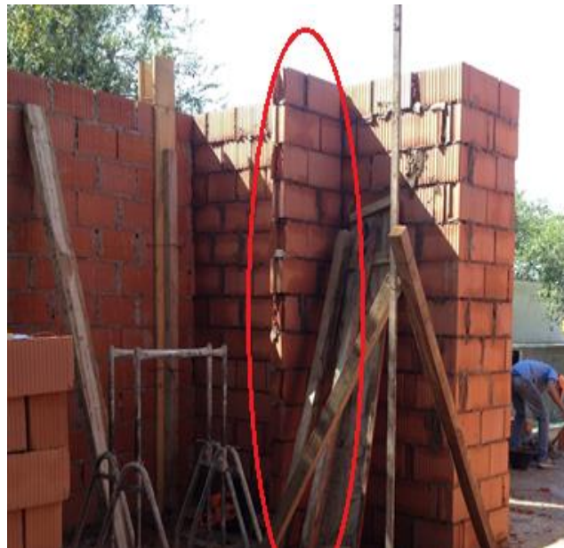
Figura 45: Muro interior no estructural
