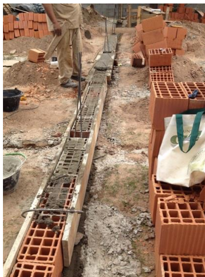
Figura 31: Capa aisladora horizontal de mortero
