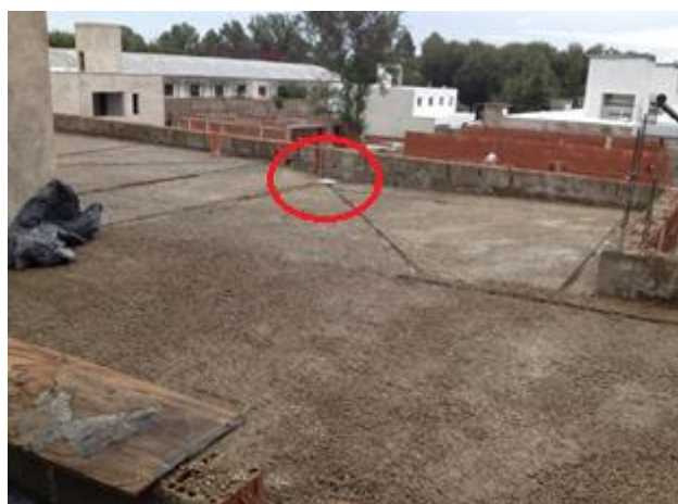
Figura 92: Embudo horizontal
