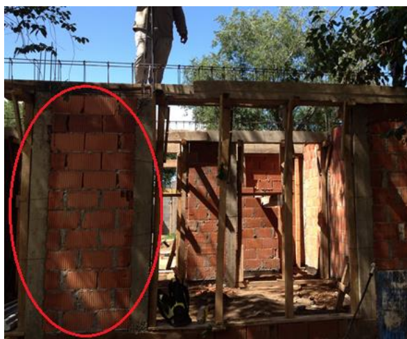
Figura 39: Muro de frente
