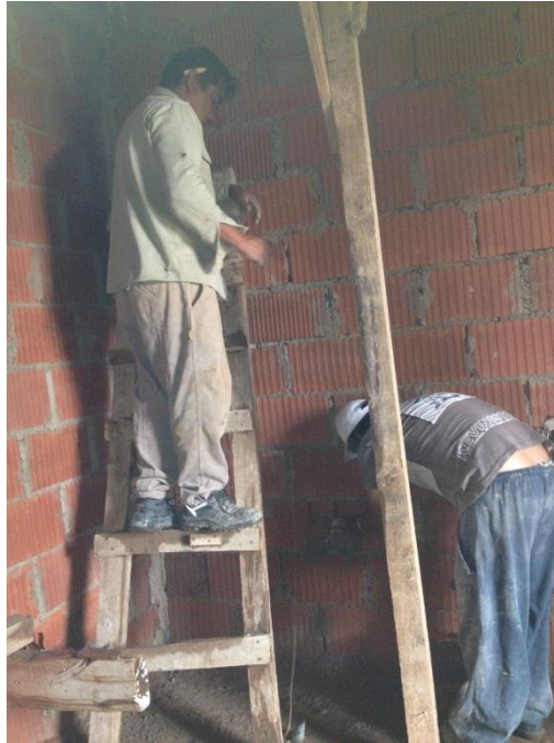
Figura 118: Trabajo sobre escalera
