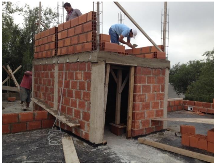
Figura 48: Muros de tanque
