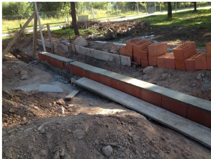
Figura 33: Capa de mortero seco
