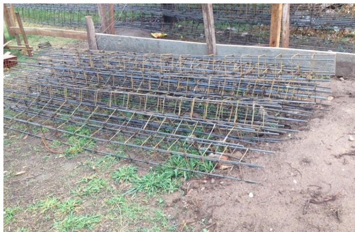
Figura 57: Armaduras de los encadenados verticales
