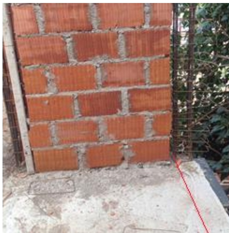
Figura 50: Replanteo de muro en PA
