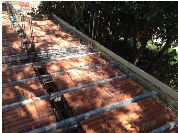
Figura 78: Armadura de columna en espera en losa en voladizo
