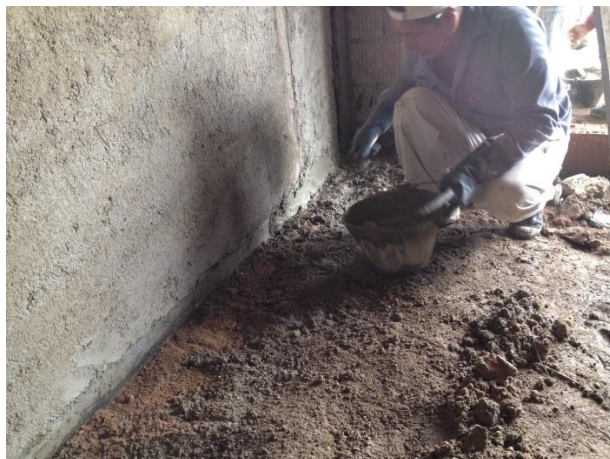
Figura 110: Zócalo con mortero de cemento
