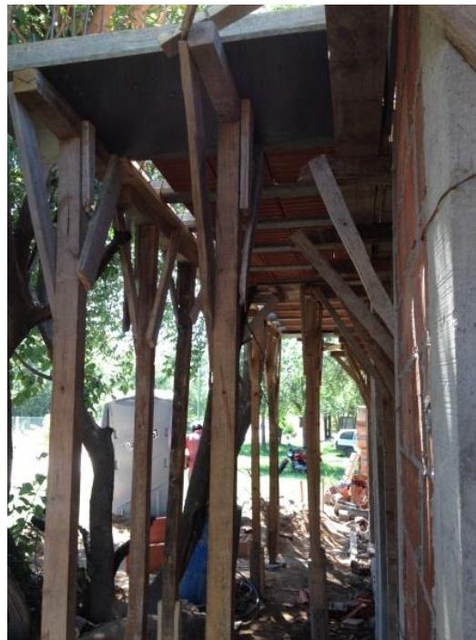
Figura 76: Encofrado para losa en voladizo
