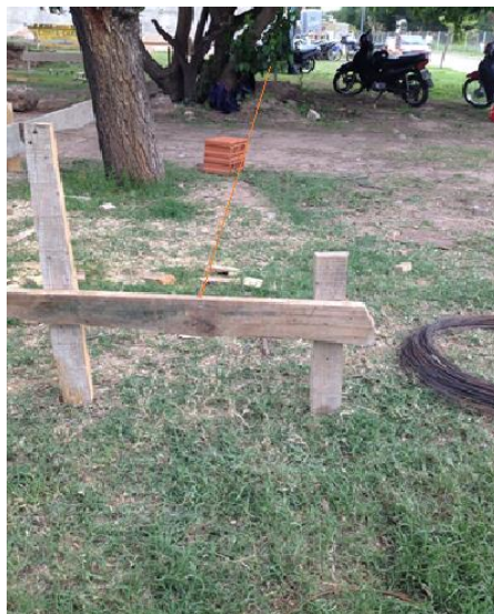
Figura 15: Eje de replanteo principal XX
