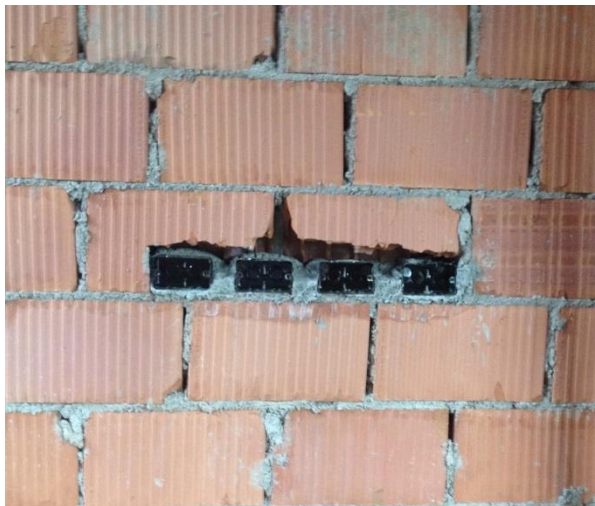
Figura 86: Colocación de cajas rectangulares
