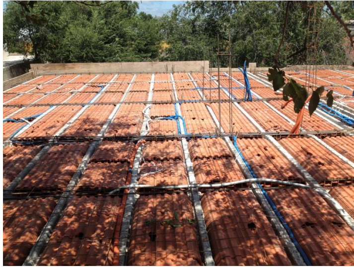
Figura 79: Malla de hierro de 4,2mm de diámetro
