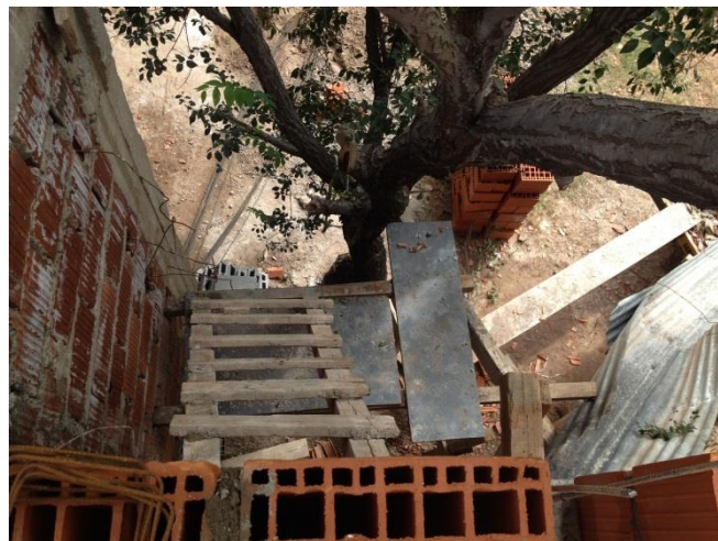
Figura 117: Escalera para subir desde planta alta hacia el techo
