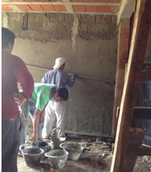
Figura 109: Retirando el exceso de mezcla con regla
