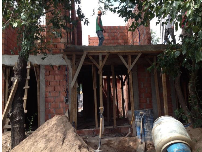
Figura 65: Vigas desencofradas
