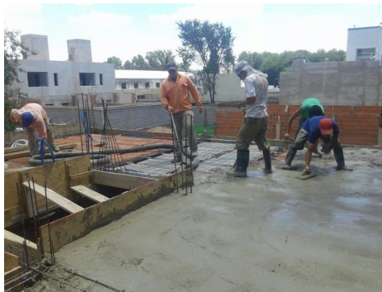
Figura 112: Hormigonando. Algunos trabajadores utilizando ropa de trabajo adecuada y botas de goma, otros con remeras mangas cortas y zapatillas. Nadie utiliza casco y protección contra caída
