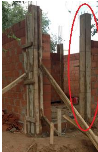
Figura 61: Encadenado vertical aislado
