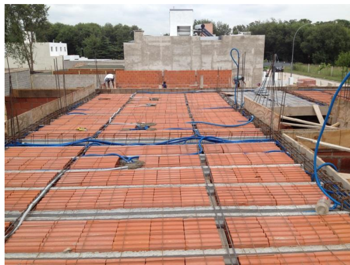
Figura 64: Vigas con cañerías para la instalación eléctrica
