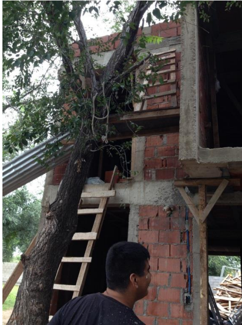
Figura 115: Escaleras que permanecieron por un tiempo considerable
