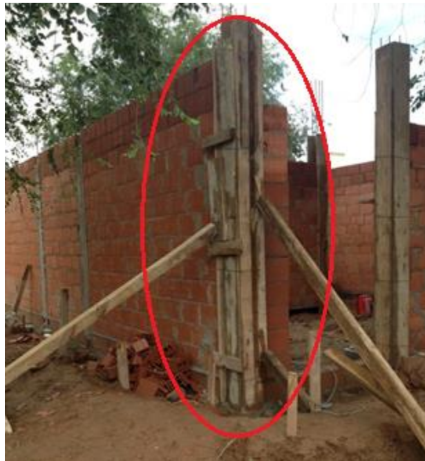
Figura 59: Encadenado vertical esquina
