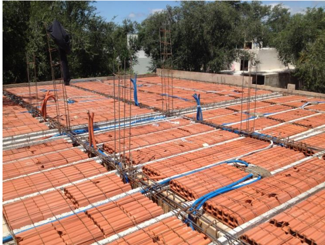
Figura 73: Cañería para la instalación eléctrica y armadura en espera de encadenados
