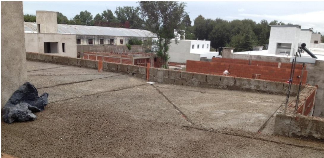
Figura 106: Relleno de pendiente aislante térmico
