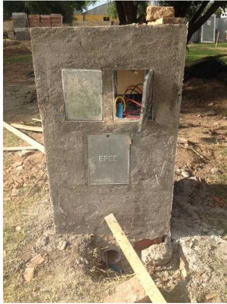
Figura 84: Frente del pilar de medición
