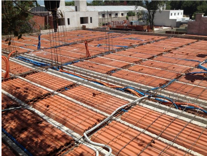
Figura 89: Cañerías pasantes por losa y vigas
