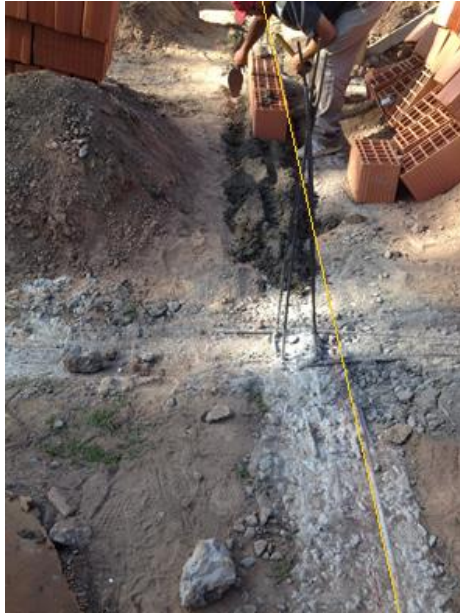
Figura 49: Replanteo de muro en PB
