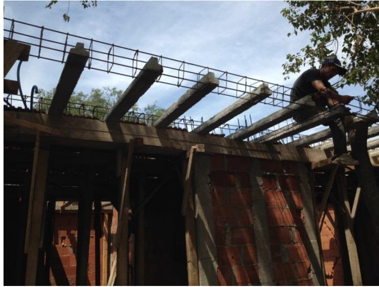
Figura 75: Viguetas para losa en voladizo
