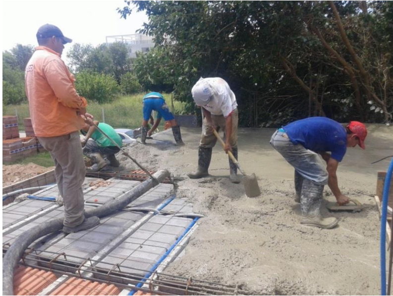
Figura 82: Distribución del hormigón
