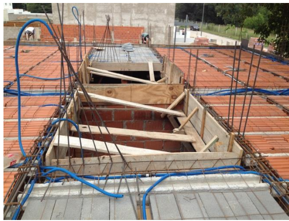
Figura 74: Armadura en espera de escalera
