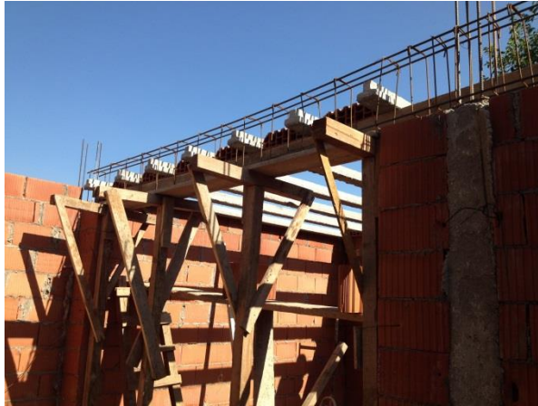
Figura 69: Viguetas apoyando en vigas
