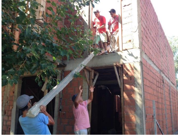
Figura 71: Manipulación de viguetas para losa de techo
