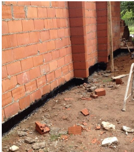
Figura 38: Pintura asfáltica
