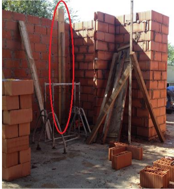
Figura 60: Encadenado vertical centrado
