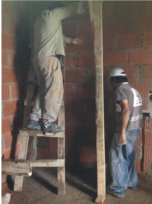
Figura 107: Aplomando el bolín superior con su correspondiente inferior.
