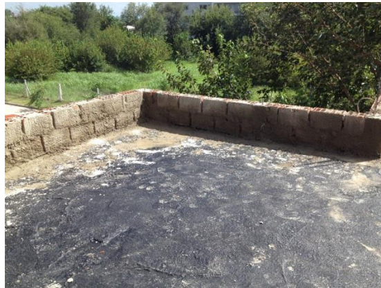
Figura 102: Parapeto revocado
