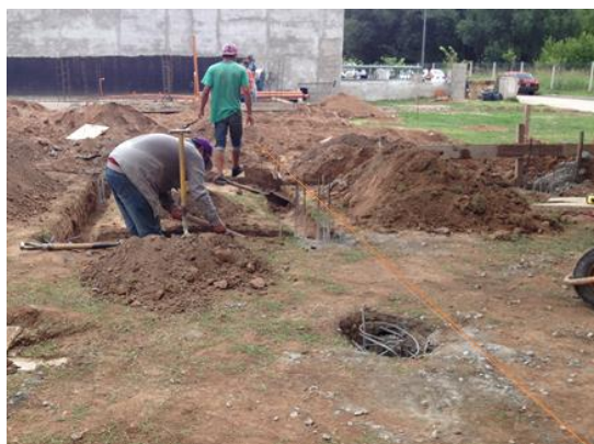
Figura 25: Demarcación de la zona a excavar
