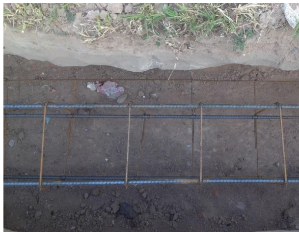
Figura 43: Viga de muro aislado
