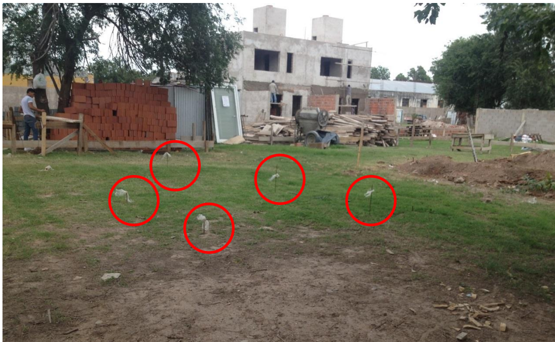
Figura 17: Replanteo de pilotes
