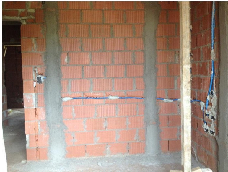
Figura 108: Fajas para hacer el revoque
