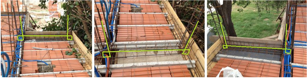
Figura 77: Armaduras de anclaje del voladizo
