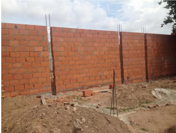
Figura 58: Armadura del encadenado vertical colocada
