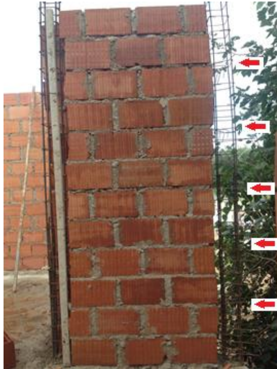
Figura 55: Muro de mampostería con barras de acero intercaladas
