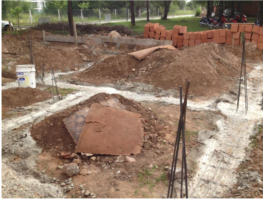
Figura 30: Viga Portamuros
