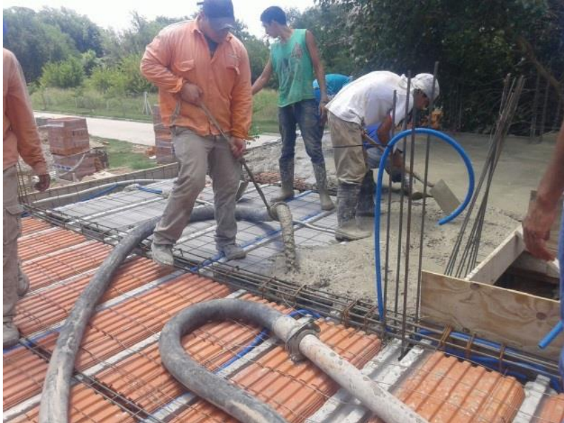
Figura 81: Colado del hormigón
