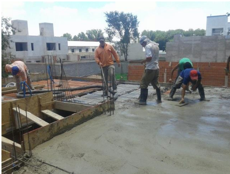
Figura 83: Terminación de superficie con fratás
