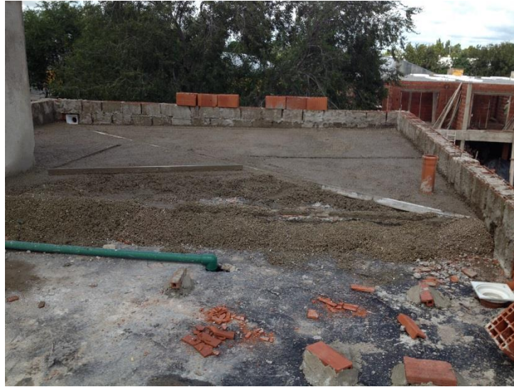
Figura 105: Relleno de pendiente aislante térmico
