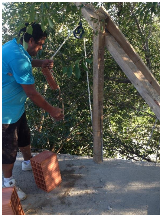
Figura 119: Manipulación mecánica de los materiales mediante equipo de izar
