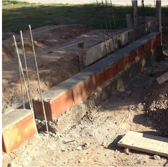
Figura 46: Mampostería de fundación
