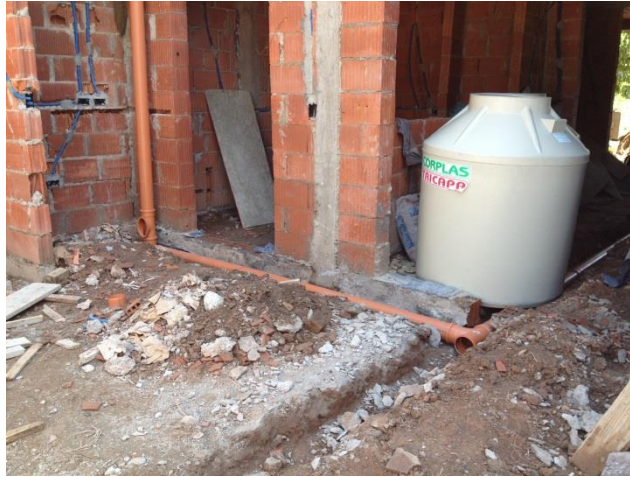
Figura 93: Instalación sanitaria pluvial de fondo, ramal T
