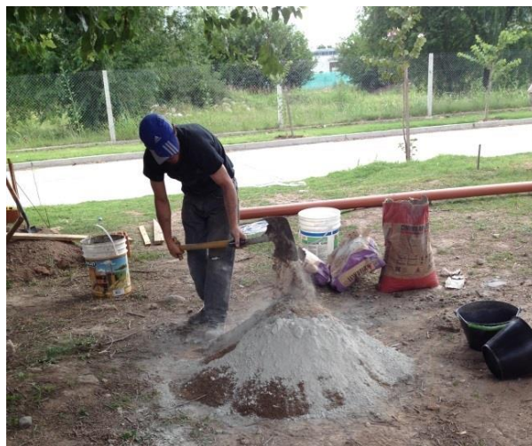
Figura 53: Mezclado manual
