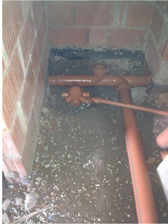
Figura 96: Instalación sanitaria cloacal de baño
