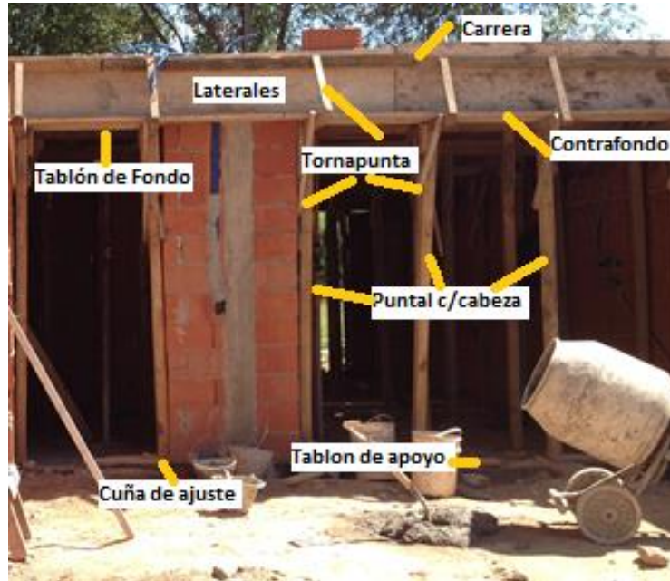
Figura 63: Encofrado de viga
