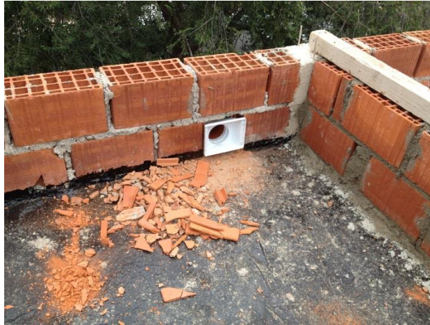
Figura 90: Embudo vertical
