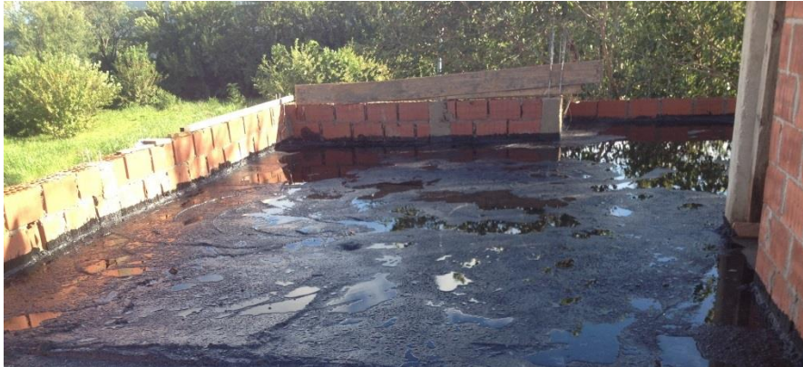
Figura 101: Barrera de vapor
