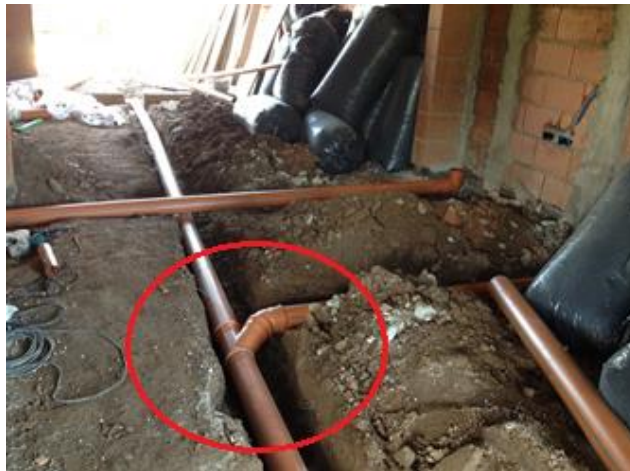
Figura 94: Conexión de bajadas pluviales
