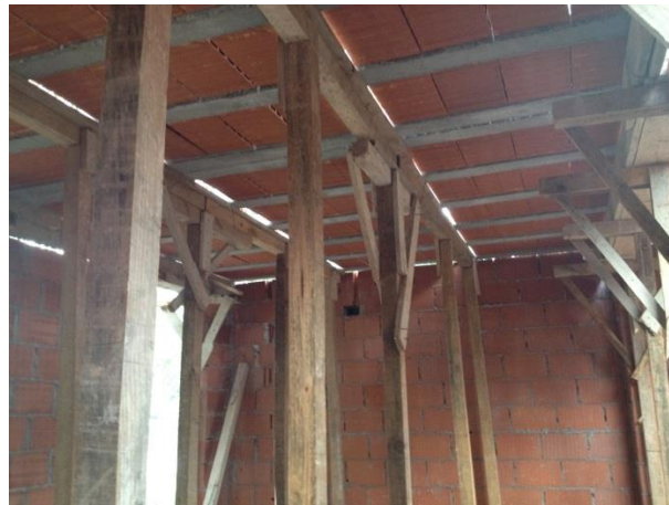
Figura 72: Apuntalamiento de nervios transversales
