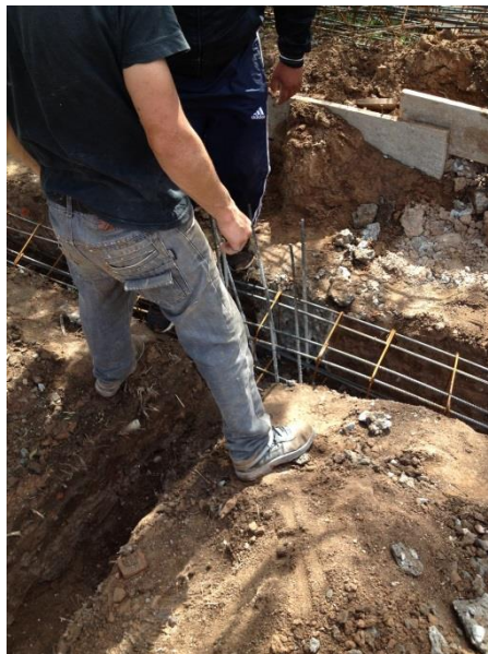
Figura 29: Unión de viga portamuros y pilote
