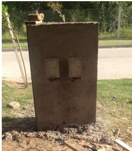
Figura 85: Posterior del pilar de medición
