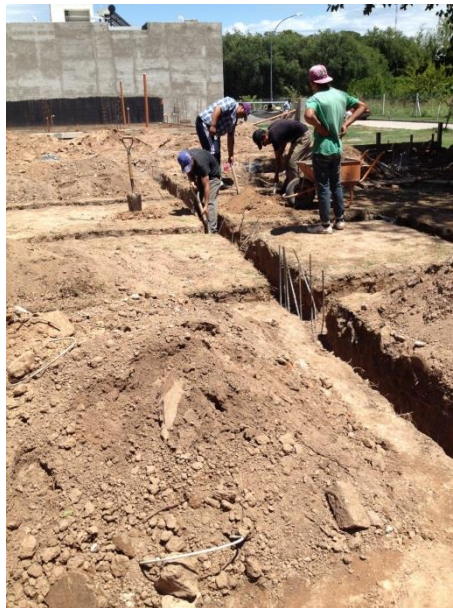
Figura 27: Excavación para viga portamuro
