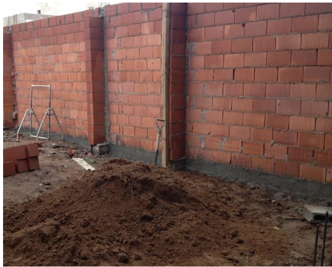
Figura 37: Mortero cemento hidrófugo
