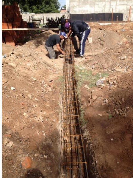
Figura 28: Colocación de la armadura
