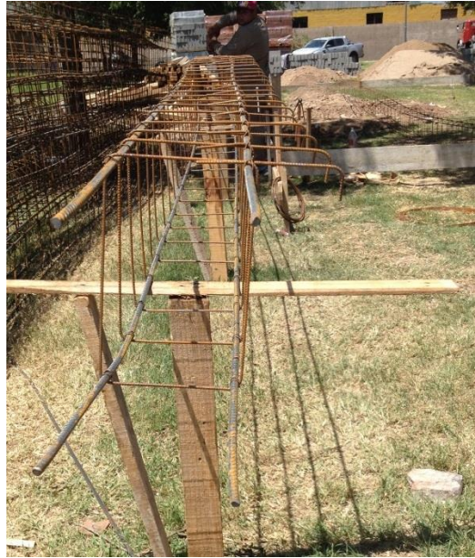
Figura 44: Armadura de viga de muro aislado
