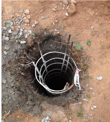
Figura 23: Perforación con armadura
