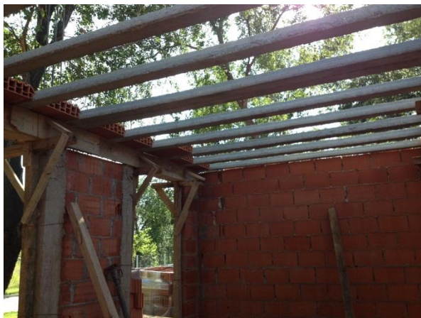
Figura 70: Viguetas colocadas a una distancia igual al ancho del ladrillo
