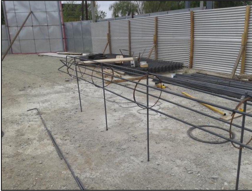
Figura N° 25: Armado de los cilindros.
