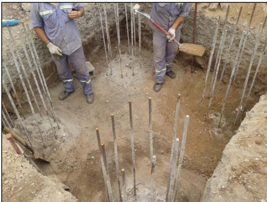
Figura N° 67: Cabezal excavado.
