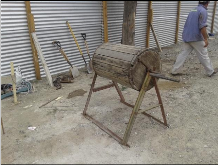
Figura N° 23: Cilindro para hacer las armaduras helicoidales de los cilindros.
