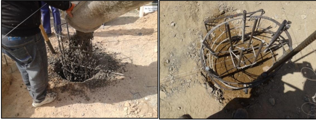
Figura N° 37: Proceso de hormigonado y resultado final.
