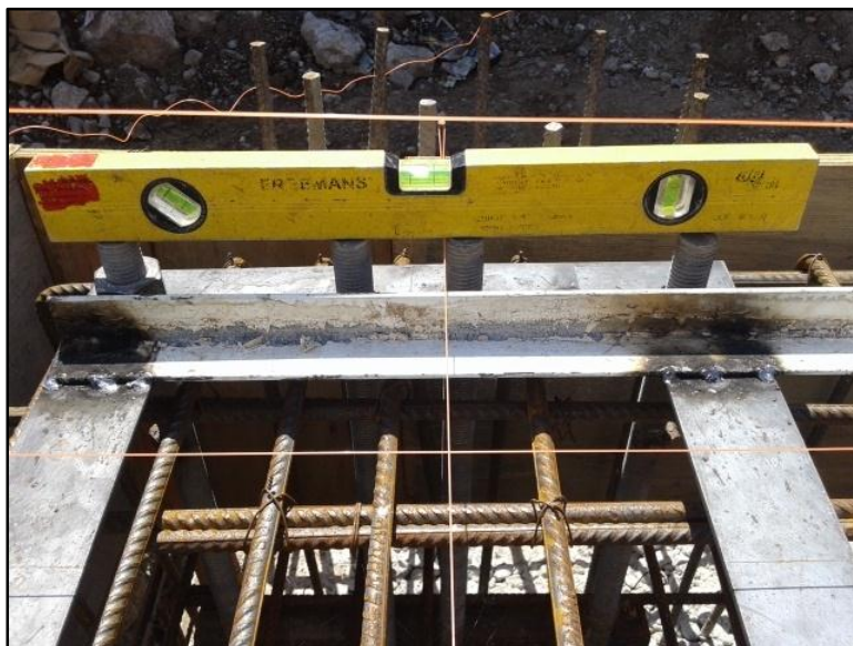
Figura N° 31: Nivelación de los insertos.
