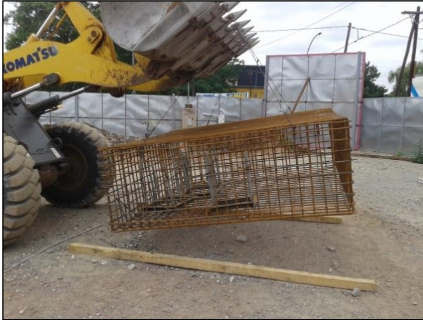
Figura N° 68: Traslado de la armadura.
