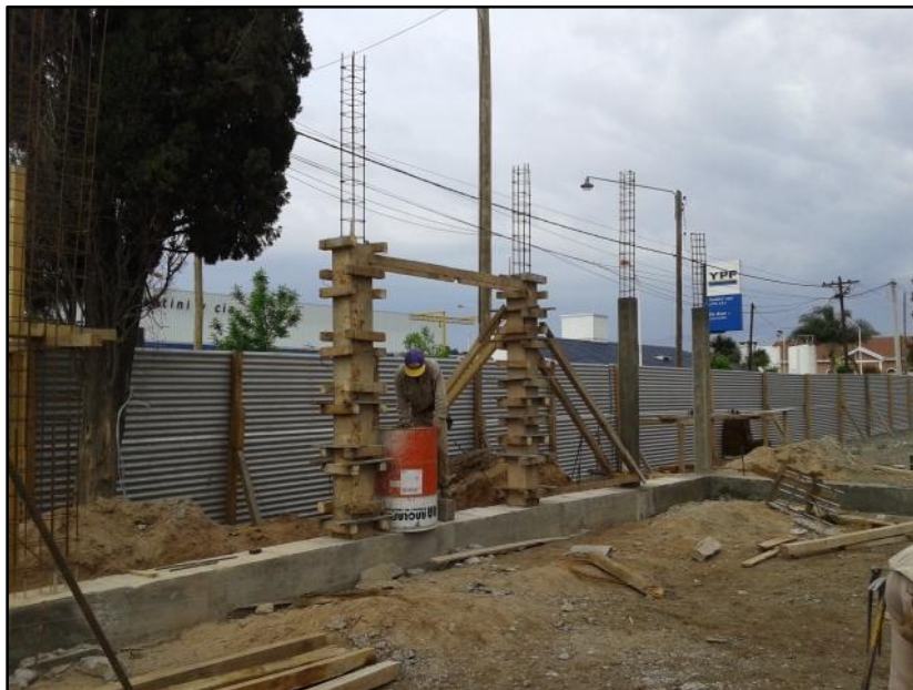
Figura N° 45: Imagen donde se puede apreciar dos columnas aun con encofrado y dos columnas ya desencofradas.
