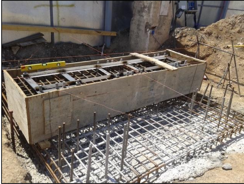
Figura N° 30: Proceso de fijación del segundo tramos del cabezal y replanteo de los insertos.
