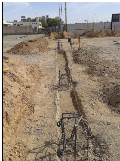
Figura N° 38: Trabajo previo para la colocación de las armaduras para las vigas.
