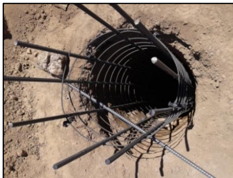
Figura N° 36: Pozo antes de ser hormigonado.
