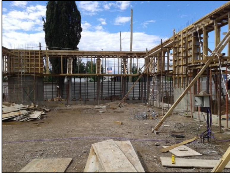
Figura N° 41: Vigas perimetrales en altura.
