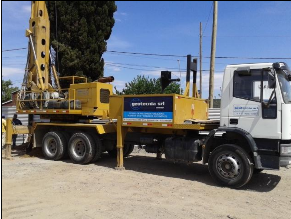
Figura N° 33: Camión con equipo de perforación.
