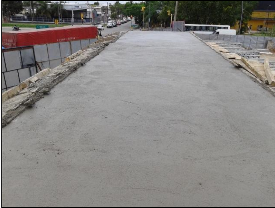
Figura Nº 63: Resultado final del hormigonado del tabique.
