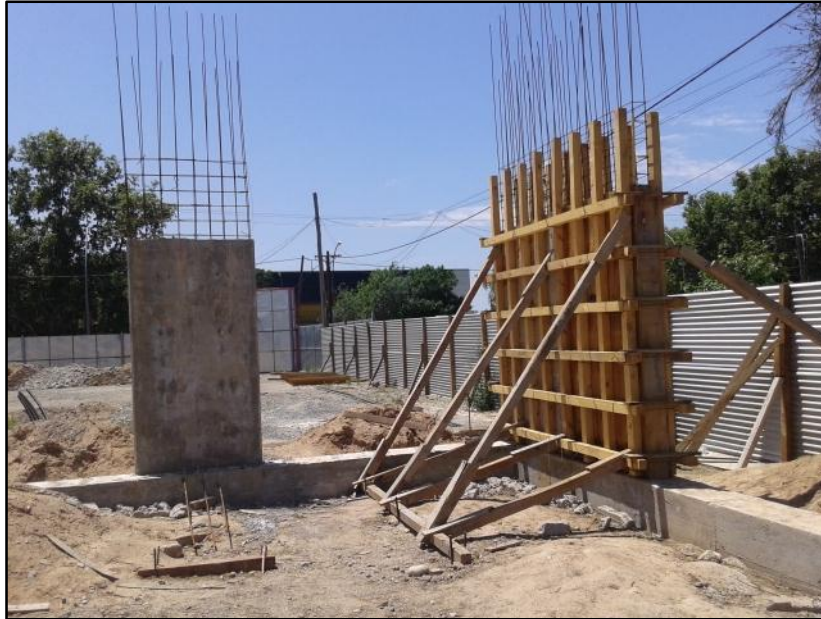
Figura N° 46: Tabique sin encofrado y otro con el encofrado aún.
