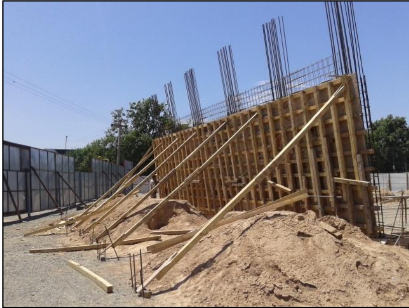
Figura N° 49: Encofrado trasero y apuntalamiento.
