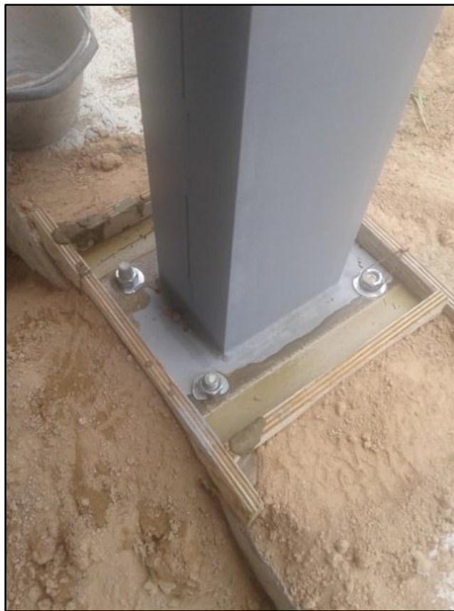
Figura N° 72: Columna metálica con pequeño encofrado en la base para el grouting.
