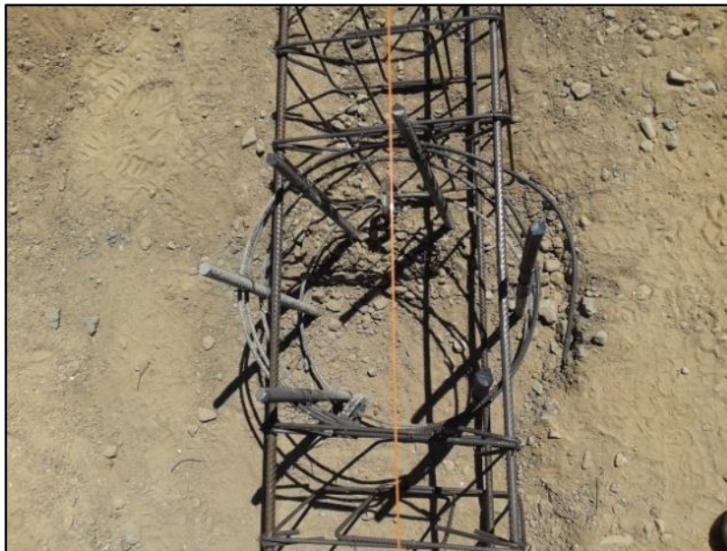
Figura N° 27: Imagen donde se ve como la viga pasa por un pozo y el eje utilizado.
