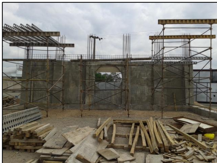
Figura N° 52: Tabique curvo sin encofrado.
