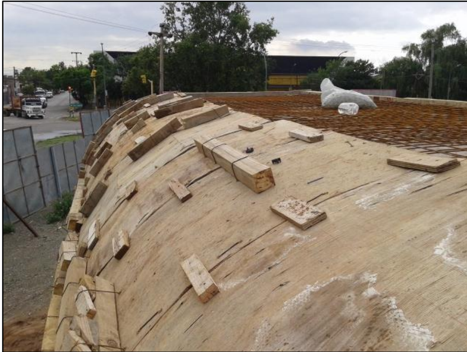
Figura N° 60: Encofrado final del tabique.
