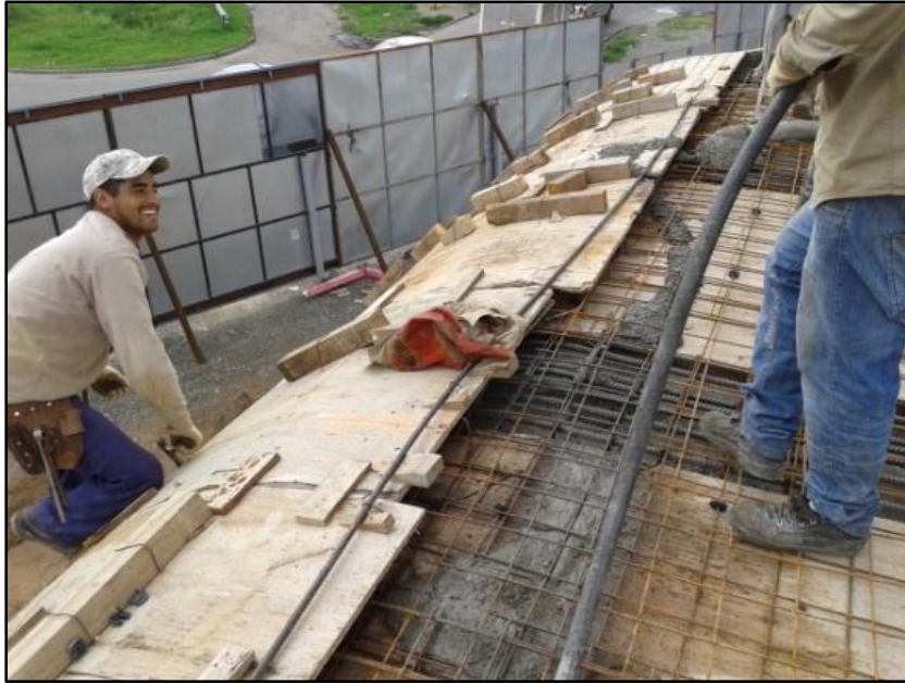
Figura Nº 61: Hormigonado de la parte curva.
