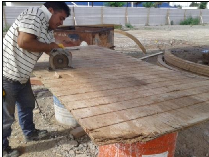
Figura N° 55: Proceso de cortado de los fenólicos.
