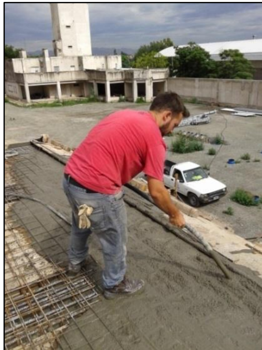
Figura Nº 62: Hormigonado de la losa. Se vibraba bien la parte que se unía con la curva para que entre todo el hormigón que se pudiera.
