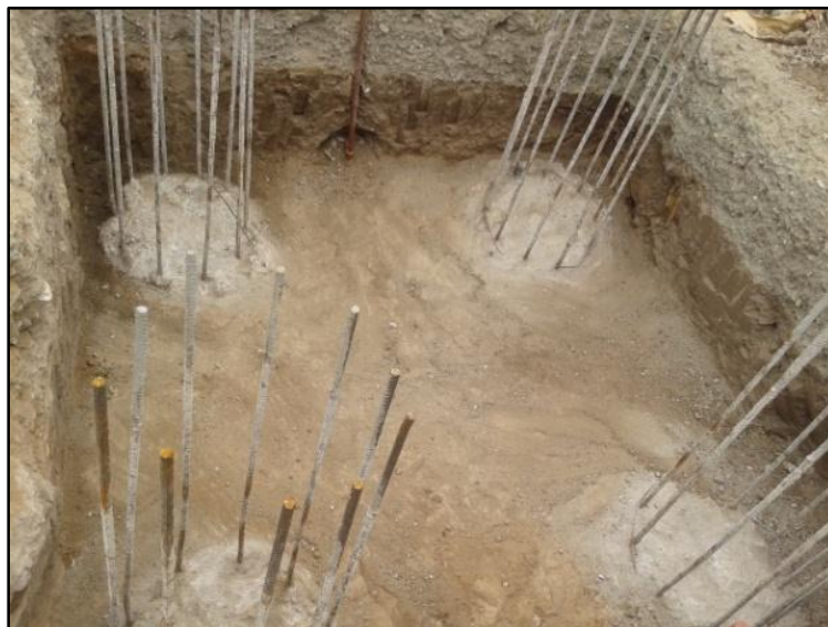
Figura N° 29: Cabezal excavado y listo para colocarse la armadura.
