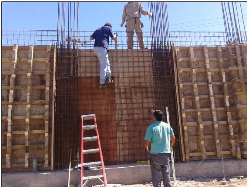
Figura N° 50: Encofrado delantero.
