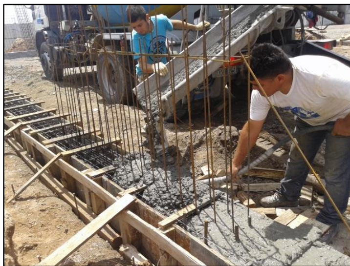
Figura N° 42: Hormigonado de una viga, donde se encontraba el primer tramo de una tabique. Aquí se puede ver como se iba vibrando.
