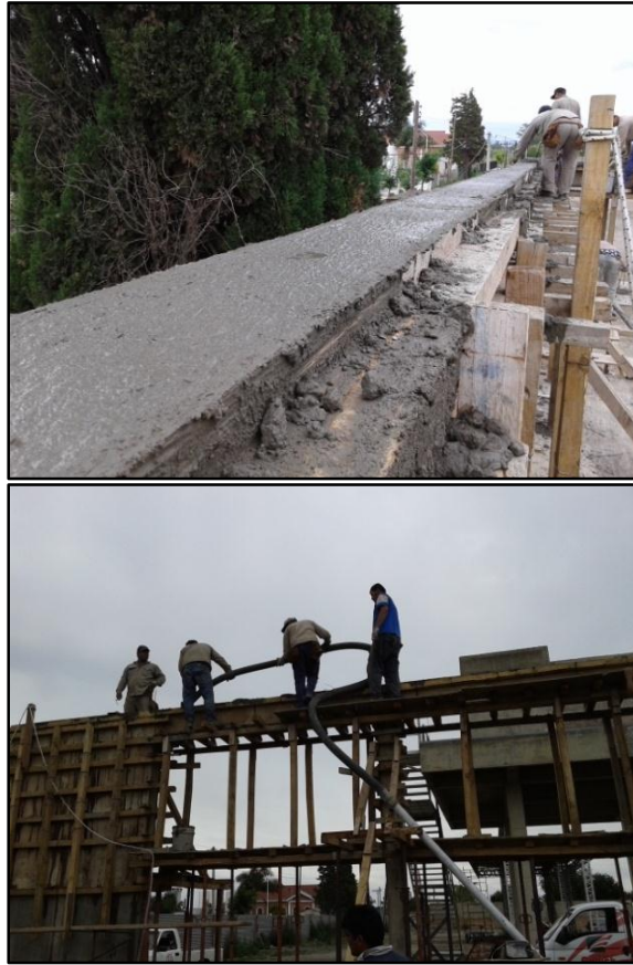
Figura N° 43: Vigas en altura terminadas y como se hormigonó.
