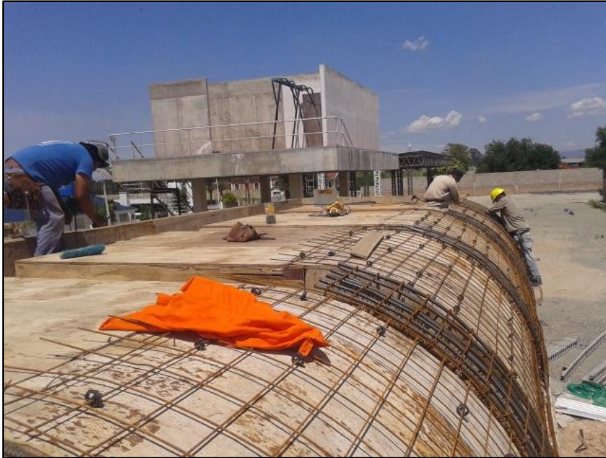
Figura Nº 58: Parte curva con su armadura.
