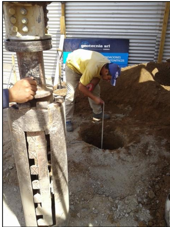
Figura N° 35: Operador de excavación corroborando la profundidad y punta cilíndrica para ensanchamiento del fondo del pozo.
