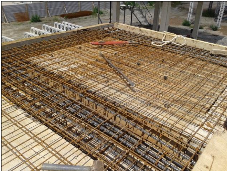
Figura Nº 59: Armadura final de la losa.
