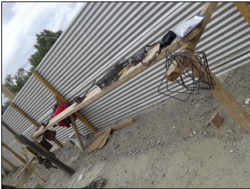
Figura N° 24: Mesa de trabajo, para el doblado de hierros.
