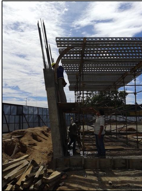
Figura N° 53: Presentación de la costillas de madera y andamios.
