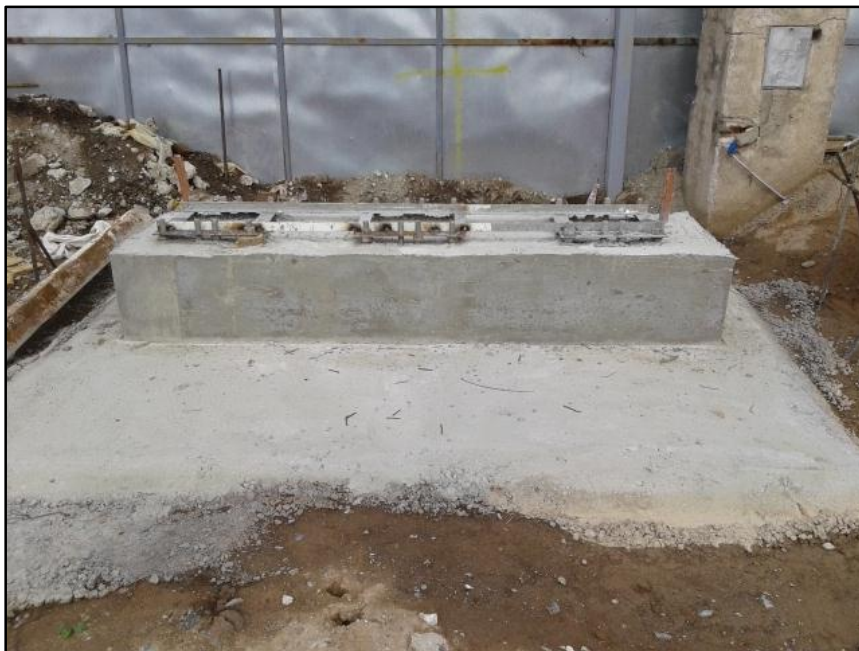
Figura N° 71: Cabezal desencofrado.
