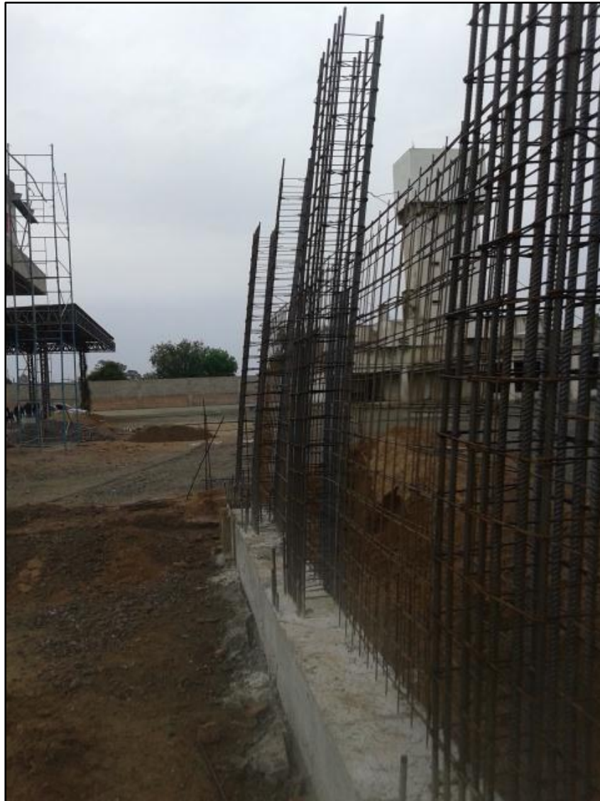
Figura N° 48: Viga hormigonada con el primer tramo de hierros longitudinales del tabique anclados.
