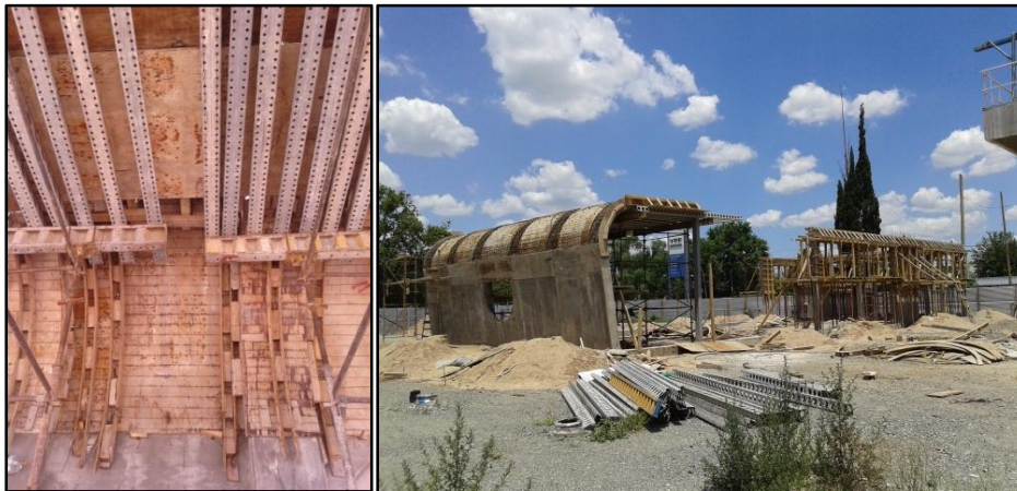
Figura N° 57: Resultado final de esta parte se obtuvo el siguiente encofrado de tabiques.
