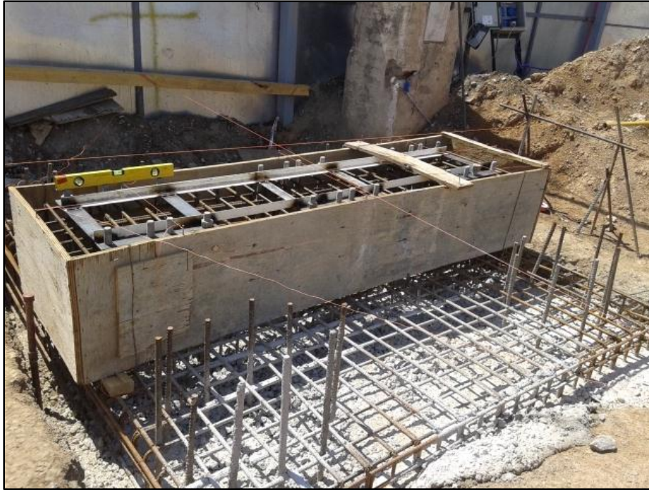
Figura N° 70: Fijación y replanteo de la segunda parte del cabezal.
