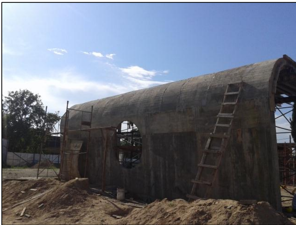
Figura Nº 64: Tabique desencofrado.
