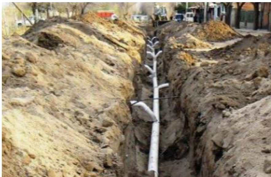
Figura 30 - Foto de cañería con conexiones domiciliarias (Fuente: http://www.rosarionoticias.gob.ar/page/noticias/id/26411/title/Avanzan-las-obras-de-cloacas-en-toda-la-ciudad#.V2wS0NLhDIU )
