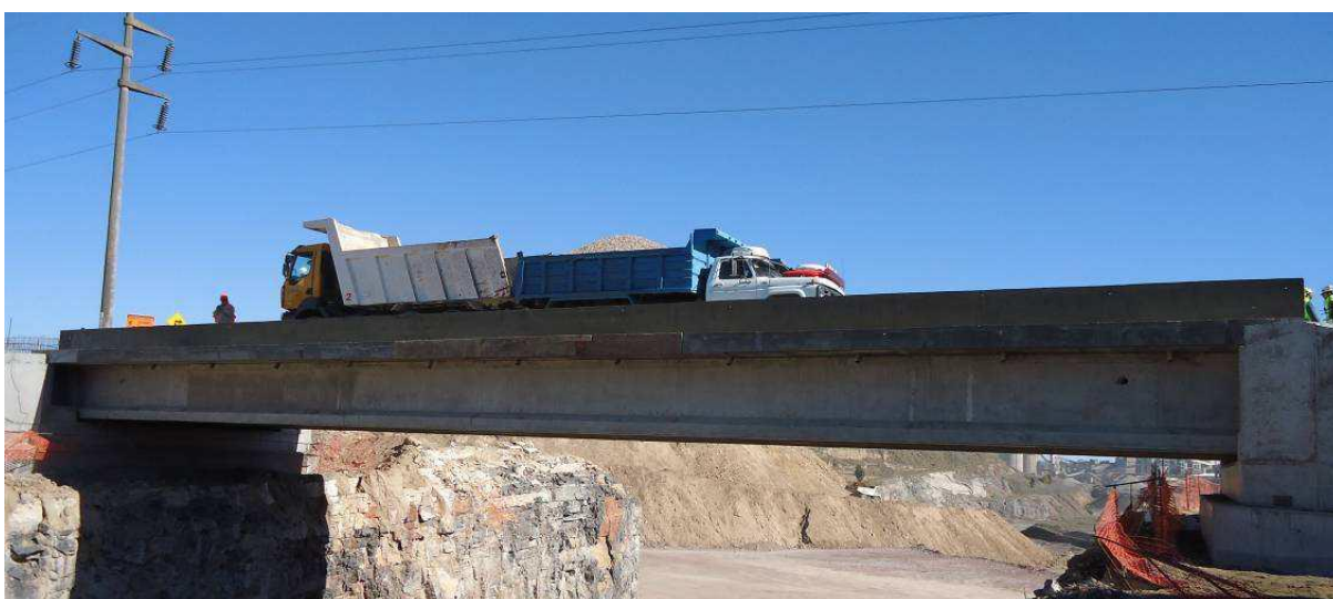
Figura 3: Instancia de la Prueba de Carga con 4 camiones (2do. Escalón de carga)
