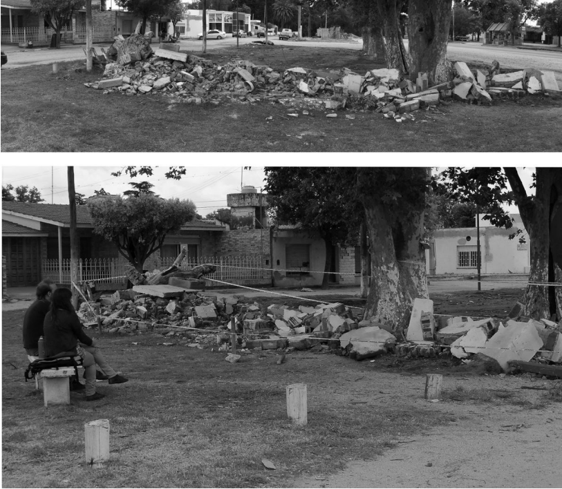
(Fig.7) Demolición del muro.
