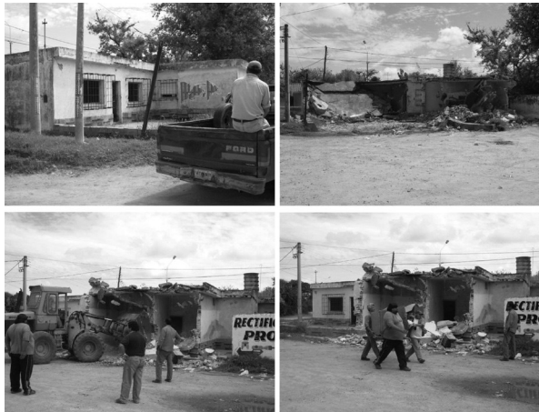
(Fig.2) La casa y su demolición.
