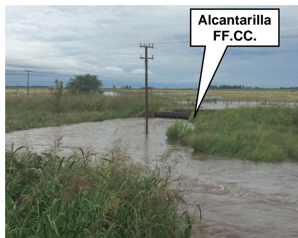
Ilustración 15. Alcantarilla sobre cauce del arroyo y vías de FF.CC.
