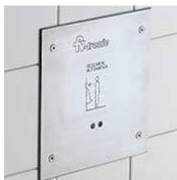
Figura 10.- Válvula electrónica para descarga de mingitorio
