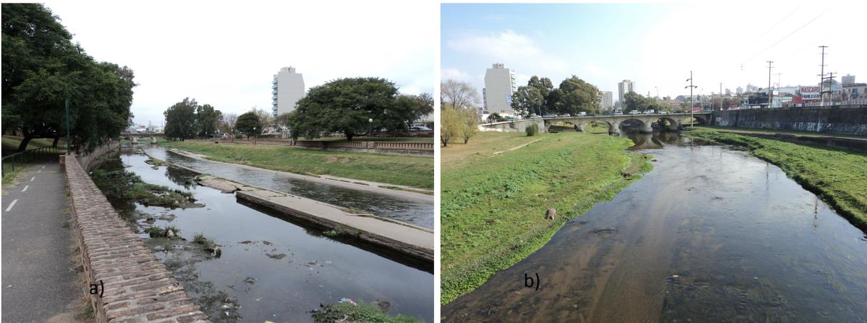
**Figura 4:** **a)** Erosiones en las márgenes y pérdida de la tolva entre el puente Antártida y puente Centenario. **b)** Sedimentación aguas abajo del puente Maipú.
