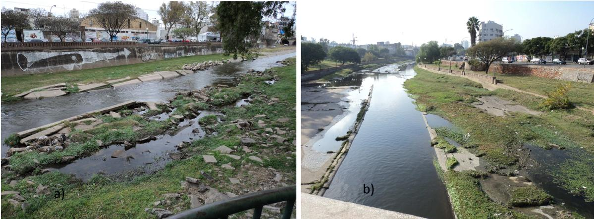
**Figura 3:** Erosiones en las márgenes y pérdida de la tolva entre: **a)** el puente Avellaneda y puente Antartida. **b)** el puente Centenario y puente Alvear.
