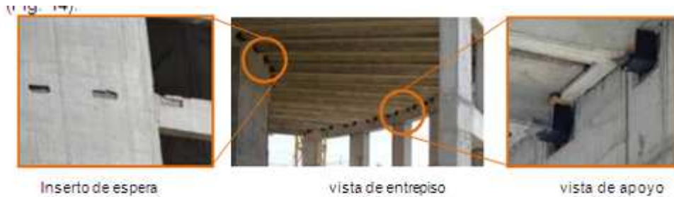
Fig. 13 – Materialización de la vinculación entrepiso tabique pórtico
