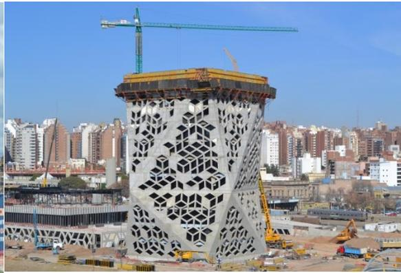
Figura 16: Encofrado auto soportado desde cota +20.30 a +44.70
