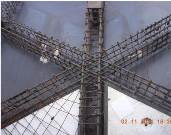
Figura 13: Nudos típicos pre ensamblados con Empalme de barras ADN-420S por medio de soldadura.
