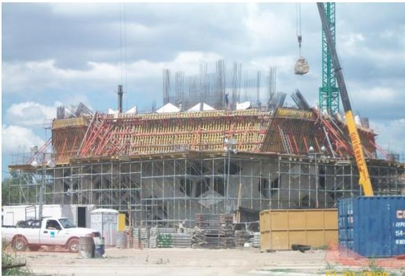
Figura 15: Encofrado soportado por torres hasta +20.30m.
