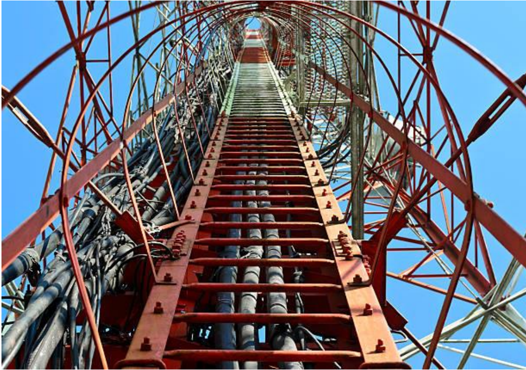
Figura 0.11. – Escalera de servicio y guías de onda
