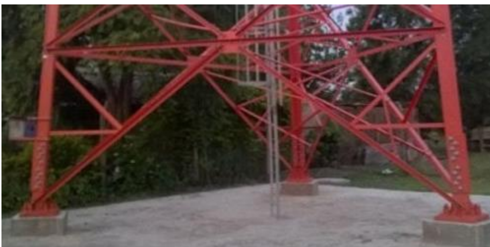
Figura 0.4. - Detalle de la base de torre autoportada
