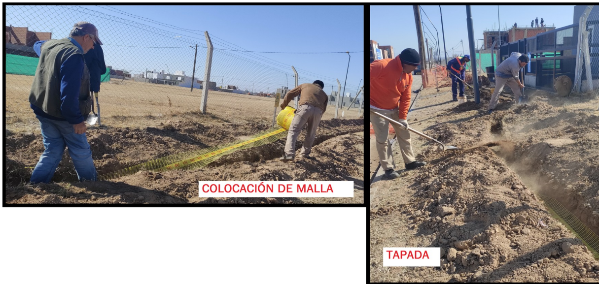
Figura 53: Colocación de malla y tapada de caño
