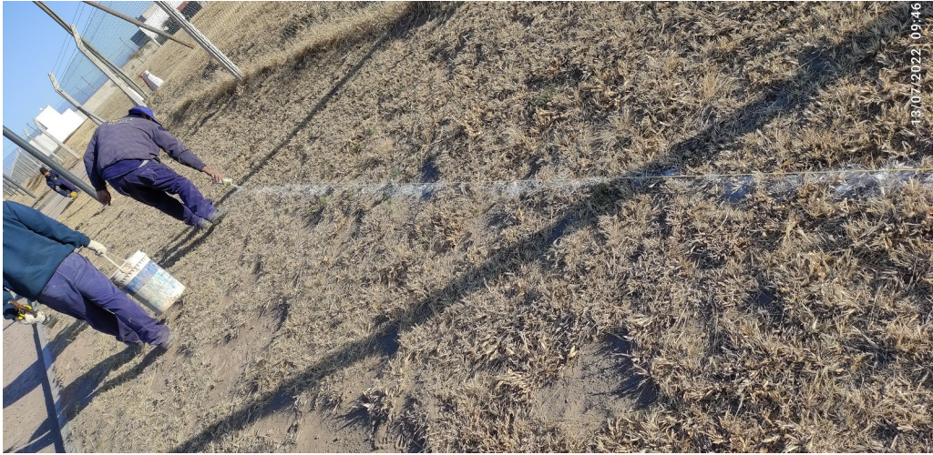
Figura 37: Colocación de cal sobre tanza
