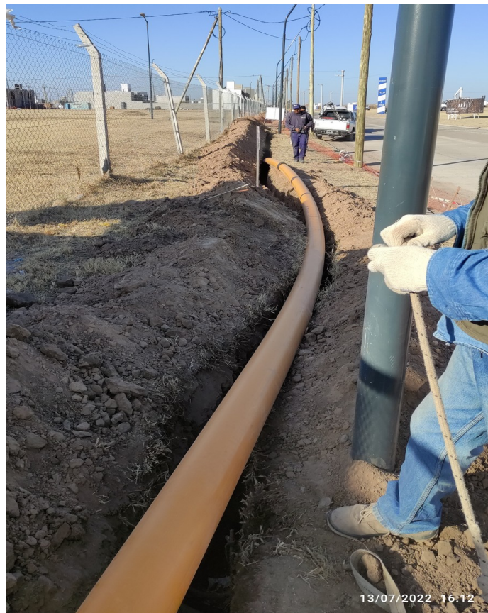
Figura 45: Alteración de la trayectoria debido caja EPEC
