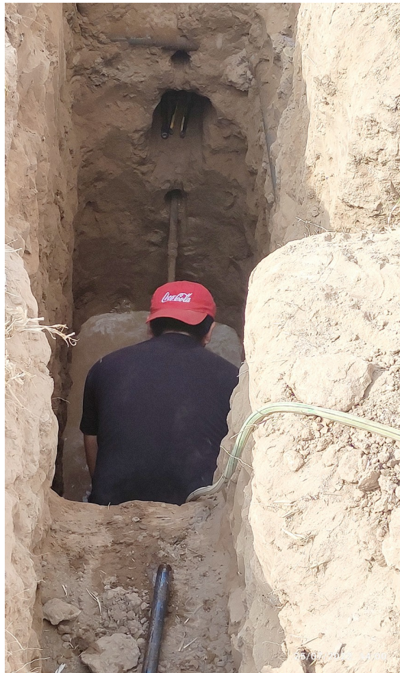
Figura 51: Operario realizando el conducto
