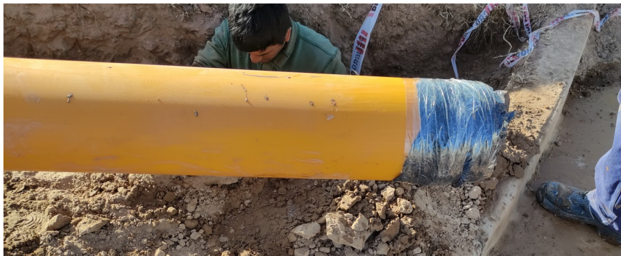
Figura 52: Cerramiento de extremo de caño
