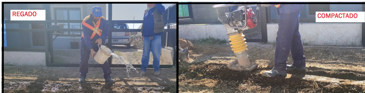
Figura 54: Regado y compactado del sueño
