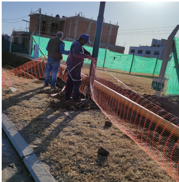
Figura 56: Cerramiento de la zona como medida de seguridad
