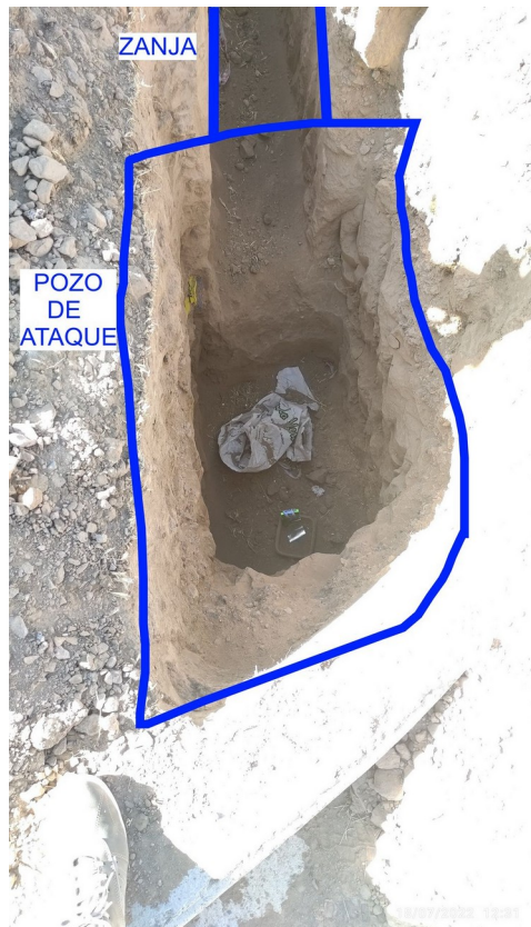
Figura 49: Pozo de ataque
