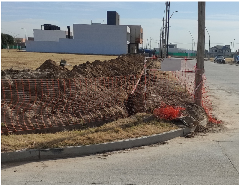
Figura 31: Excavación abierta de interferencia futura
