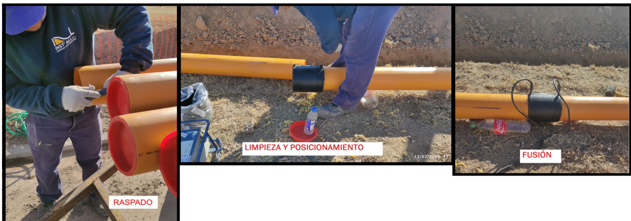
Figura 46: Procedimiento de fusión
