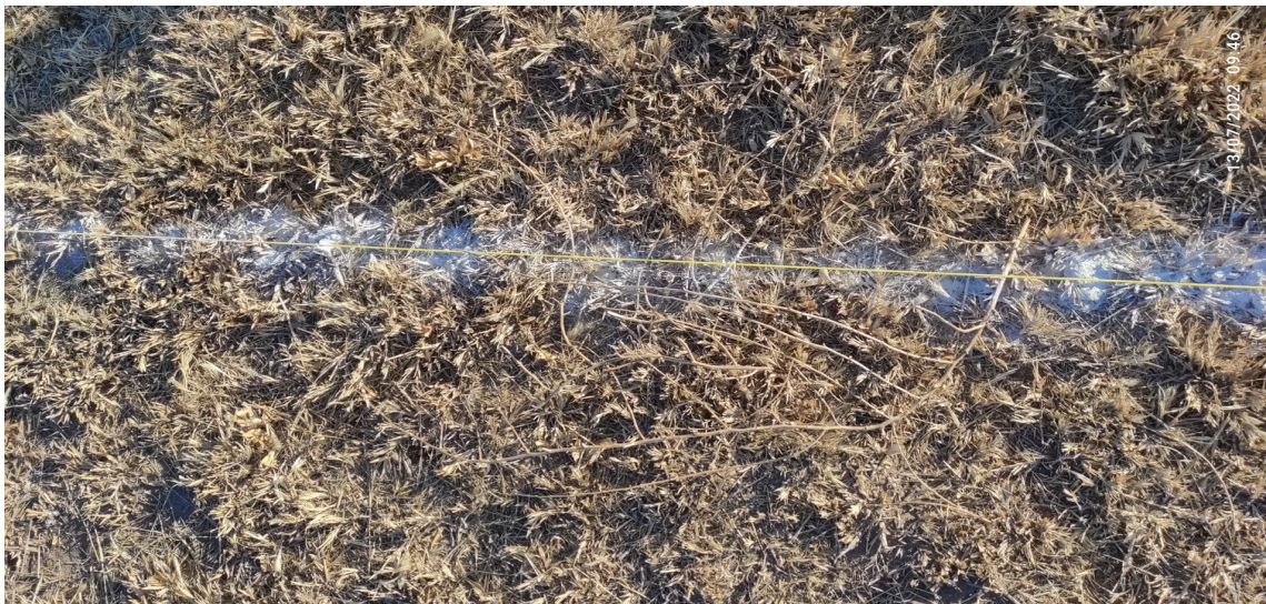
Figura 38: Detalle de marcado - tanza y cal
