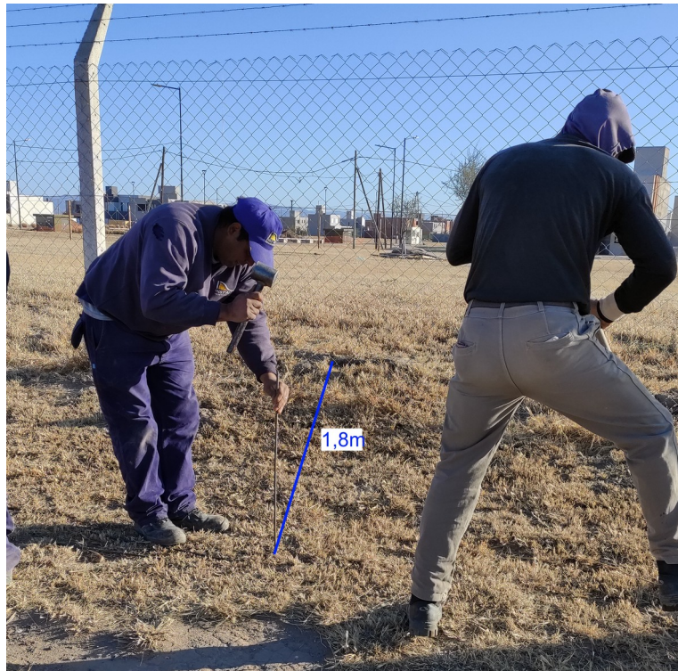
Figura 36: Disposición de hierro para marcado
