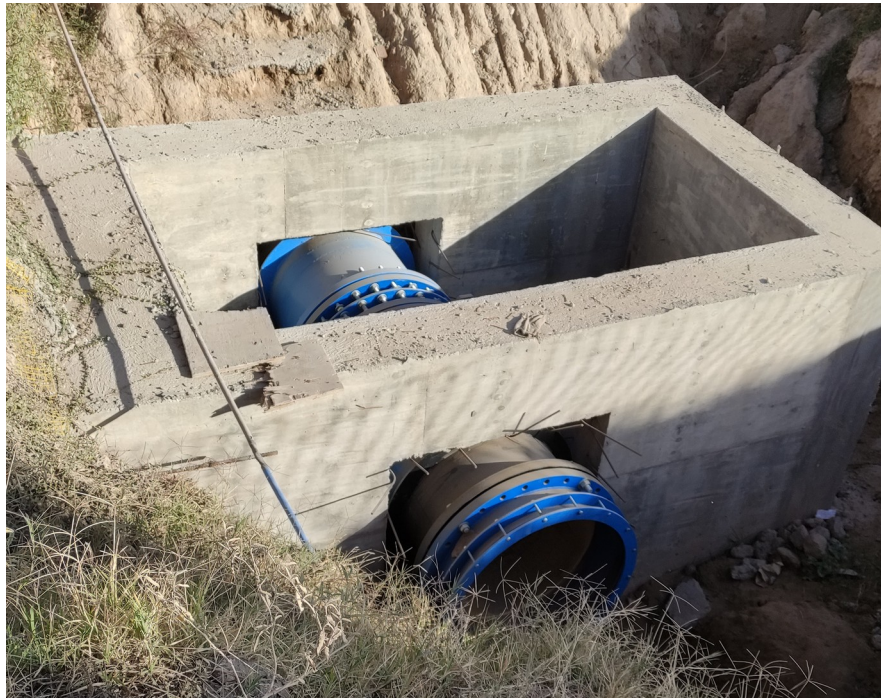
Figura 30: Caño de agua en recinto de hormigón
