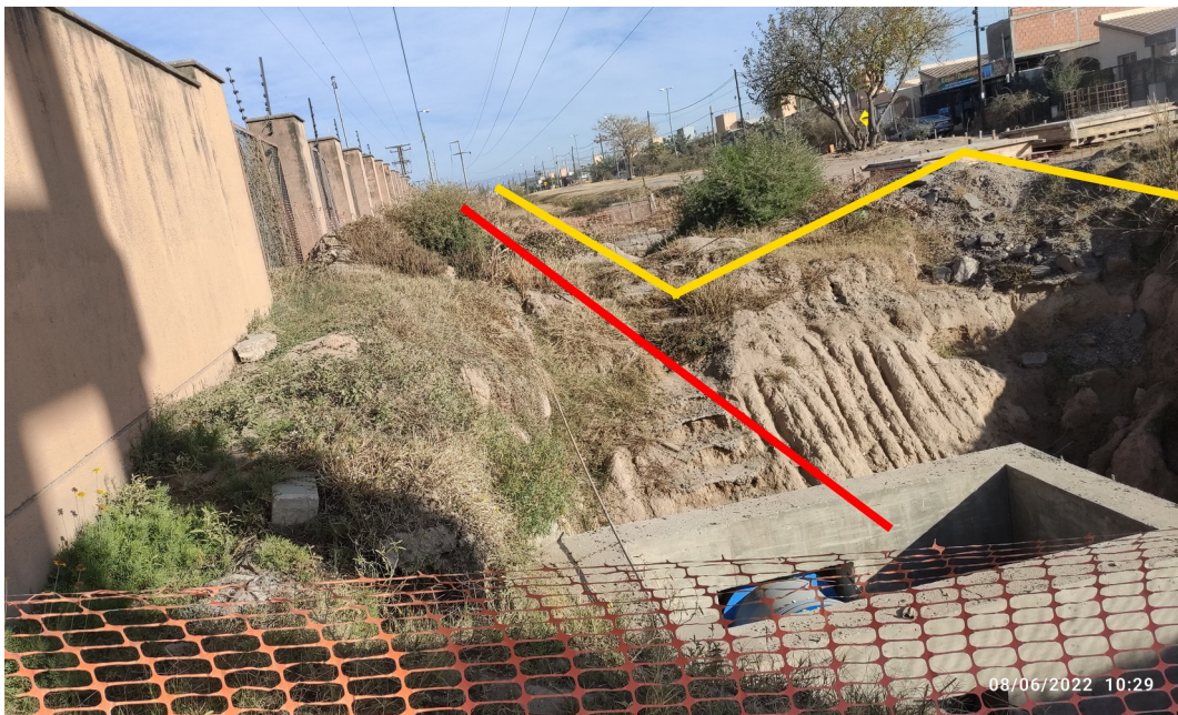
Figura 29: Excavación abierta - Interferencia de agua
