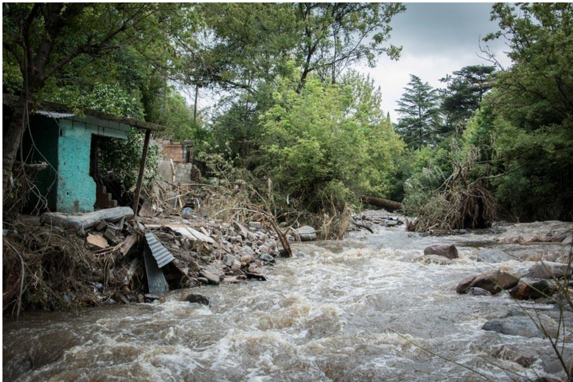
13 Imágenes de Colectivo Manifiesto de las inundaciones del 15 febrero de 2015.
