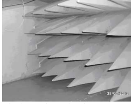
Fig. 8- Vista de los absorbedores 6x8=48 unidades
