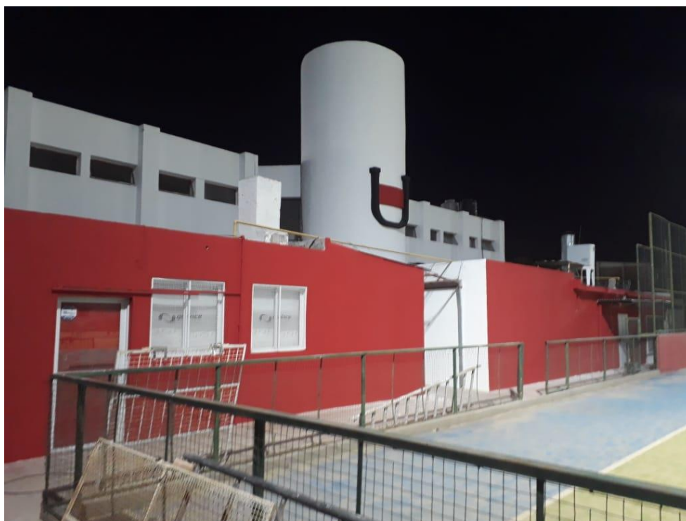
N.7. Tanque de agua y paredes laterales de los vestuarios. Fecha: 05/07/21.
