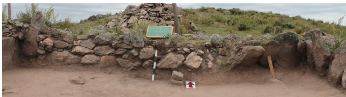
Figura 3.16. Muro de ET19.
