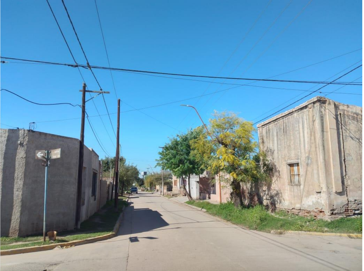
Imagen N° 39: esquina en barrio Madre Tránsito Cabanillas. Fuente: elaboración propia (2021).
