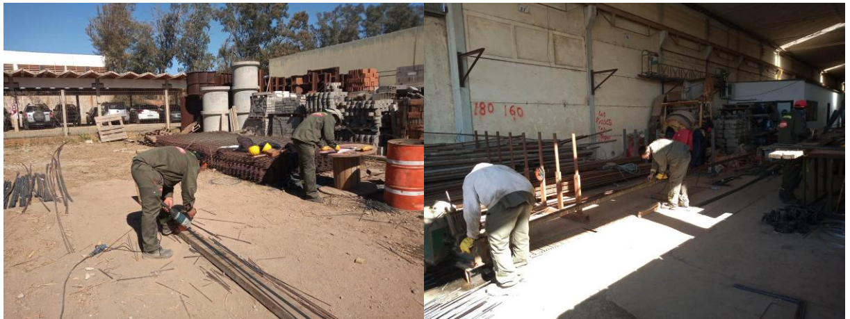
FIGURA N°45 – N°46 TAREA DE CORTE Y DOBLADO DE ARMADURAS EN PLANTA DE PRODUCCION
