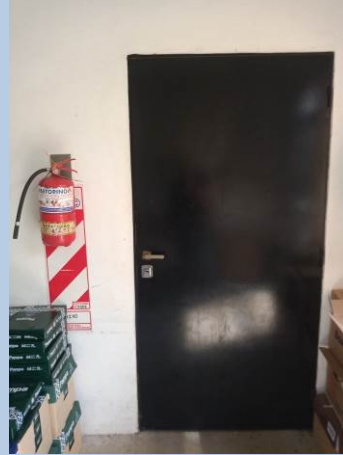
FIGURA N°43 – PUERTA DE INGRESO AL DEPÓSITO
