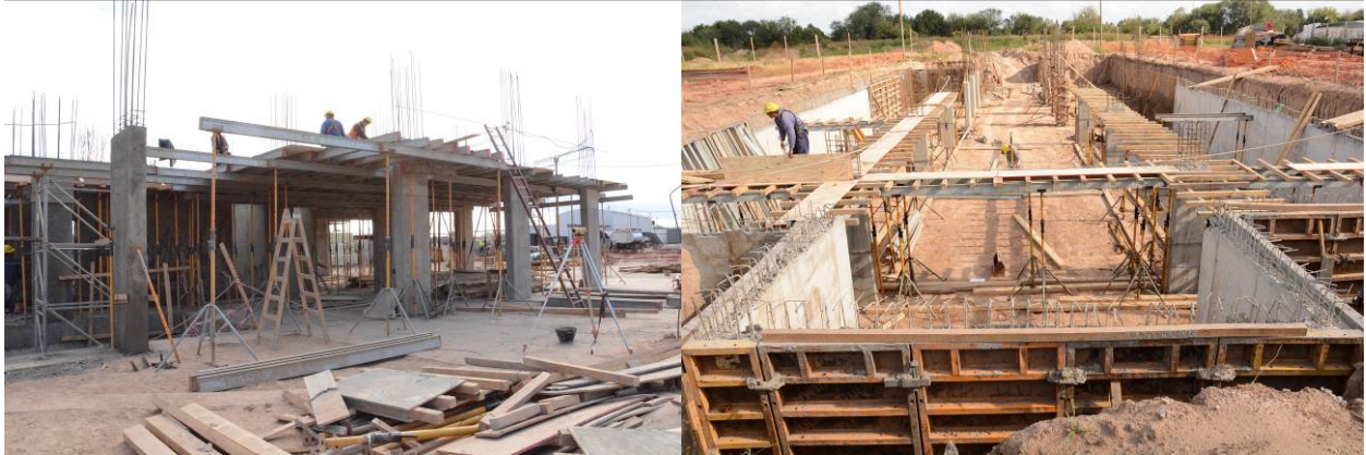
FIGURA N°47 – N°48 – ENCOFRADO PARA LOSA DE HORMIGON ARMADO
