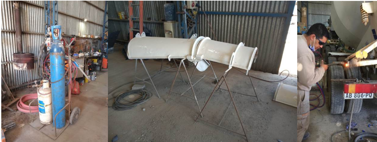
FIGURA N°49 – N°50 – N°51– EQUIPO DE SOLDAR A GAS OXICORTE, MANTENIMIENTO DE EQUIPOS, CHAPA Y PNTURA
