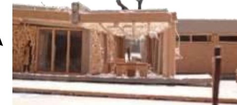
Muro vegetal + vigas voladas + carpintería metálica + pérgola metálica vegetal + planos transparentes + muros de cerramiento no portantes
