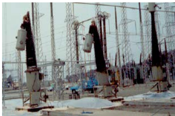
Figura 1: Daños causados en subestaciones por el terremoto de Loma Prieta del año 1989.
