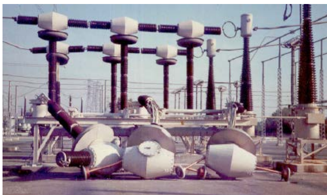
Figura 1: Daños causados en subestaciones por el terremoto de Loma Prieta del año 1989.
