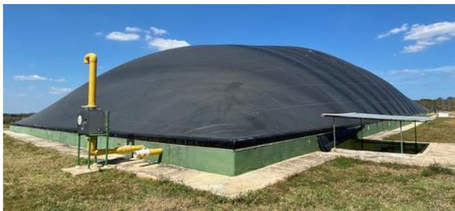
Figura 41. Imagen biodigestor tipo laguna cubierta. Google imágenes.
