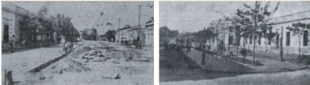
Figura 12: Construcción de la Rambla
