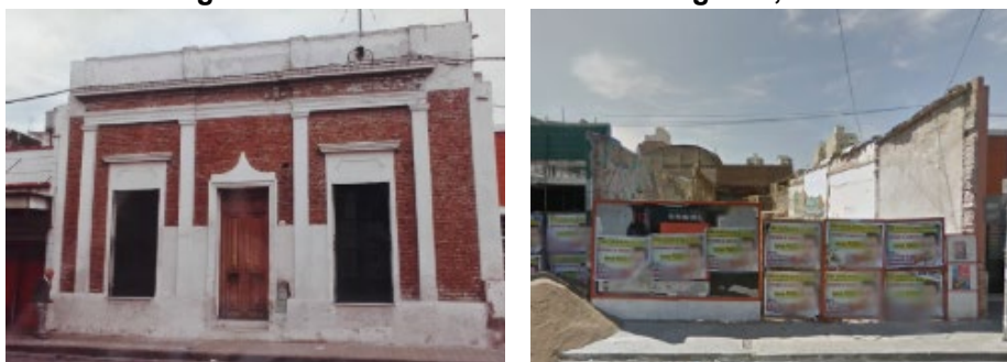
Figura 66: Demolición sobre calle Belgrano, 2007
