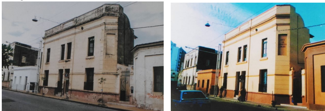
Figura 29: Revalorización del Convento San Francisco del Solano 1997-1998
