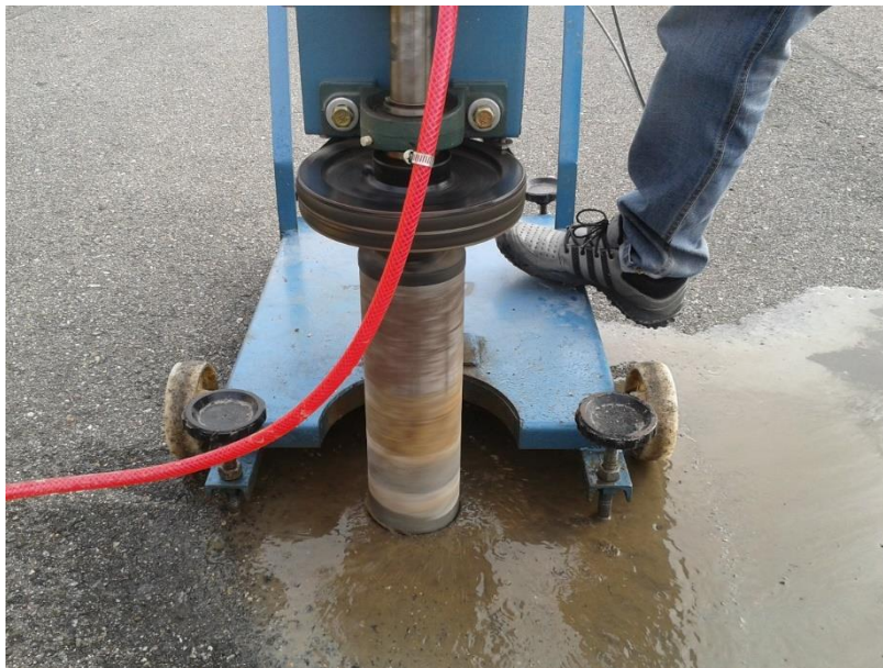
Figura 3-7. Extracción de testigo T13.
