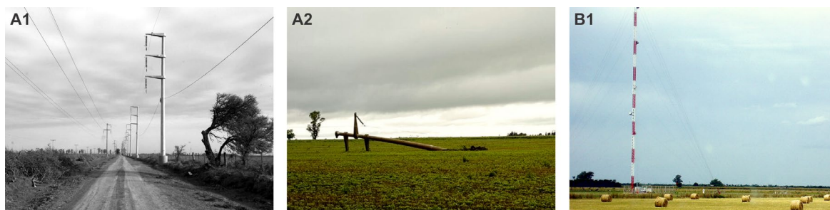
Figura 96. Paisaje de la infraestructura de la CLCA. 185 Elaboración propia en base a A1: Gieco SA (s.f.), A2: Gobierno de Santa Fe (2017) y B1: Google Earth-José Cuello.
