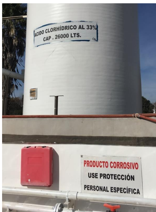
Ilustración 20: Almacenamiento del Ácido Clorhídrico.
