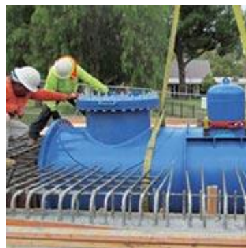
Ilustración 26: Colocación del LucidPipe™.
