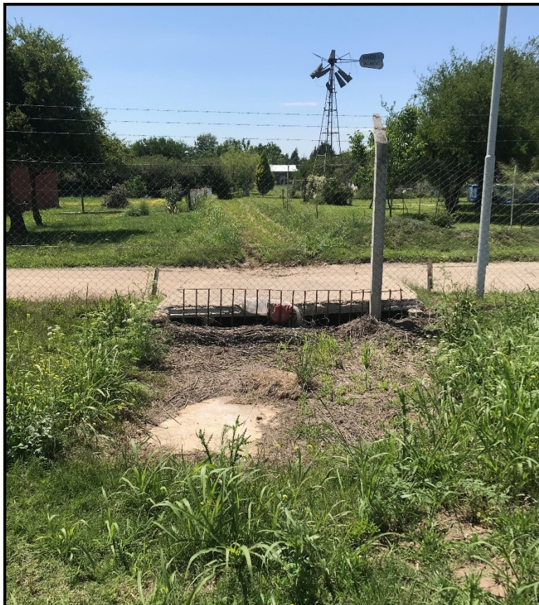
Figura 6.4. Boca de acceso a servidumbre de paso, hacia Estación del Carmen. Fuente: Elaboración propia.
