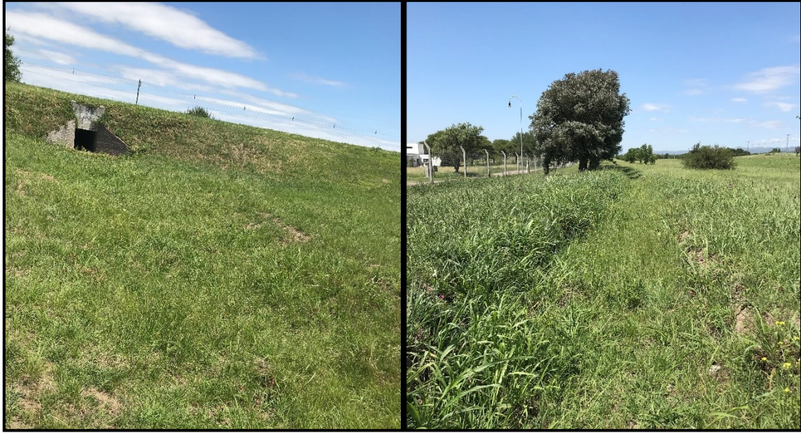
Figura 6.3. Canal trapezoidal sin revestir; Ancho de boca = 5,00m; Fondo = 1,30m. Fuente: Elaboración propia.
