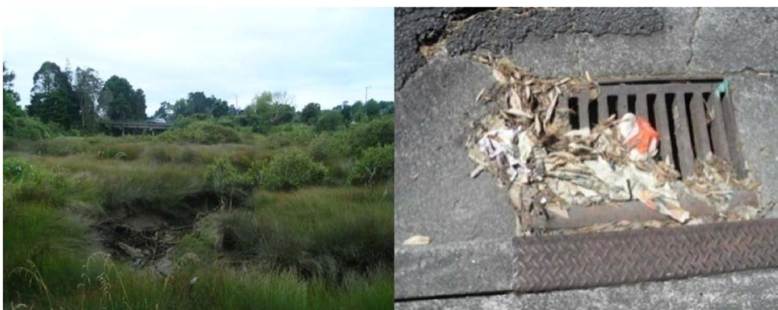
Foto I. Encharcamiento de agua con formación de lodo y rejillas sin mantenimiento.
