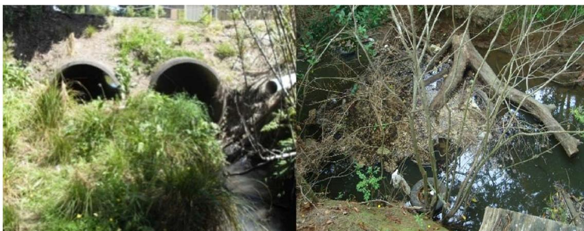
Foto J. Conducción del agua obstruido y barreras físicas evitando el flujo del agua.
