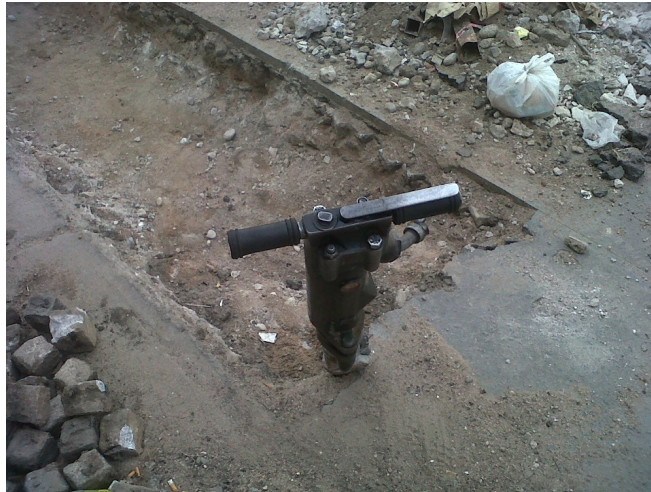
Figura 6.1: Aserrado y rotura de pavimento existente
