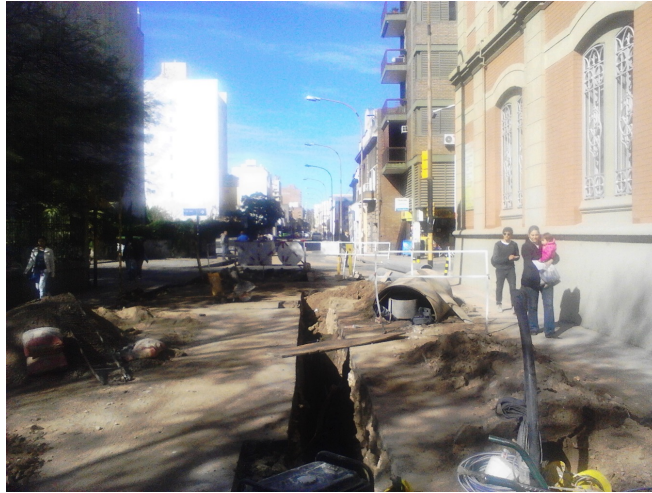
Figura 6.5: Zanja excavada
