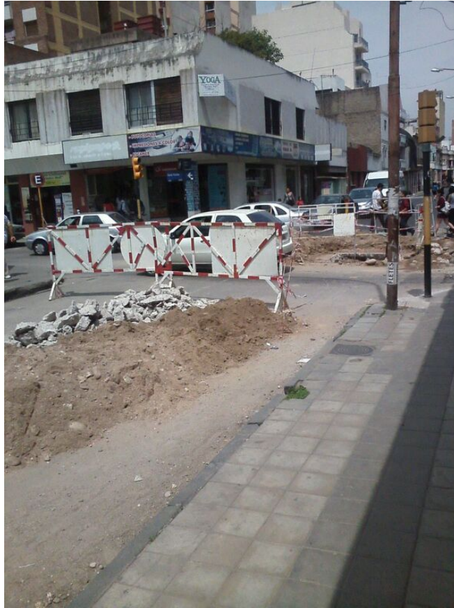
Figura 6.9: Zanja tapada
