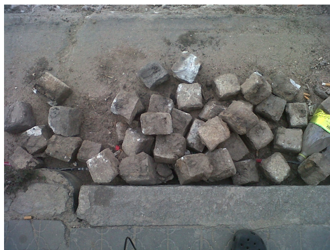
Figura 6.4: Material retirado de la antigua calzada
