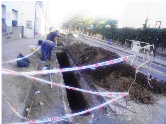
Figura 6.10: Instalación de cañería
