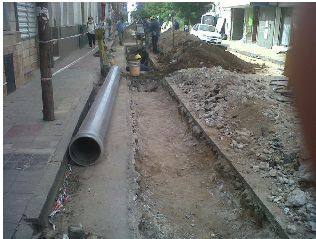
Figura 6.6: Excavación de zanja
